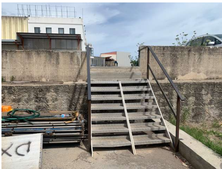
Collegamento pedonale tramite scala metallica con altra proprietà confinante sul lato Sud Est della proprietà
