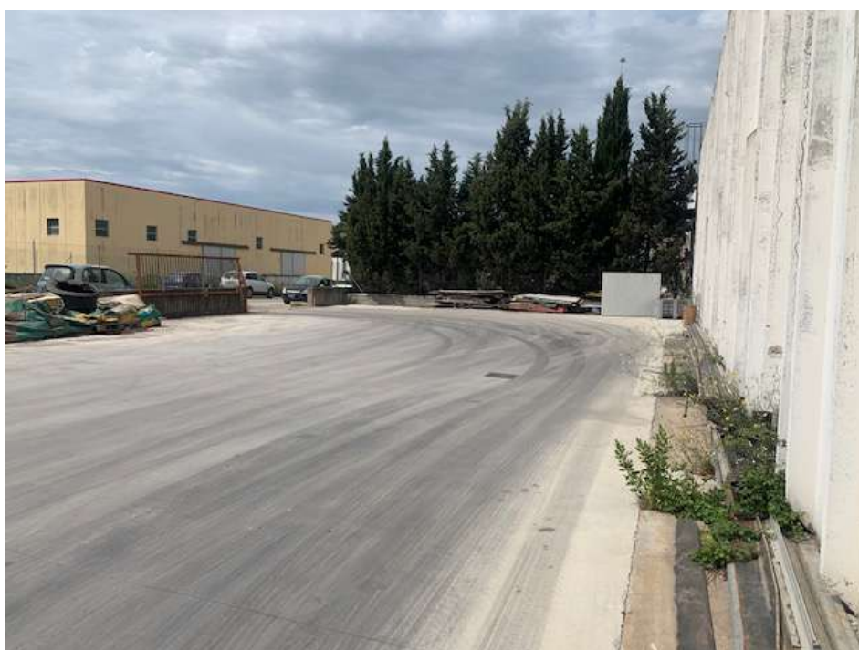
Ingresso carrabile sul lato Nord Ovest della proprietà che si affaccia sulla strada della Zona Industriale perpendicolare alla SS 131, realizzato tramite un cancello metallico scorrevole su binario;
