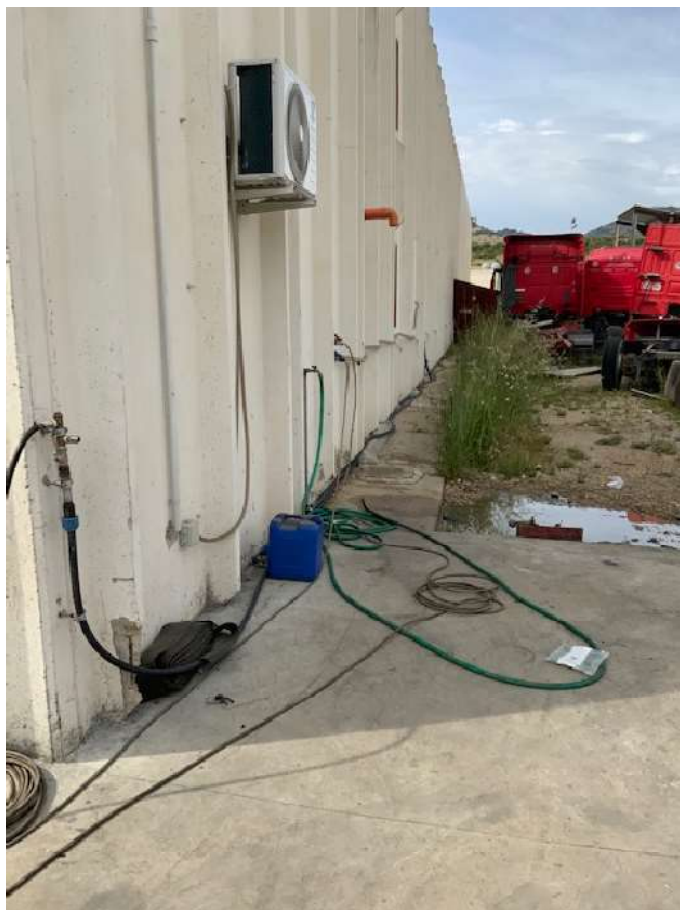
Capannone lato Sud Est
