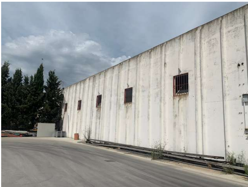
Capannone lato Nord Ovest
