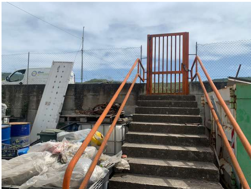
Ingresso pedonale sul lato Sud della proprietà, tramite un cancello metallico con scala in c.a. che si affaccia sulla strada della Zona Industriale parallela alla SS 131;
