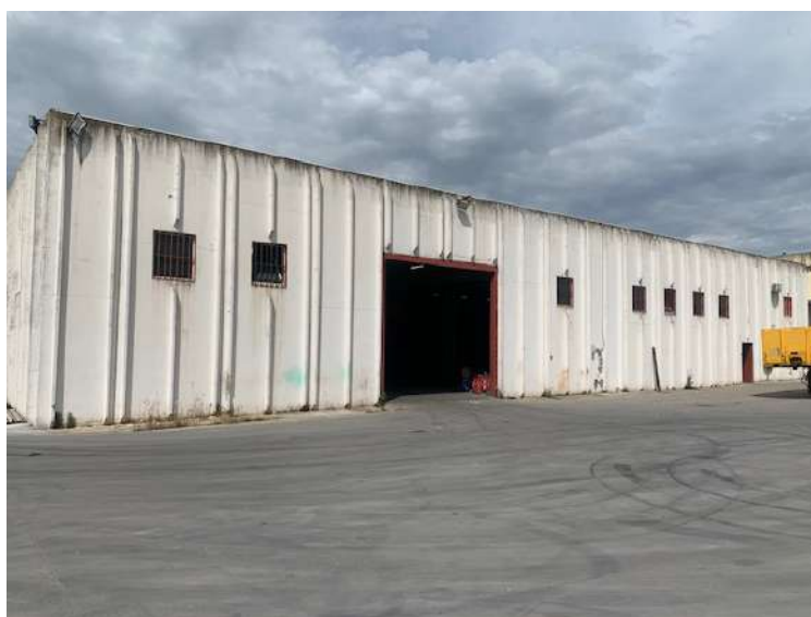
Capannone lato Sud Ovest
