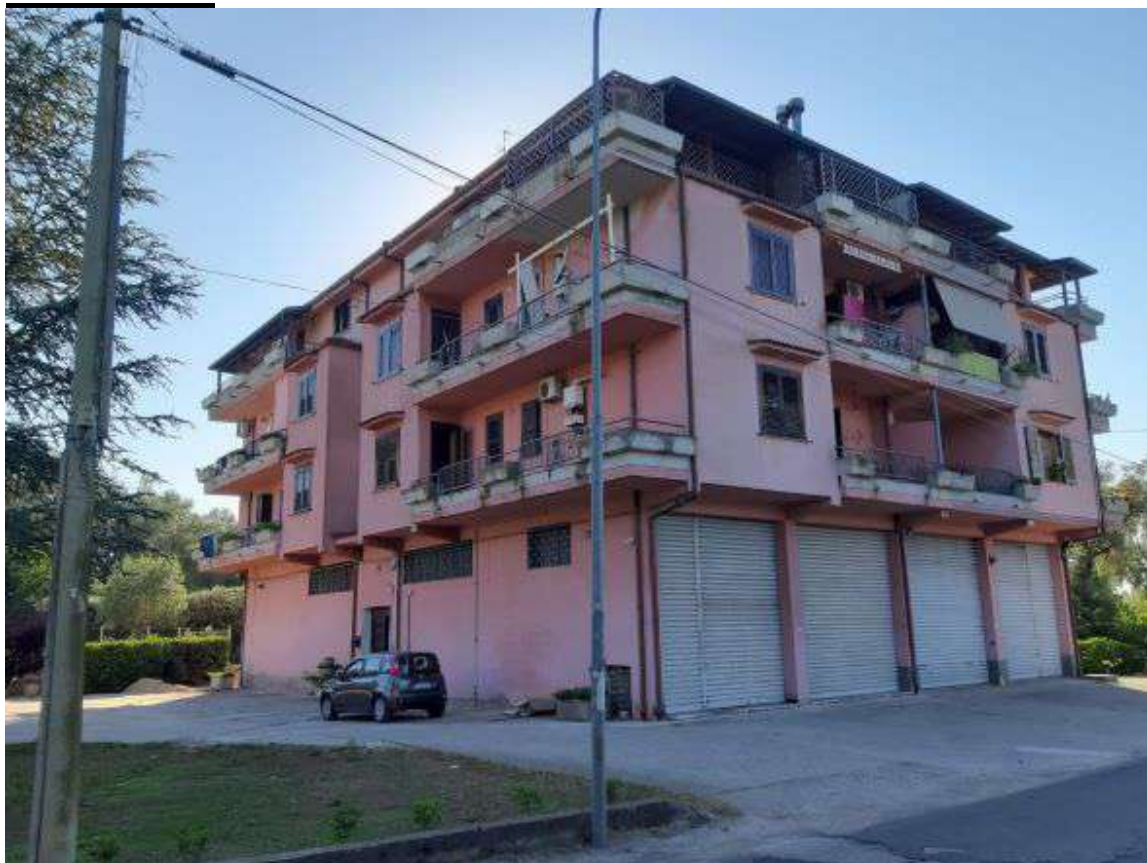
FOTO n. 4 Il Fabbricato visto nel suo insieme
