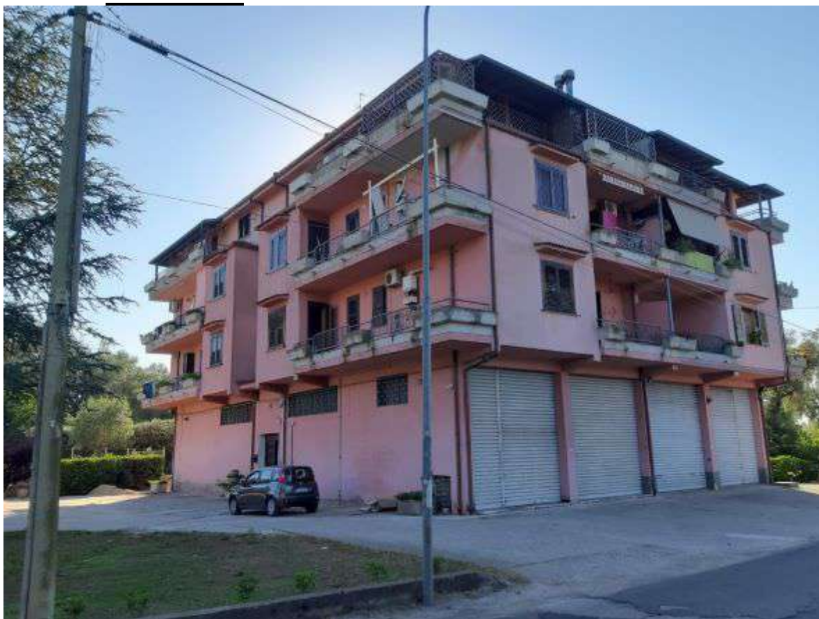
FOTO n. 4 Vista del fabbricato nel suo insieme
