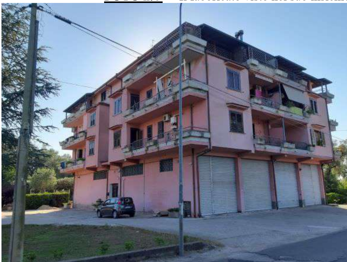
FOTO n.4 - Il fabbricato visto nel suo insieme
