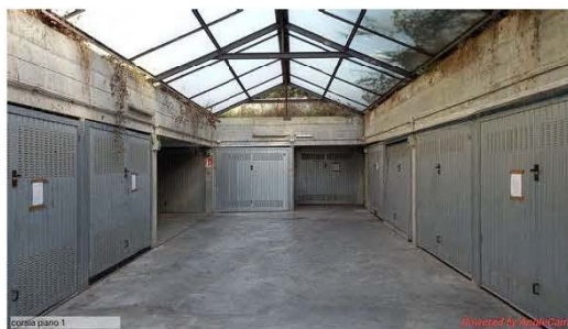
Corsia di manovra interna 2° livello autorimessa ( quota +14,00)
