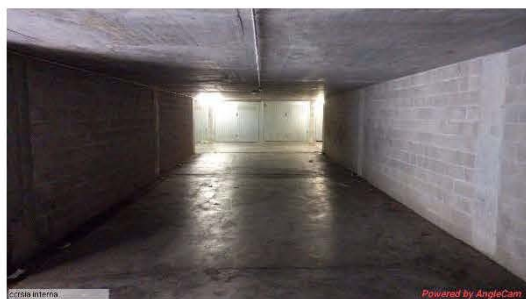
Corsia di manovra interna 1° livello autorimessa ( quota +11,00)
