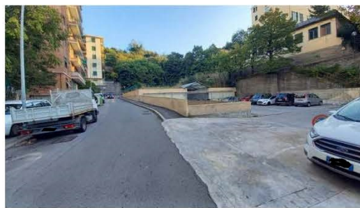
Accesso al 2° livello autorimessa ( quota +14,00)
