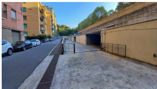
Accesso al 1° livello autorimessa ( quota +11,00)
