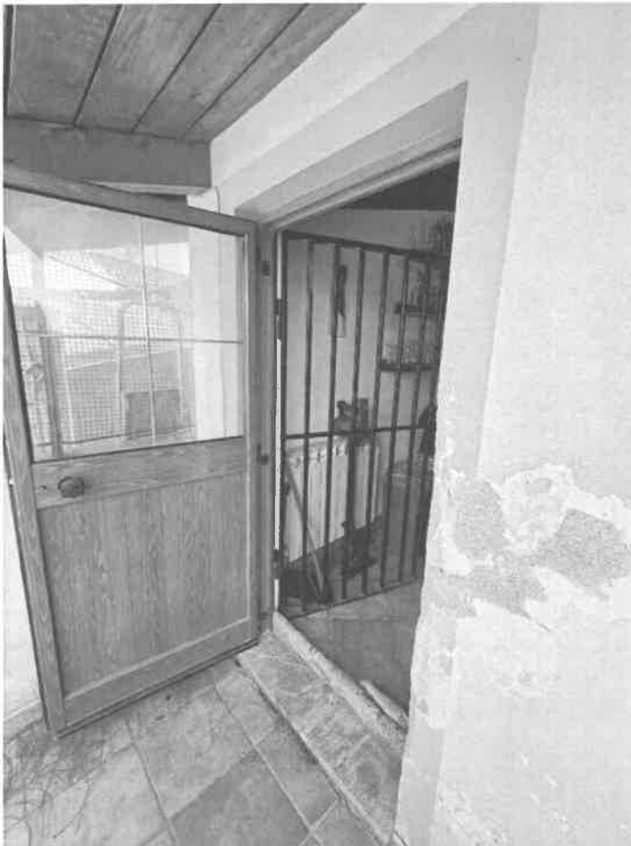
FOTO 20 esterno immobile corte lato ovest
