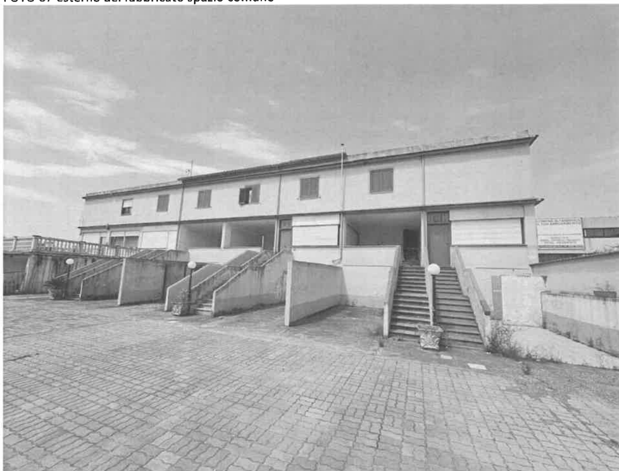
FOTO 07 esterno del fabbricato spazio comune
