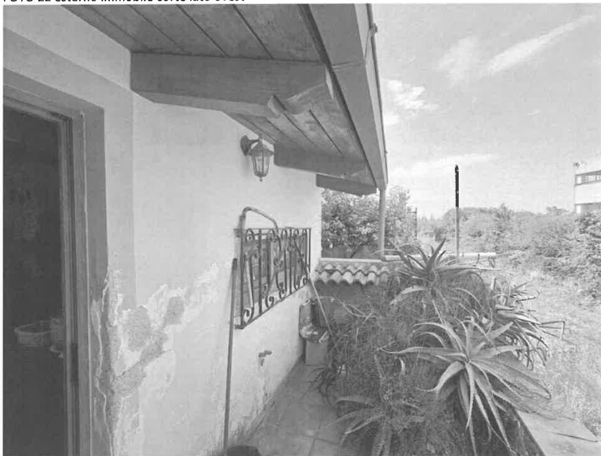
FOTO 22 esterno immobile corte lato ovest
