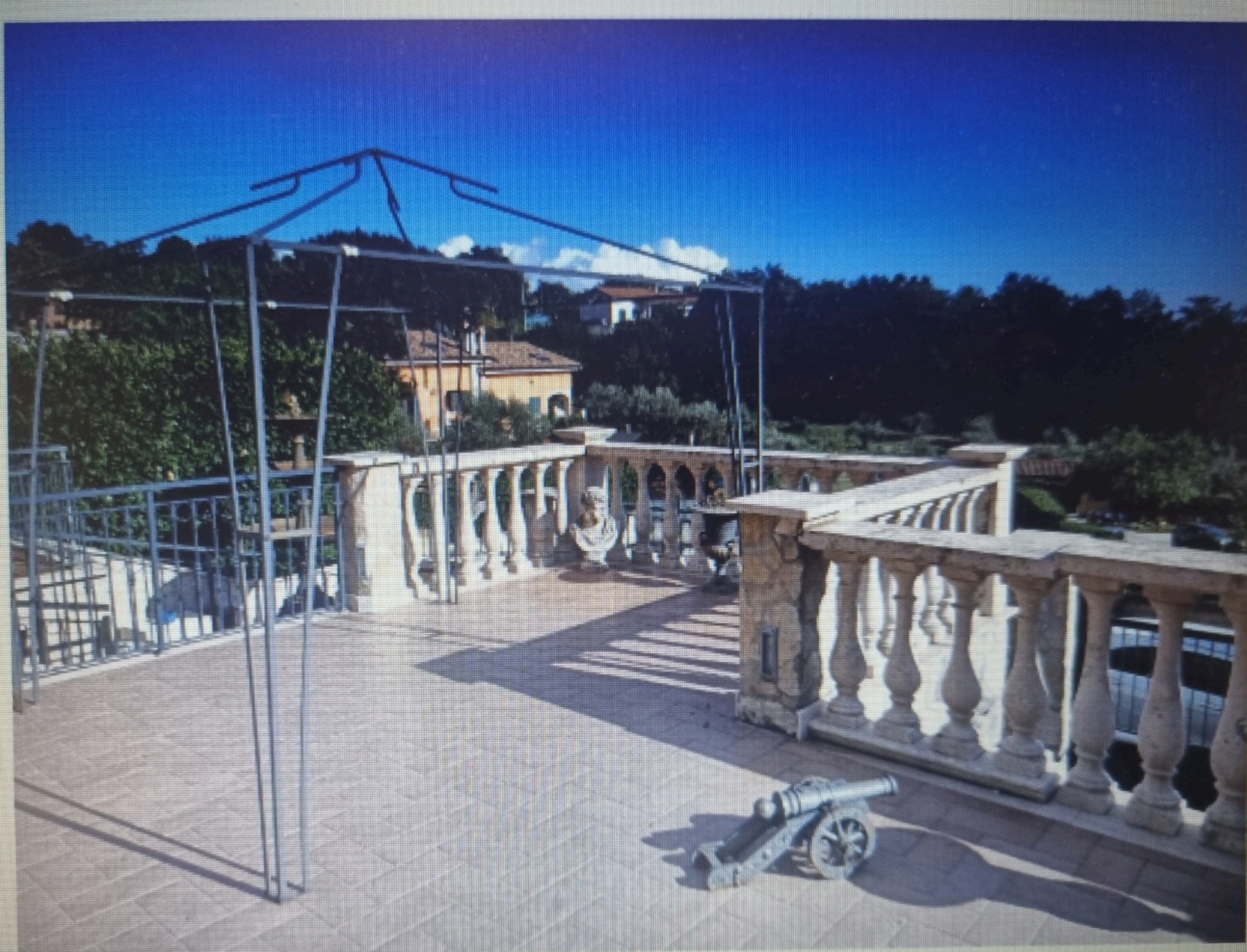
Foto 18. Vista esterna: piano rialzato, porzione di terrazza (lato strada)
