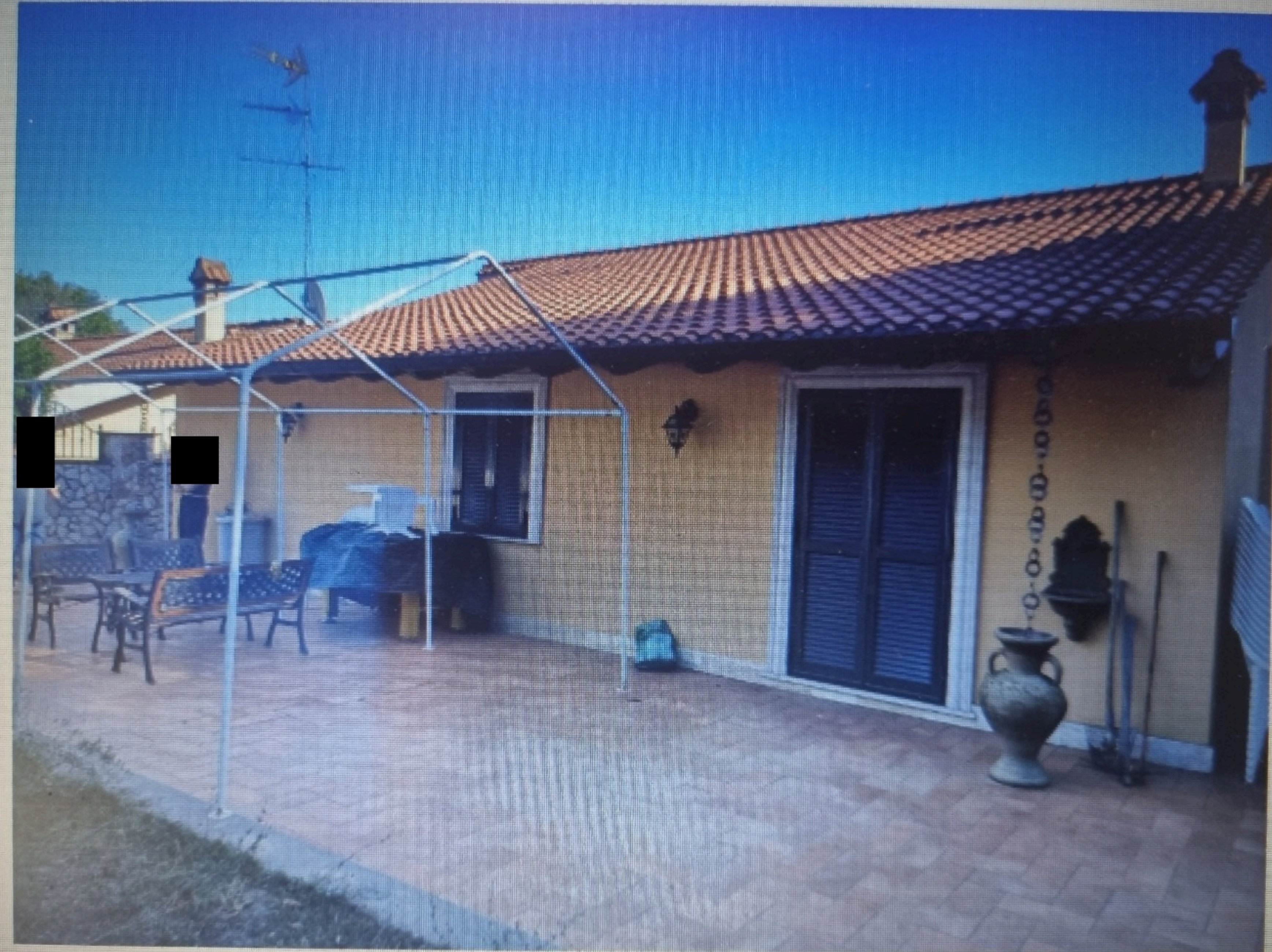
Foto 3. Vista esterna: piano rialzato, retro prospetto (porzione abusiva)
