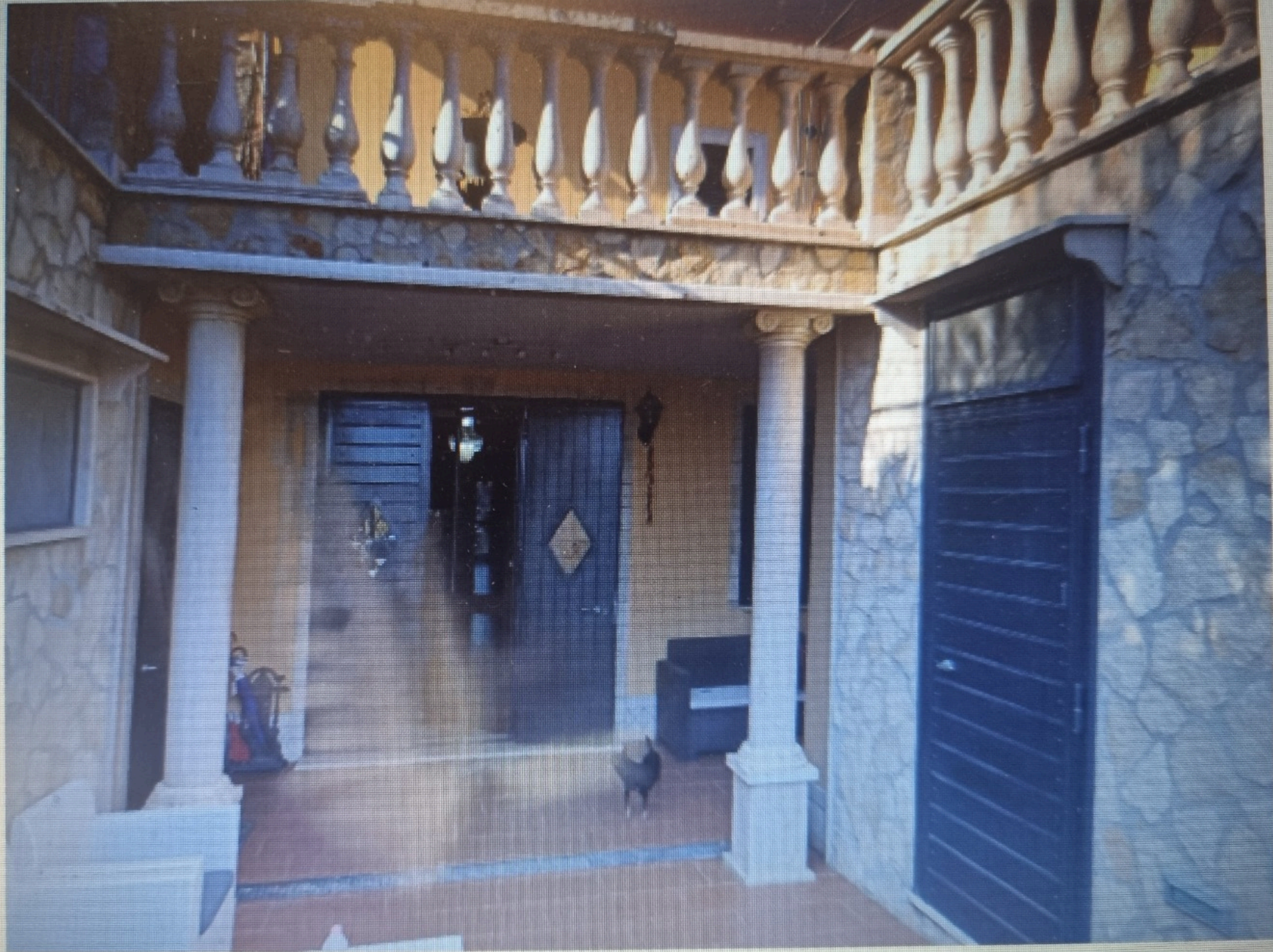
Foto 4. Vista esterna: ingresso principale al piano seminterrato
