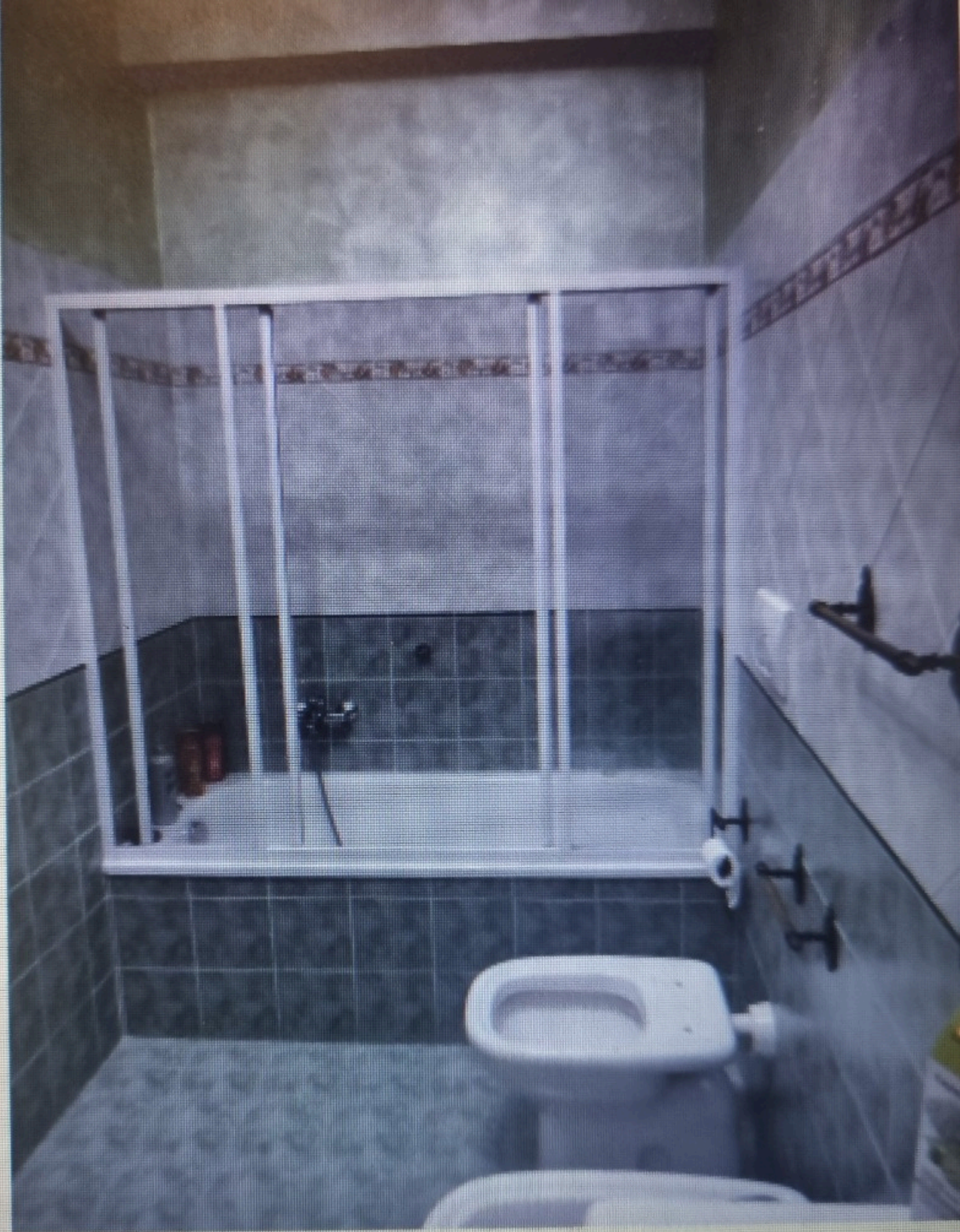
Foto 9. Vista interna: piano seminterrato_bagno
