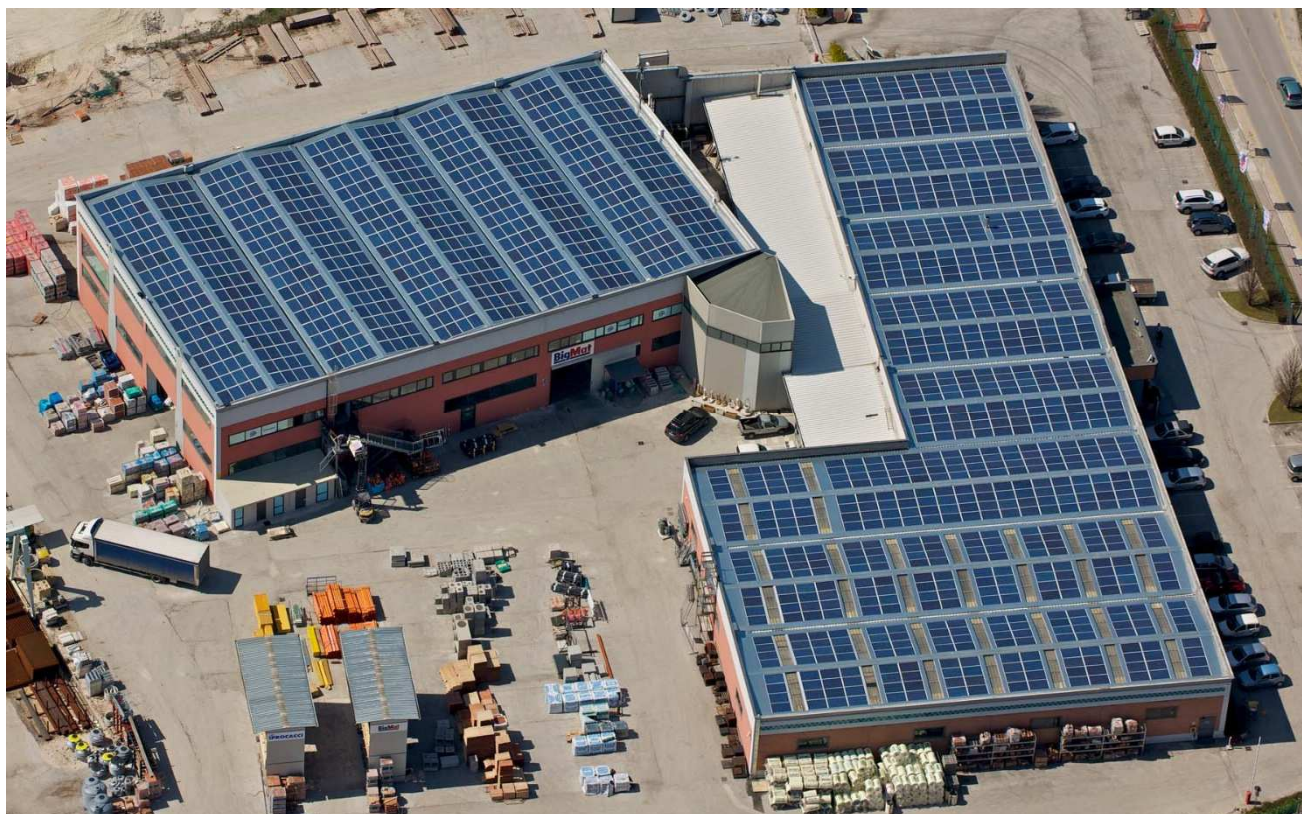
Foto aerea campo fotovoltaico: potenza di picco installata pari a 349,60 kW
