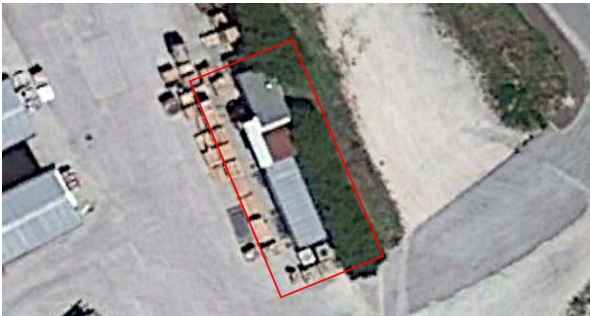
Vista satellitare zona cabine inverter e di consegna Enel (da Google Earth)
