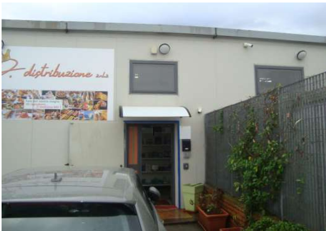
Foto n. 1 – Ingresso alla bottega (sub. 8)
