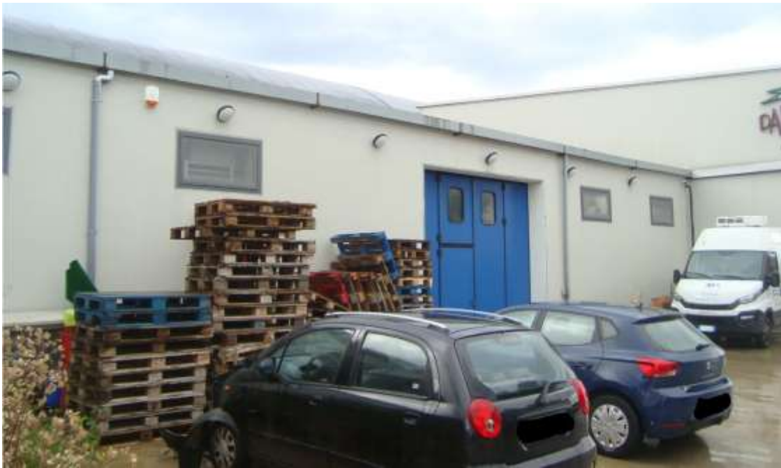
Foto n. 9 – fabbricato e corte esclusiva (sub. 9)
