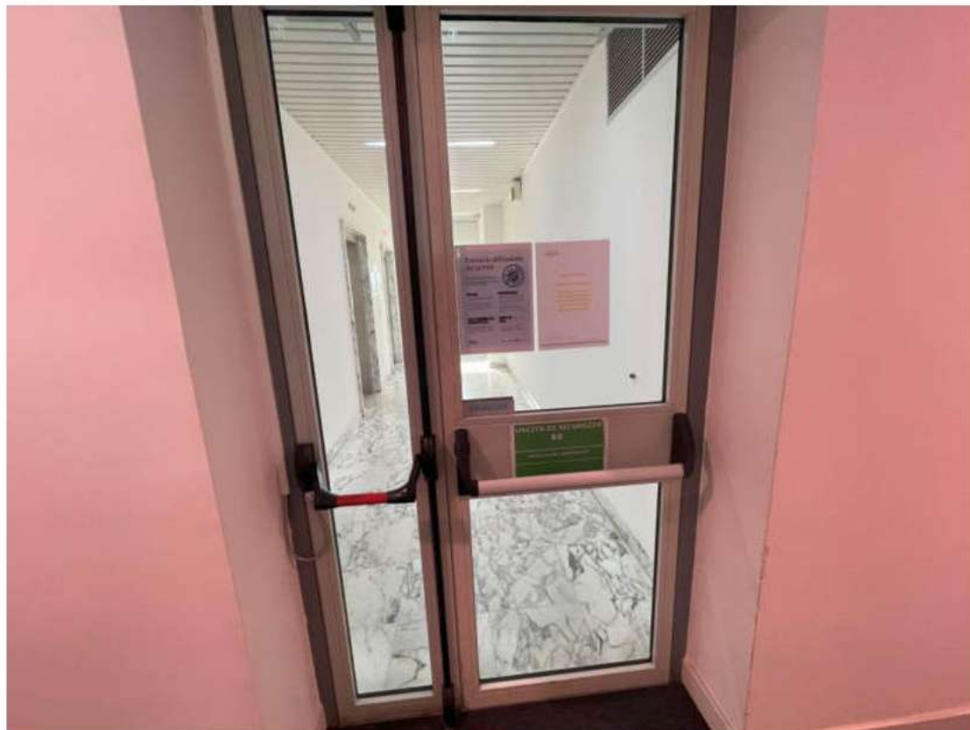
Ingresso ufficio da vano scala condominiale
