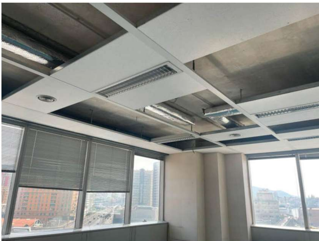
Porzioni di controsoffitto smontate
