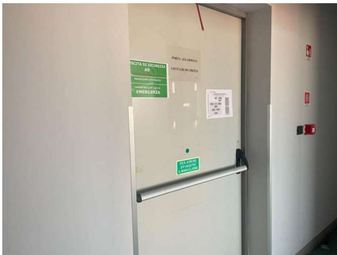
Secondo ingresso adibito ad uscita di emergenza
