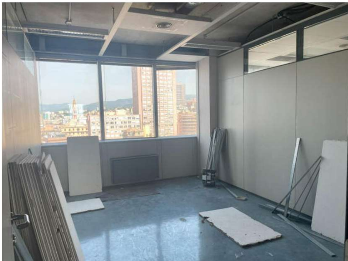
Porzioni di controsoffitto smontate
