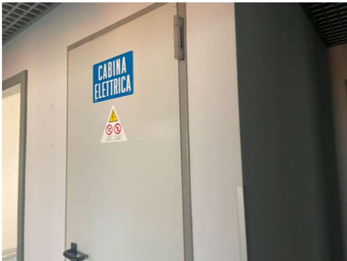
Ingresso cabina elettrica
