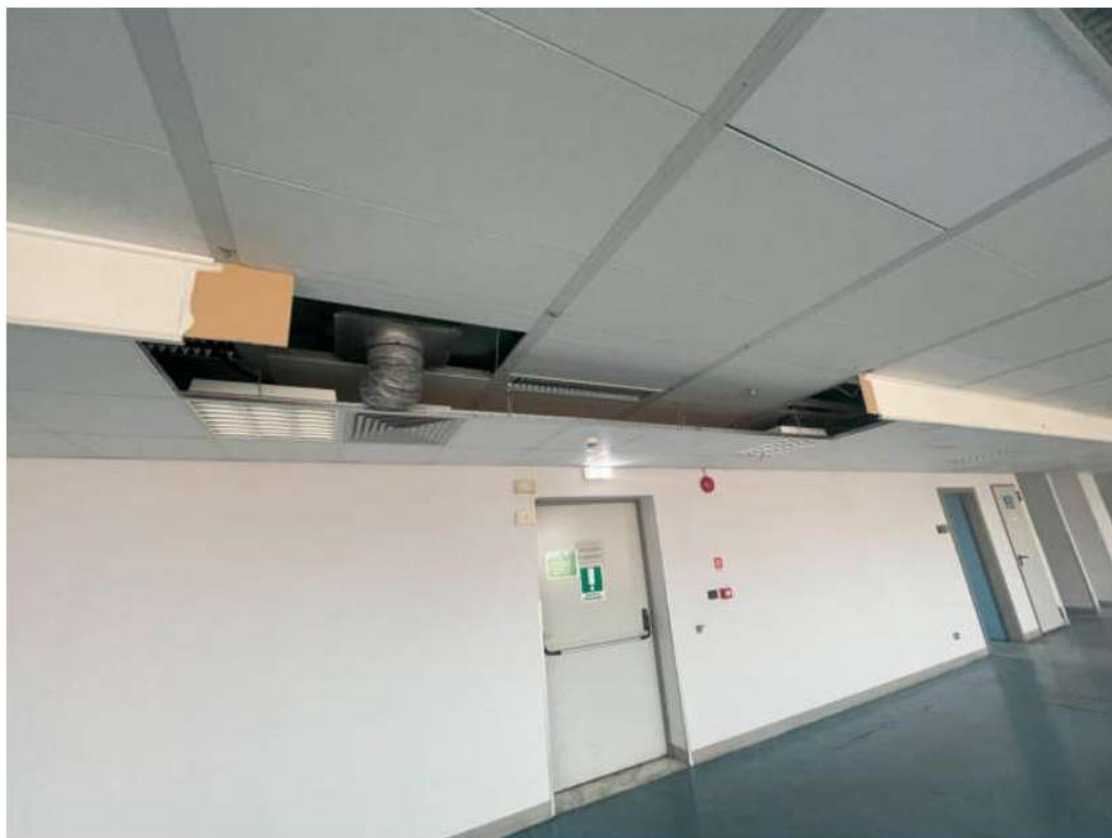
Particolare controsoffitto a quadrotti ispezionabile
