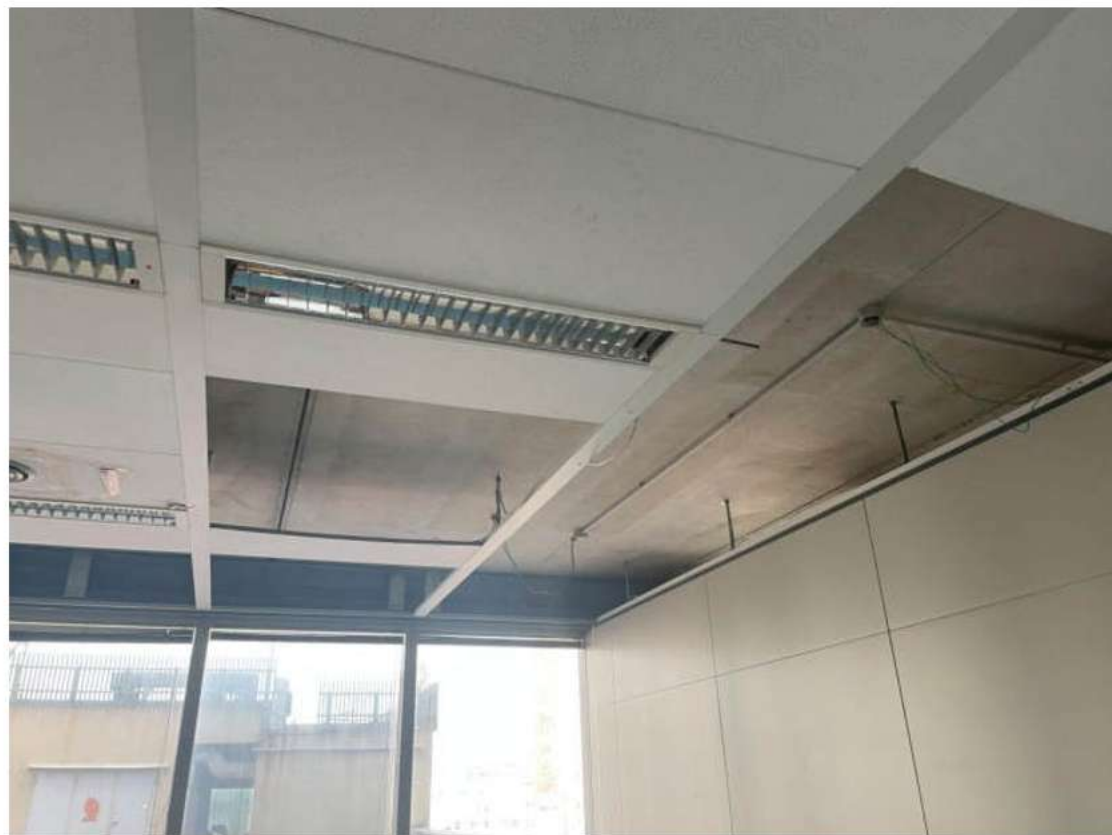
Particolare porzioni di controsoffitto smontate
