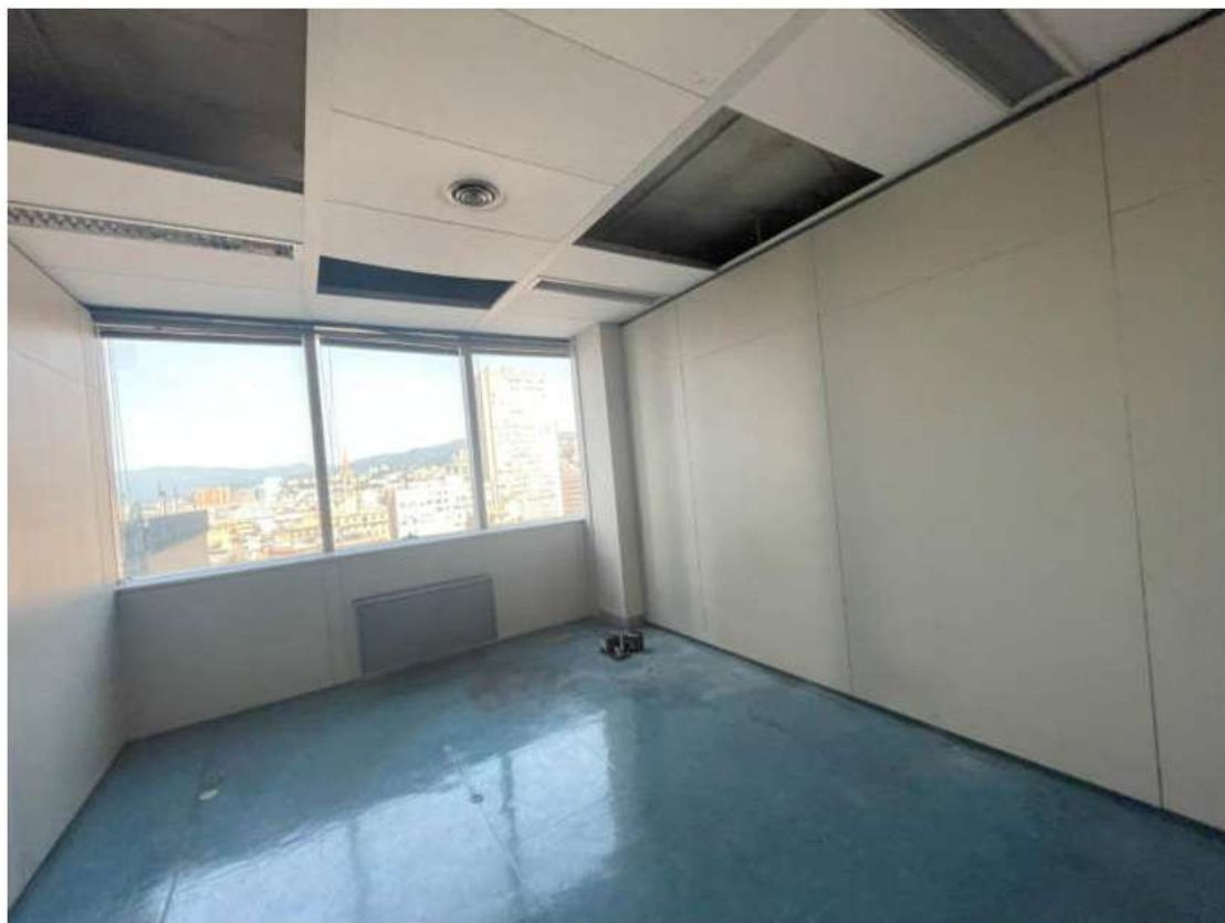
Porzioni di controsoffitto smontato
