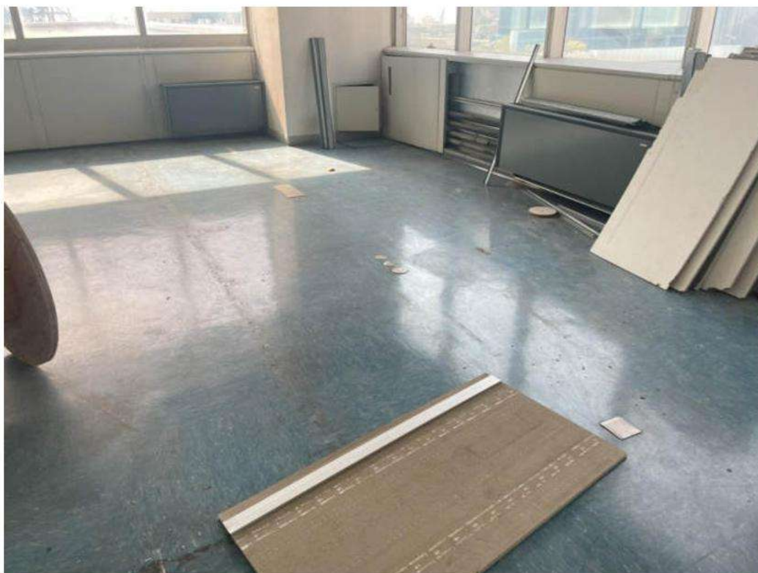
Pannelli controsoffitto smontati e accatastati
