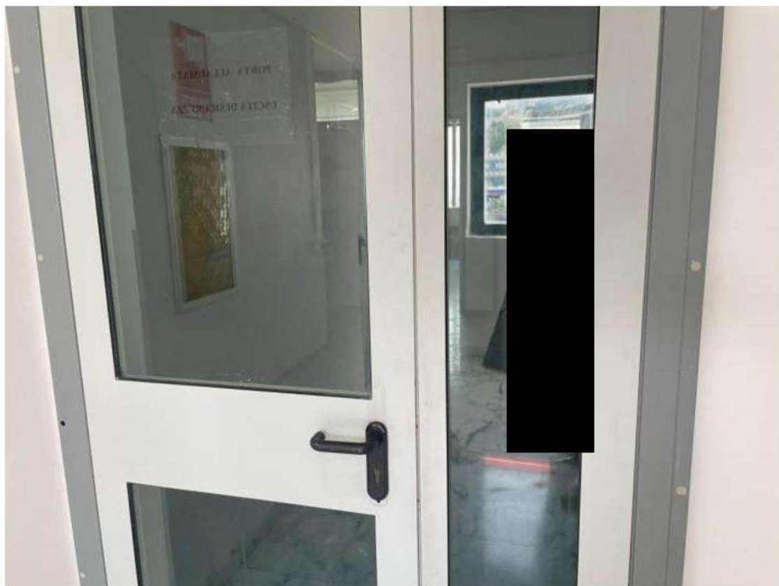
Ingresso ufficio da vano scala C
