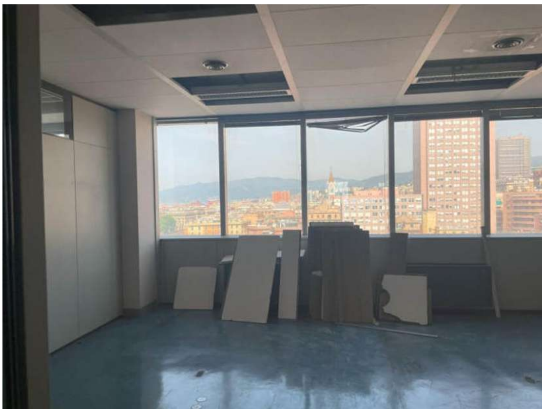
Pannelli controsoffitto accatastati nei locali
