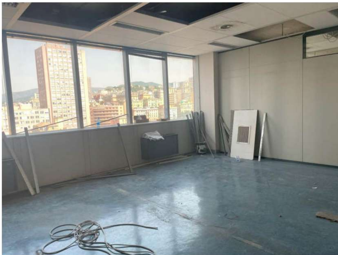
Porzioni di controsoffitto smontate
