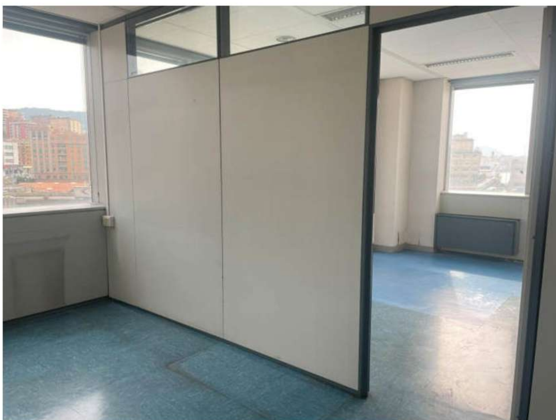
Particolare pareti di compartimentazione uffici
