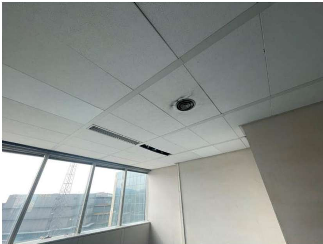
Particolare controsoffitto a quadrotti ispezionabile
