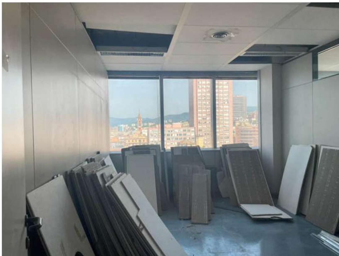
Pannelli controsoffitto accatastati nei locali
