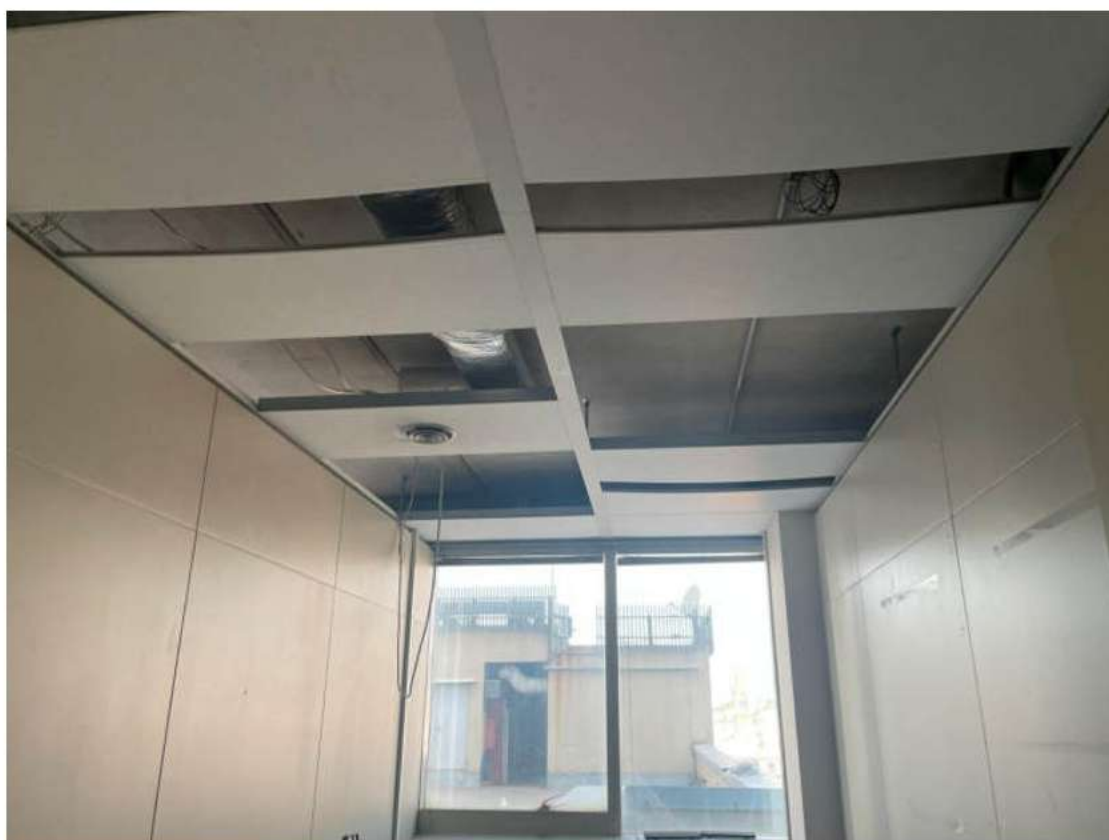
Particolare porzioni di controsoffitto smontate
