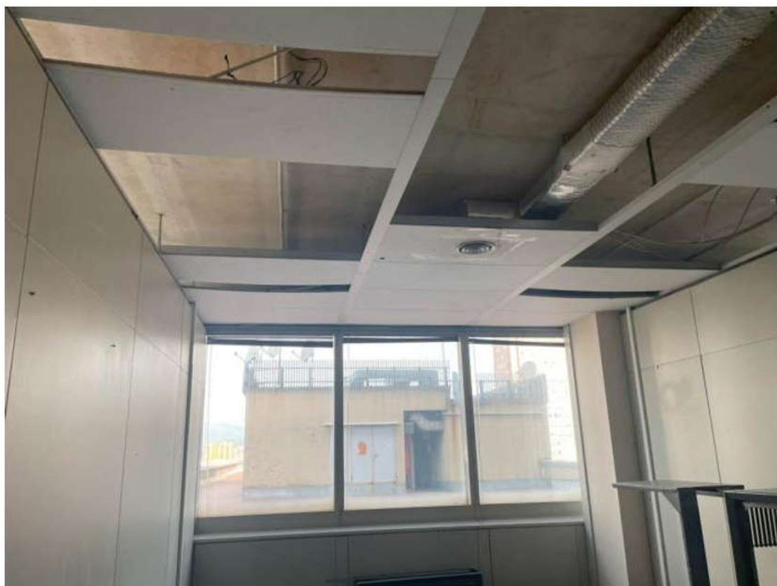
Particolare porzioni di controsoffitto smontate
