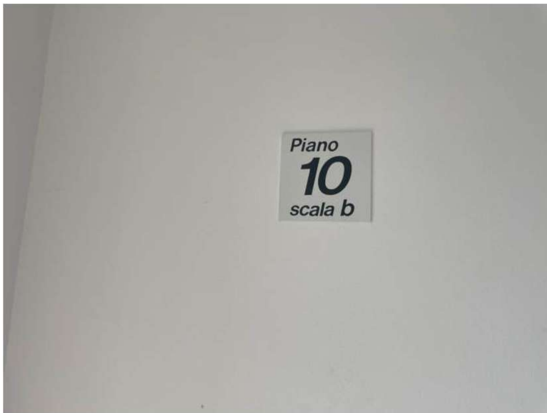
Vano scala condominiale
