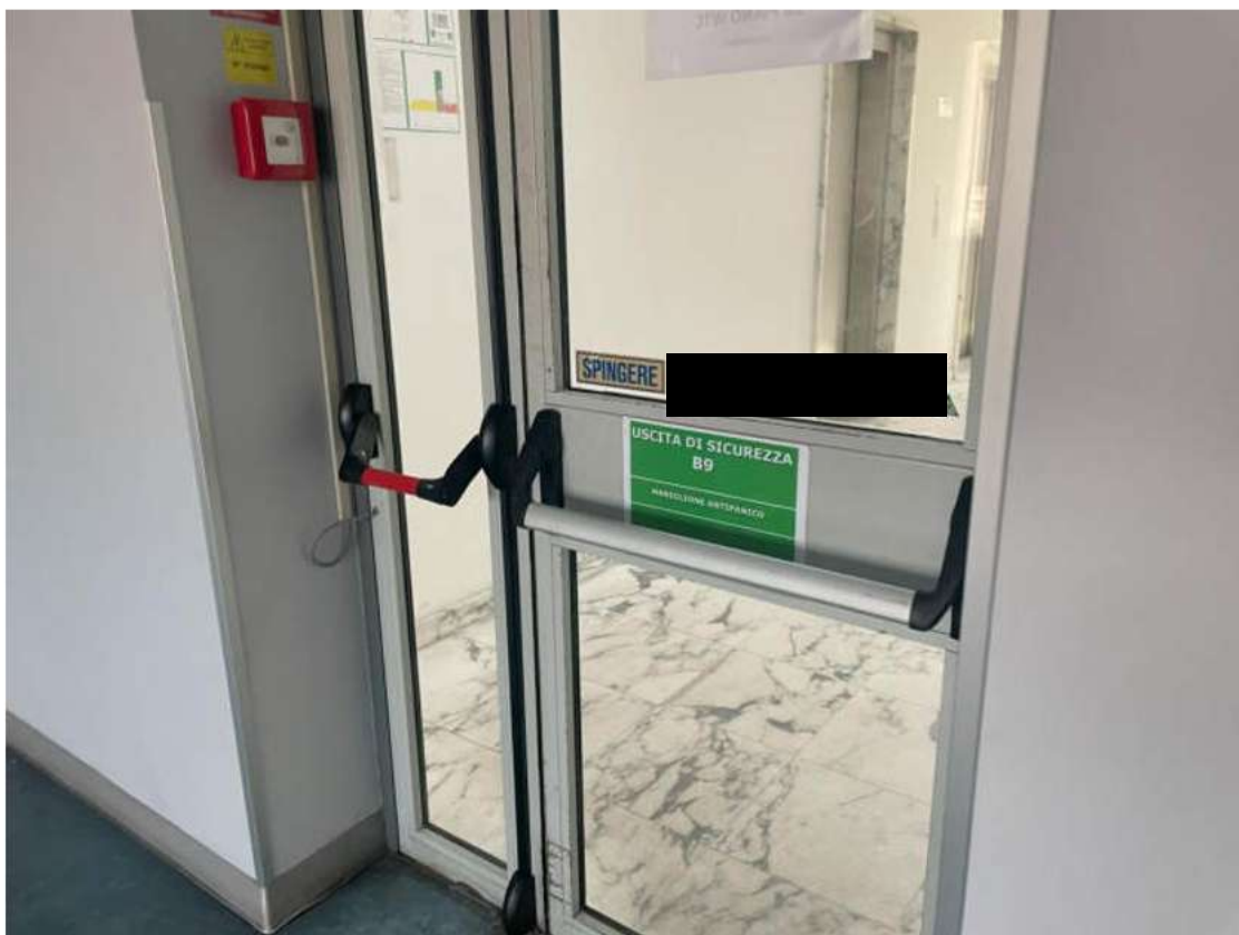
Ingresso da vano scala
