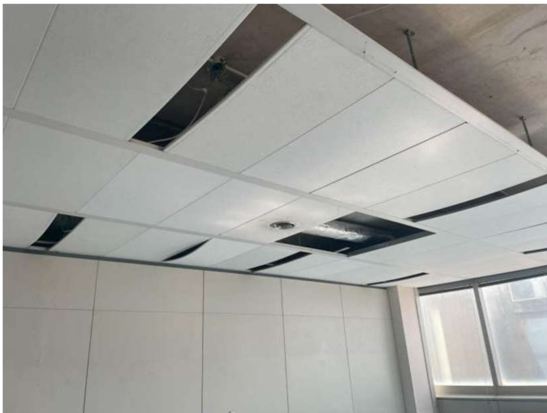
Particolare porzioni di controsoffitto smontate
