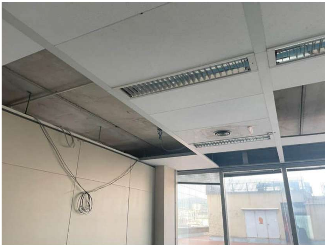
Particolare porzioni di controsoffitto smontate
