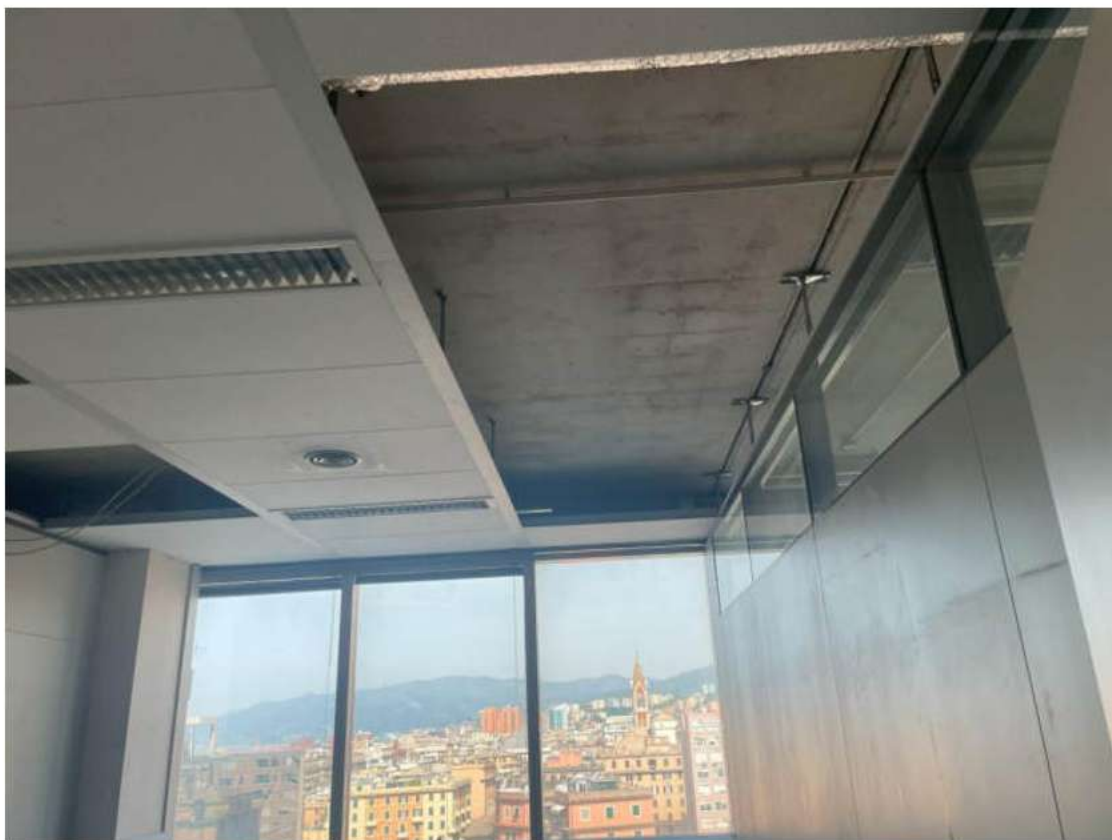
Porzioni di controsoffitto smontate
