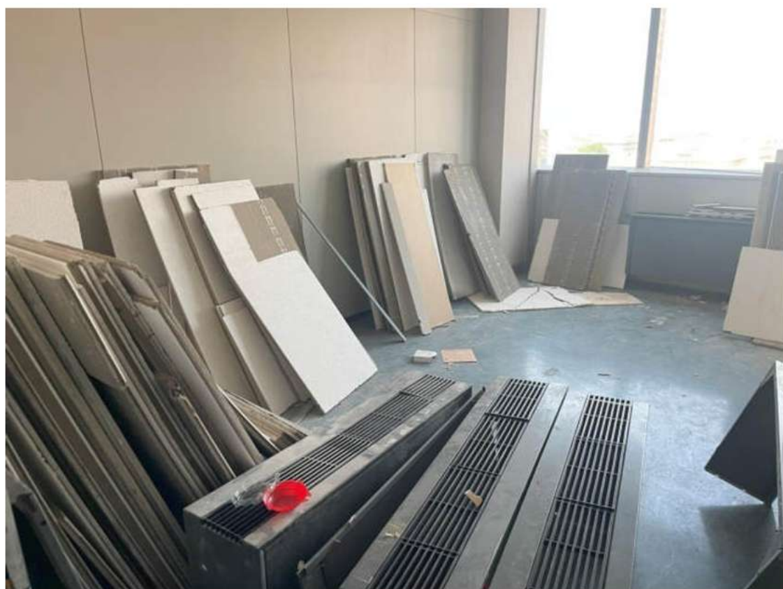
Pannelli controsoffitto accatastati nei locali
