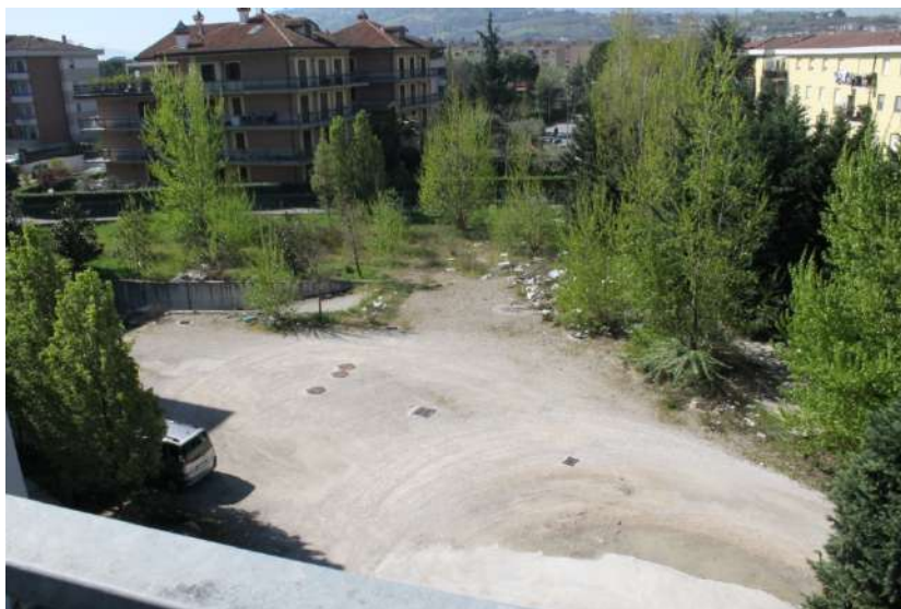
Fig.4: Vista del bene 3 , area di cantiere
