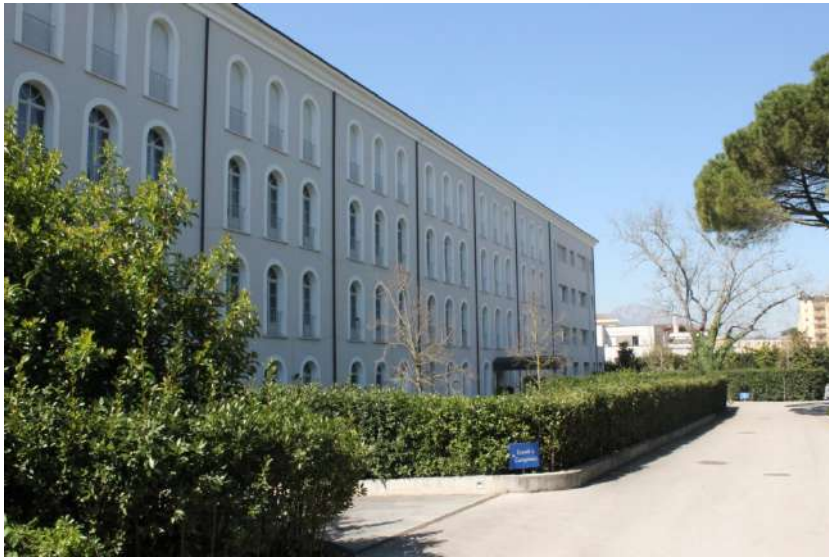
Fig.8: Vista del bene 5 - albergo, prospetto principale
