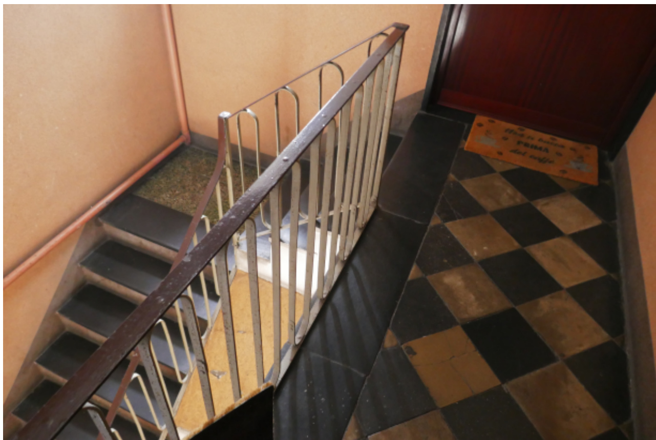
Foto 4 - Vista del vano scale
