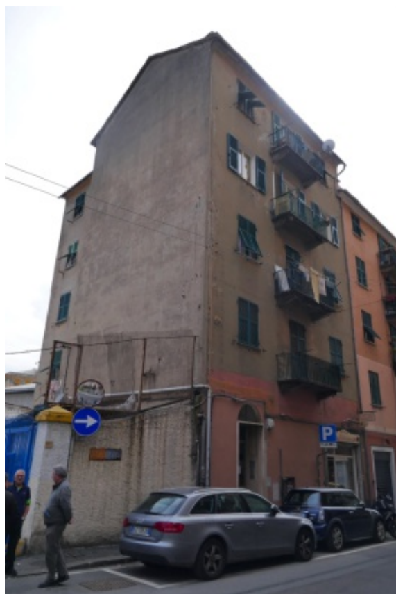
Foto 2 - Vista del prospetto del caseggiato
