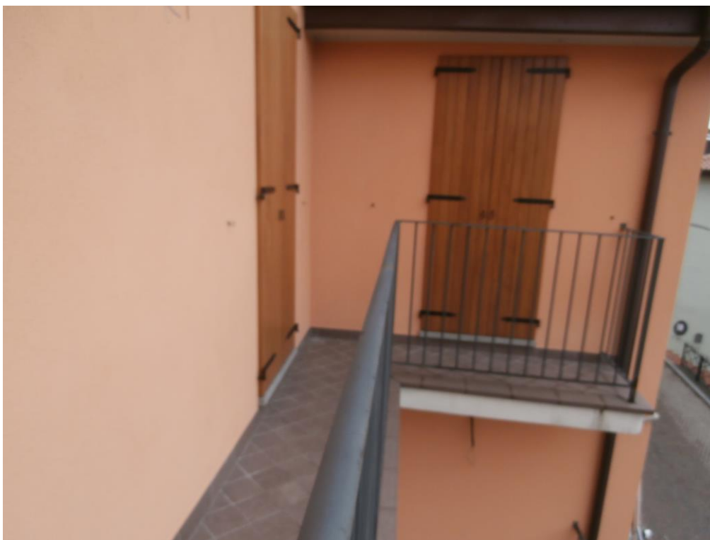
Balcone su via Roma
