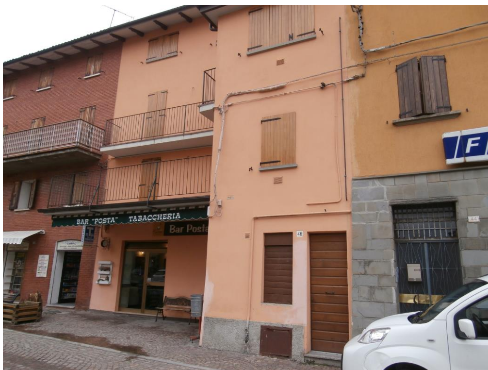
Fronte principale su via Roma
