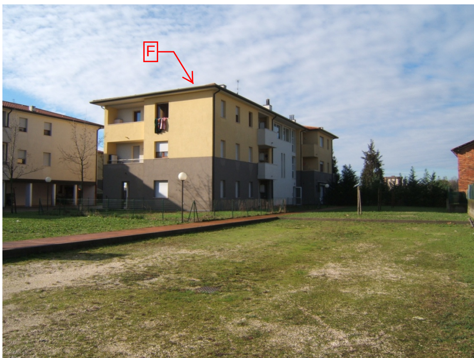
Posizione 8 - Vista dall'accesso di via Mascagni - fabbricato su mappale 897 con sub da 21 a 40 - prospetto nord ed est
