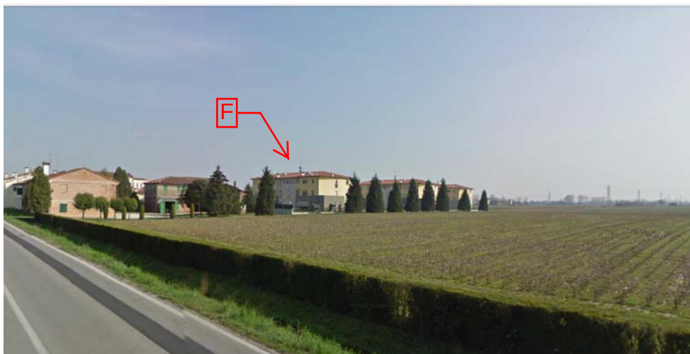
Posizione 1 - Vista da via Ronzinella - orientata a sud/est
