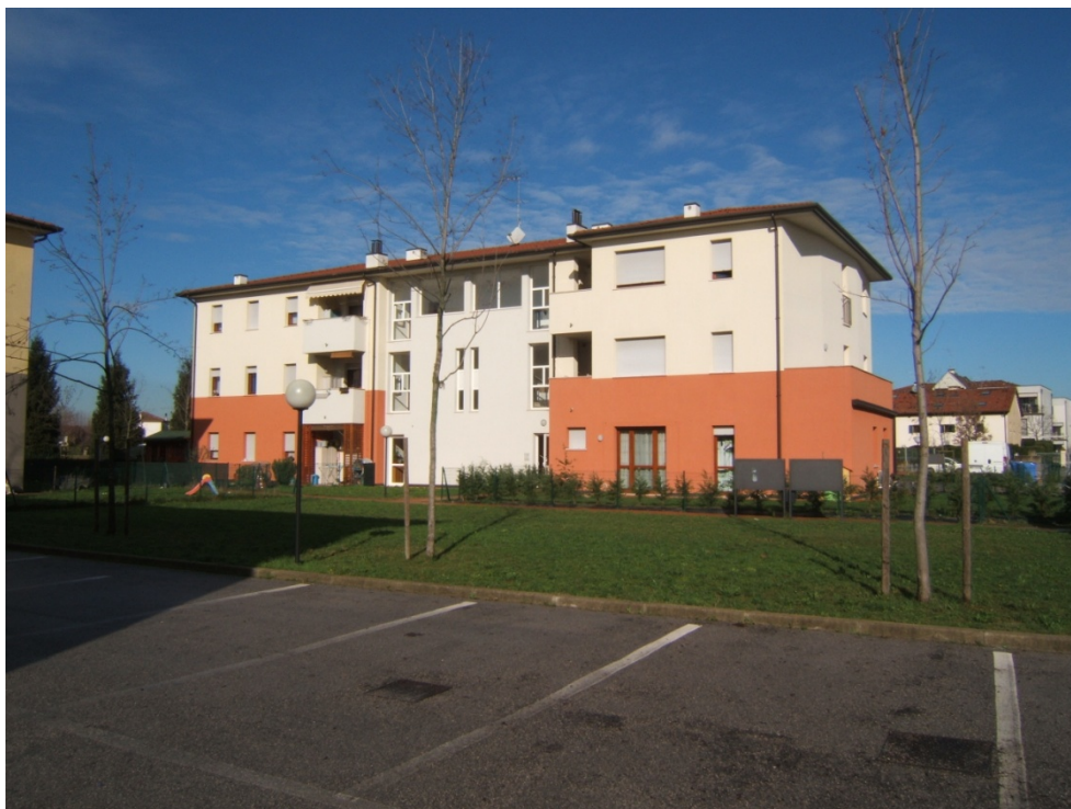
Posizione 6 - fabbricato su mappale 897 con sub da 1 a 20 - prospetto sud
