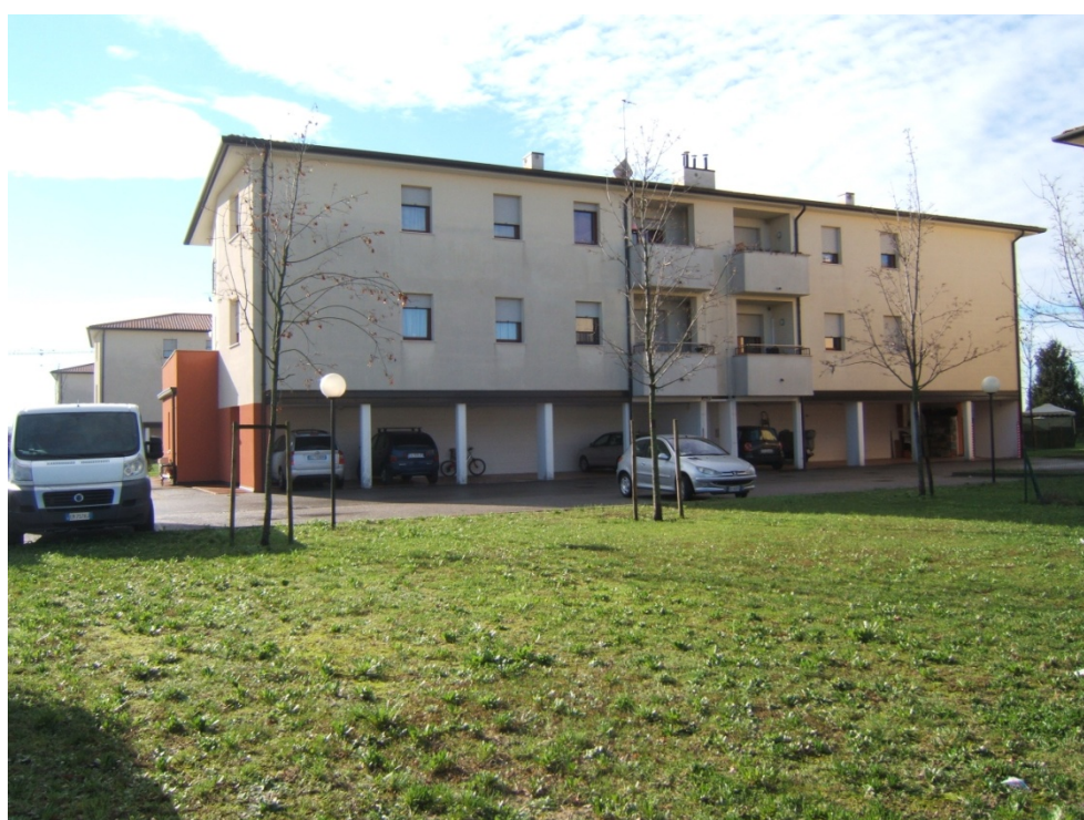
Posizione 7 - fabbricato su mappale 897 con sub da 1 a 20 - prospetto nord
