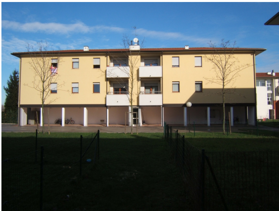
Posizione 4 - fabbricato su mappale 899 con sub da 21 a 40 - prospetto sud
