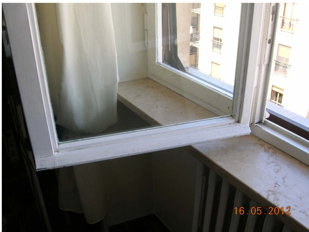
FOTO N. 10 INFISSO ESTERNO IN FERRO
