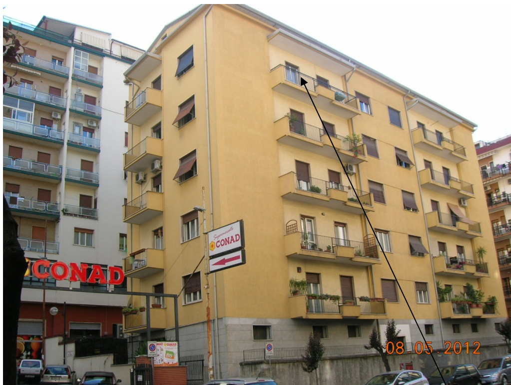
FOTO N. 01 FABBRICATO IN COSENZA VIA PASQUALE ROSSI 35 (APPARTAMENTO)
