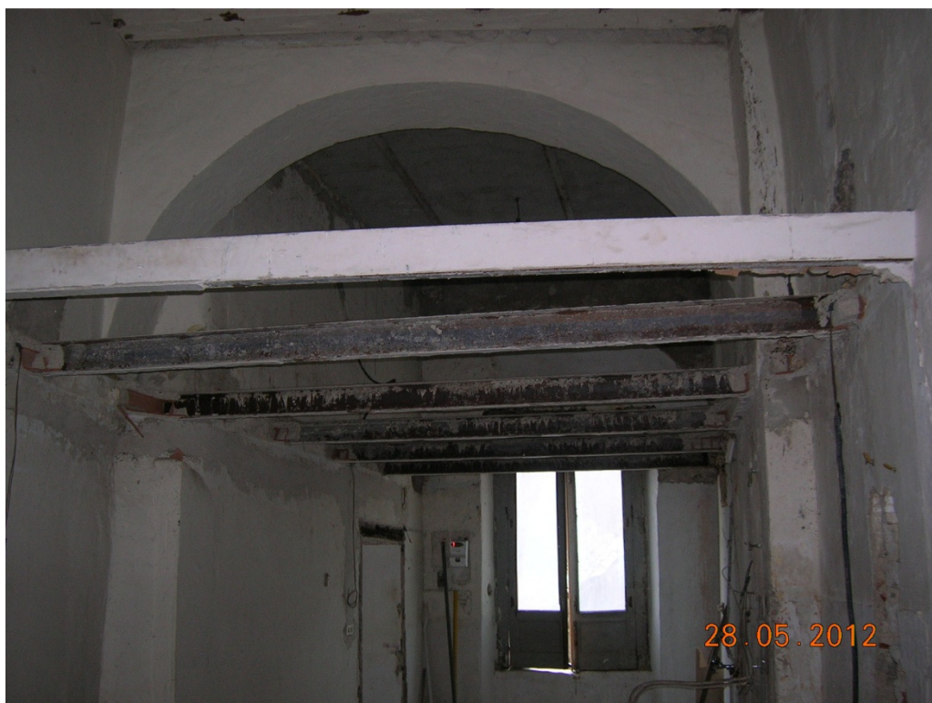
FOTO N. 08 STRUTTURA DEL SOLAIO
