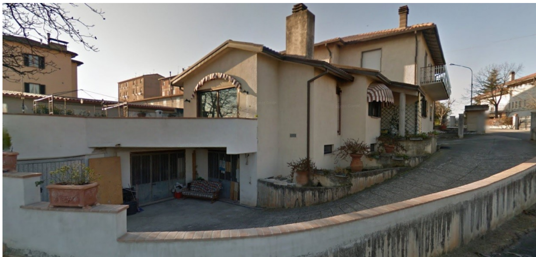
Figura 8 Vista esterna fabbricato in via della Repubblica n°3
