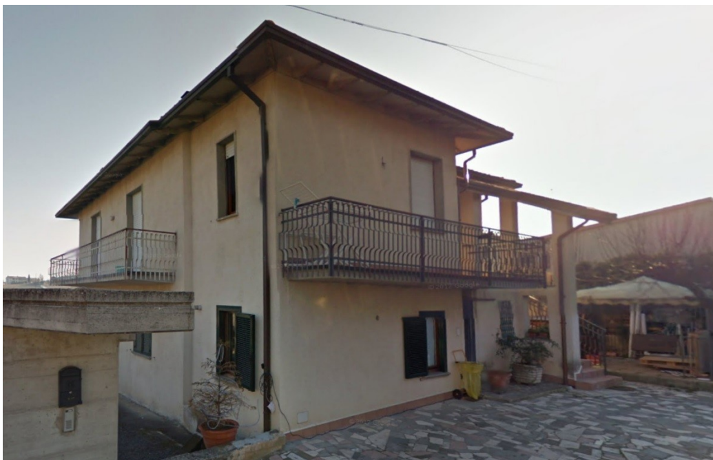
Figura 16 Vista esterna fabbricato in via della Repubblica n°3
