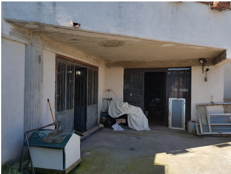
Figura 13 Vista ingresso esterno locale fondo_ Fg. 2 part 1472 sub 1
