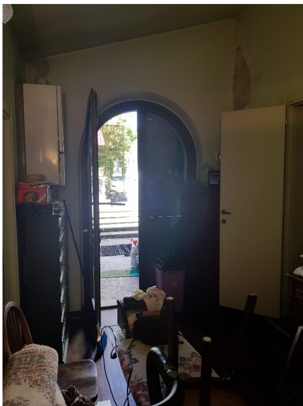
Figura 11 Vista interna locale disimpegno_ Fg. 2 part 1472 sub 1
