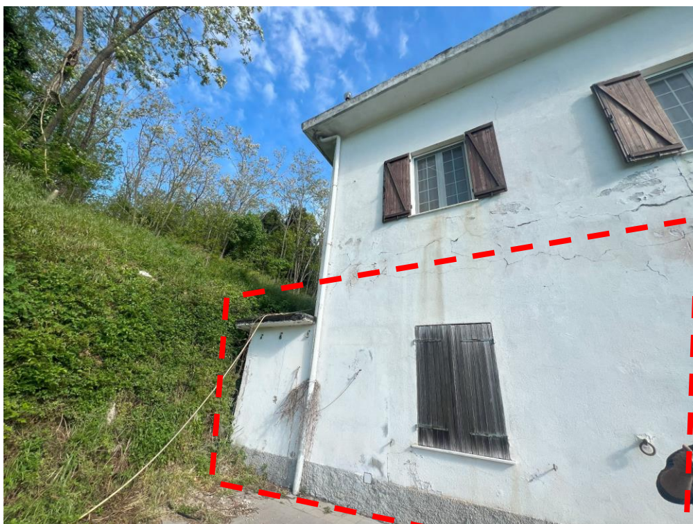
Foto n 5. - Vista prospetto sud e localizzazione abitazione
