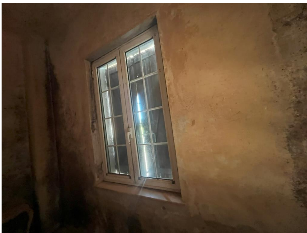
Foto n 21. - Stato delle pareti
