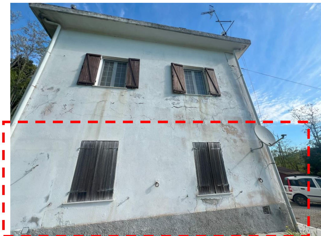
Foto n 4. - Vista prospetto sud e localizzazione abitazione
