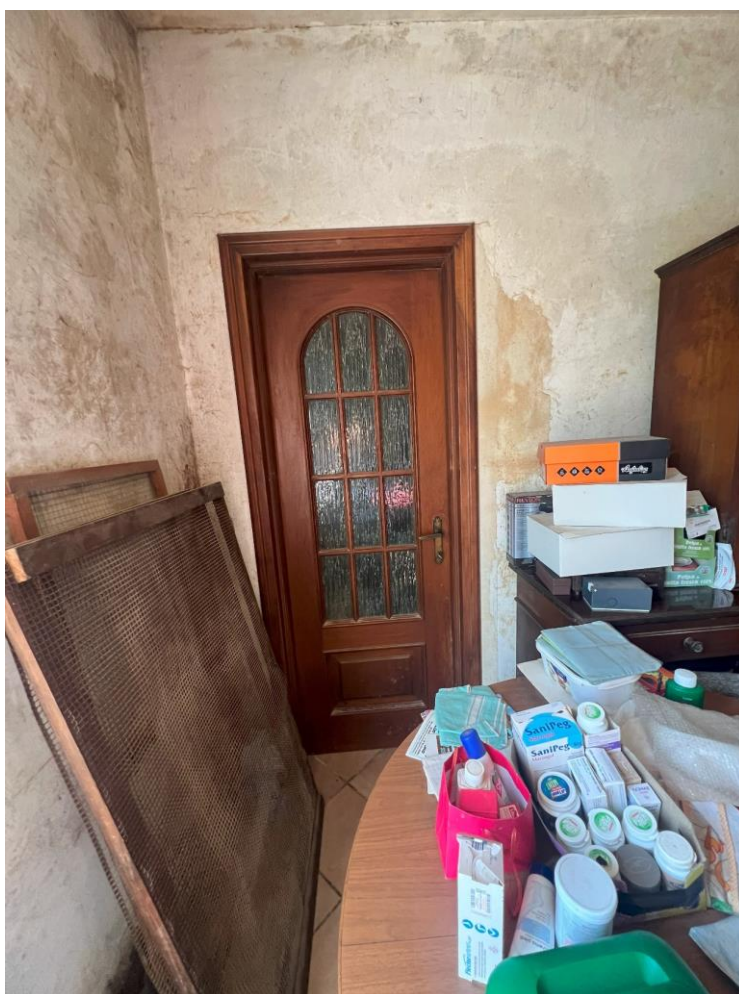
Foto n 22. - Stato delle pareti
