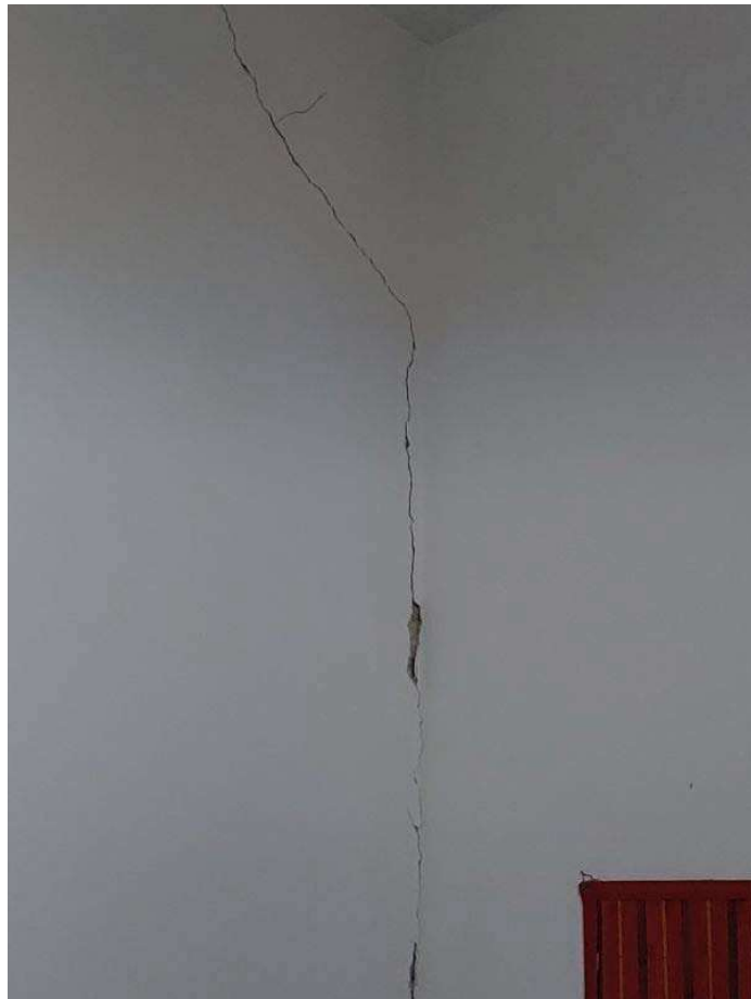
Foto dettaglio lesioni da cedimenti strutturali
