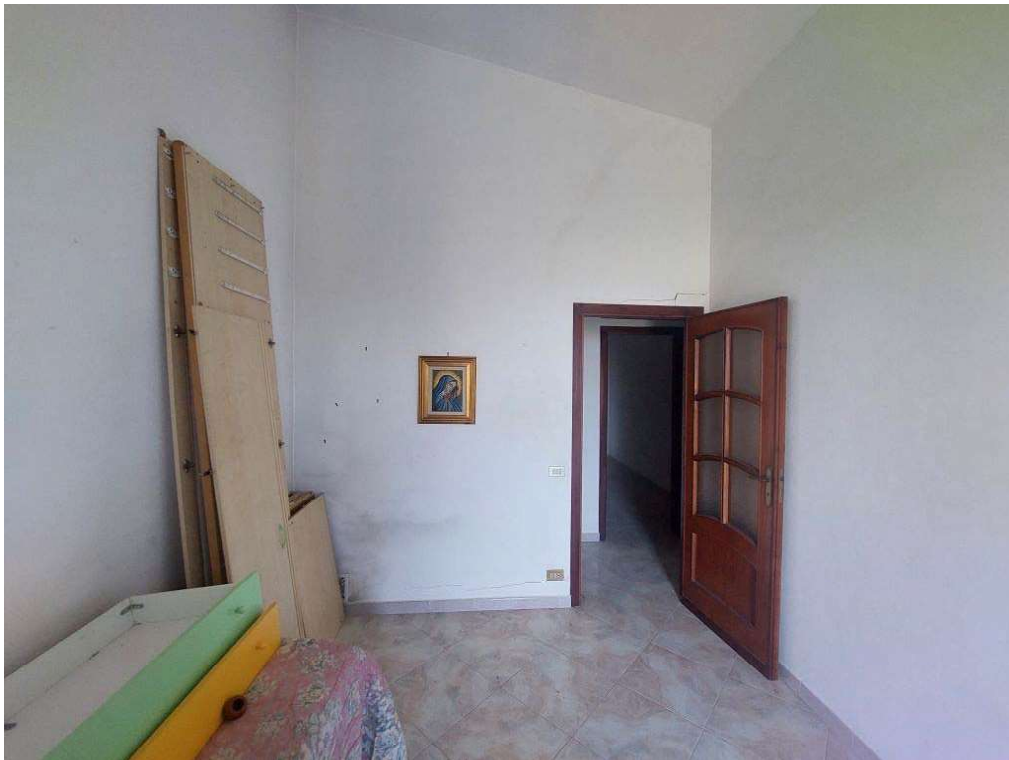
Foto I camera da letto al Piano Primo
