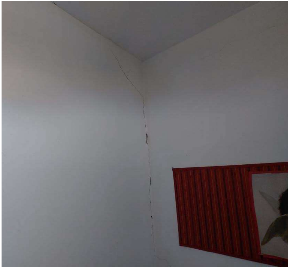
Foto dettaglio lesioni da cedimenti strutturali
