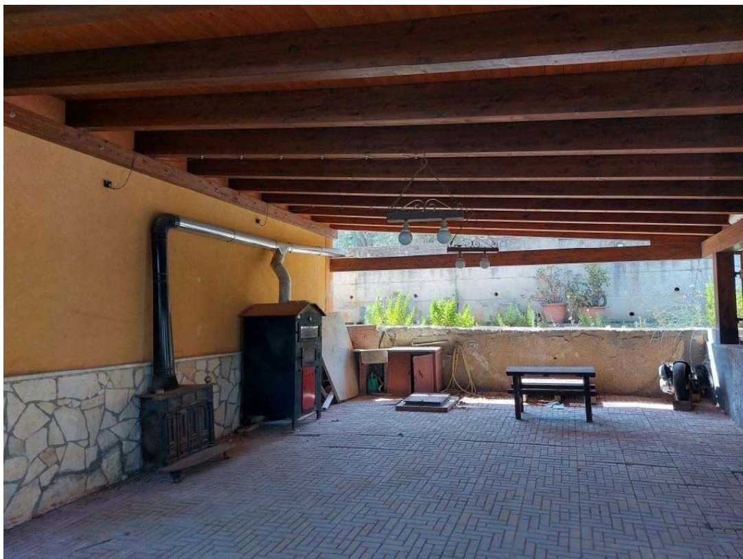
Foto tettoia lignea addossata al prospetto Sud-Ovest
