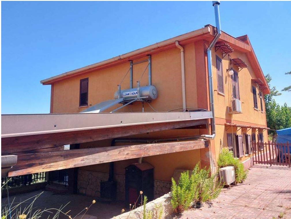
Foto Prospetto Sud-Ovest angolo Sud-Est
