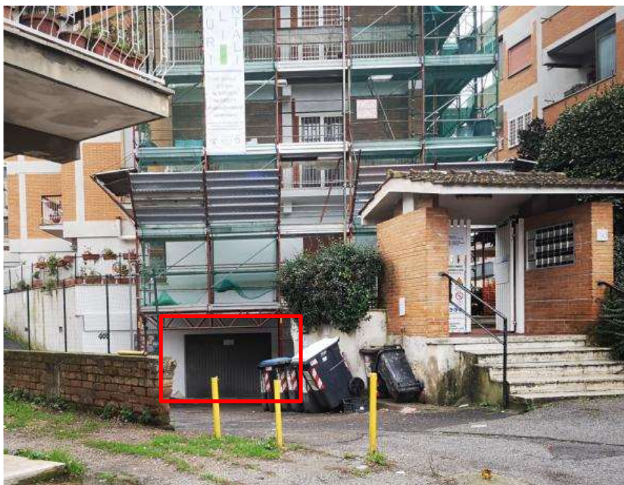
Foto 4: Ingresso dell'autorimessa nel fabbricato con p.lla n. 121
