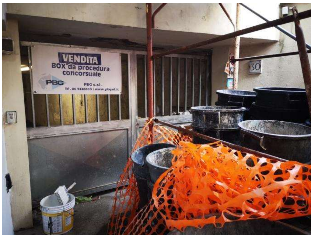
Foto 7: Ingresso all'autorimessa del fabbricato con p.lla n. 333
