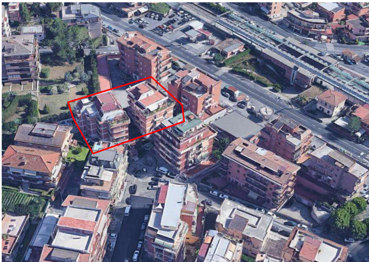
Foto 2: Vista dall'alto ravvicinata dei due fabbricati
