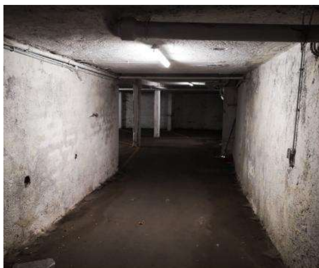
Foto 9: Vista dell'ingresso dell'autorimessa
