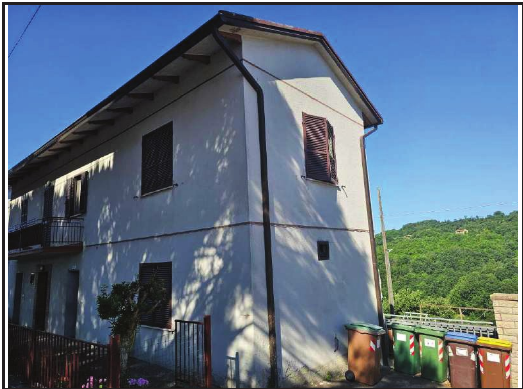
Foto n. 2 LOTTO A Vista esterna del fabbricato abitativo.
