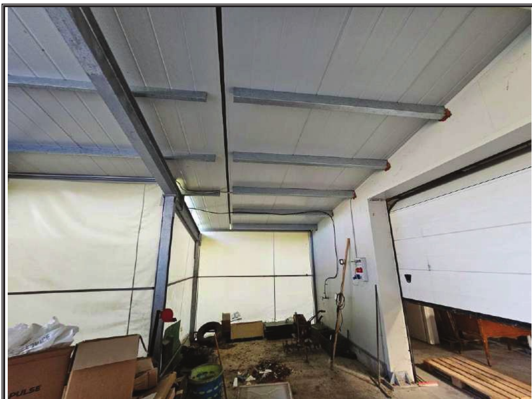
Foto n. 58 LOTTO B.1 Vista di parte della tettoia del magazzino.
