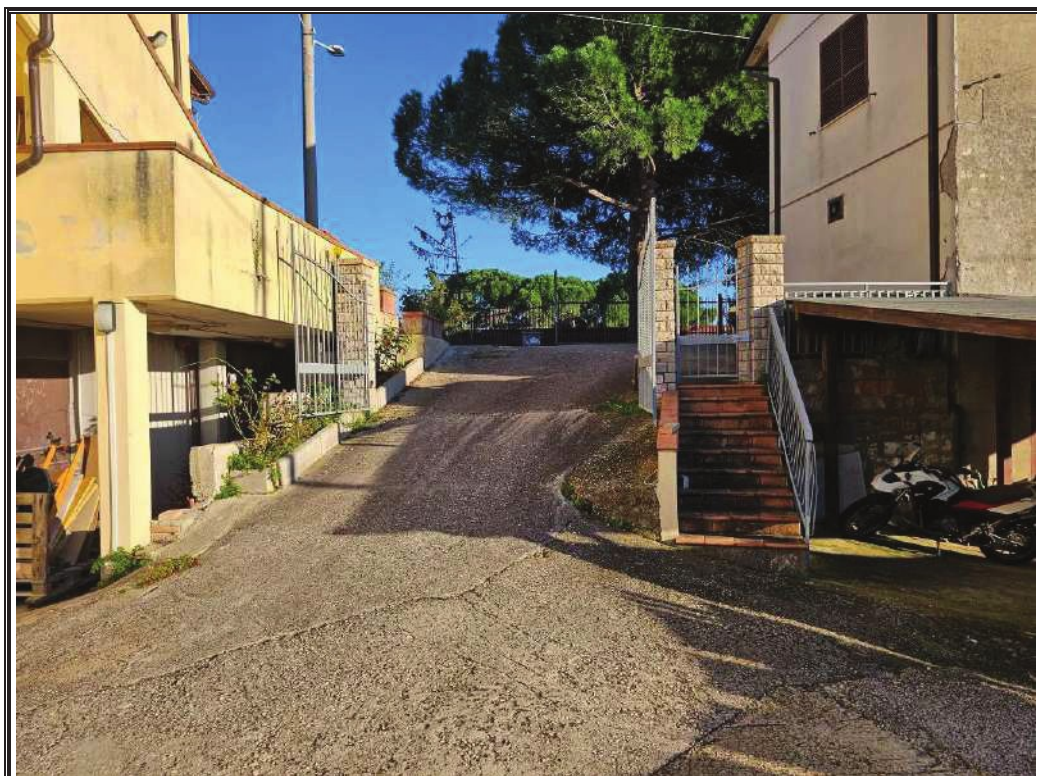
Foto n. 30 LOTTO B.2 Particolare della rampa di accesso al piano seminterrato.
