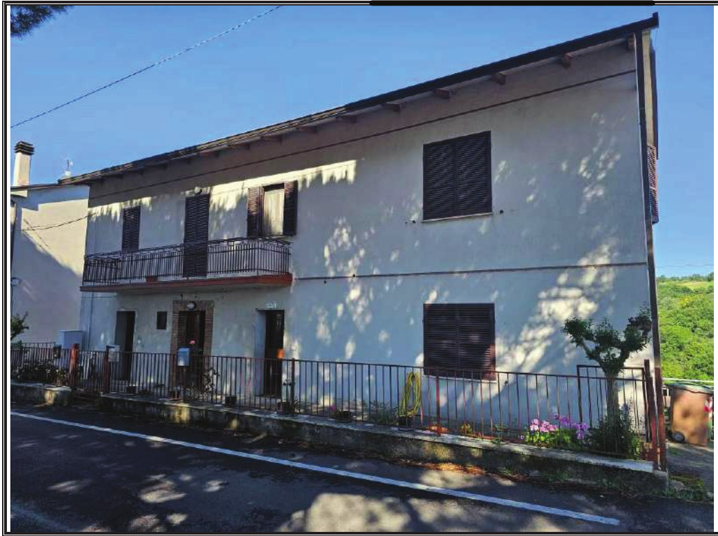
Foto n. 1 LOTTO A Vista esterna del fabbricato abitativo.
