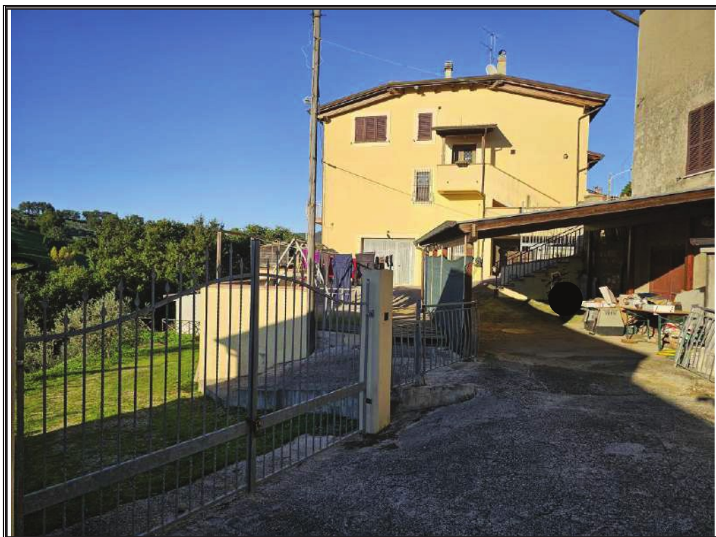
Foto n. 11 LOTTO A Vista della corte del fabbricato con recinzione e cancello di accesso alla viabilità che conduce al magazzino afferente il lotto B.
