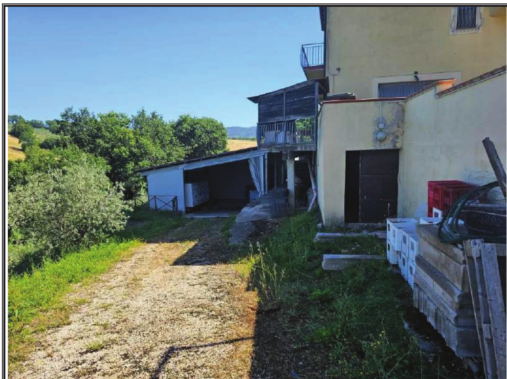
Foto n. 52 LOTTO B.1 Vista della viabilità interna di accesso al magazzino.
