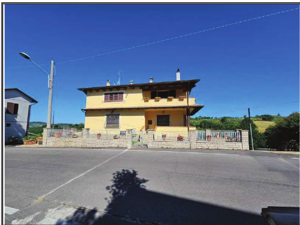
Foto n. 27 LOTTO B.2 Vista esterna del fabbricato di cui gli immobili oggetto di stima fanno parte.
