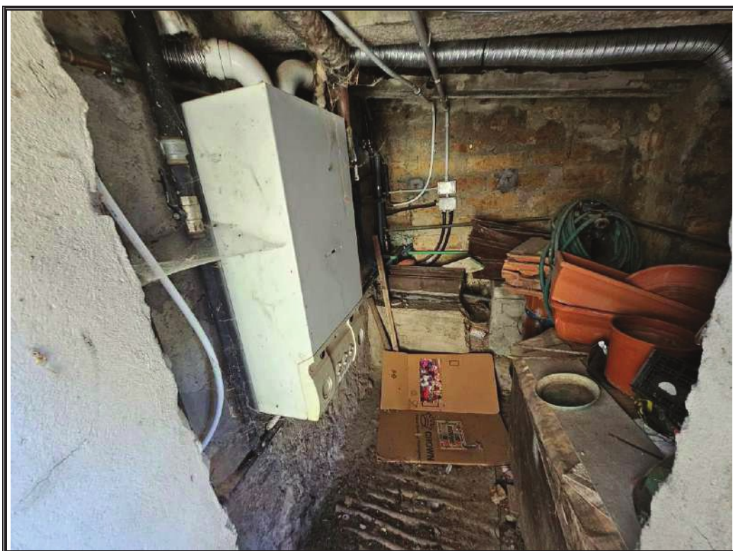
Foto n. 10 LOTTO A Vista interna di uno dei due fondi posti al piano seminterrato del fabbricato.
