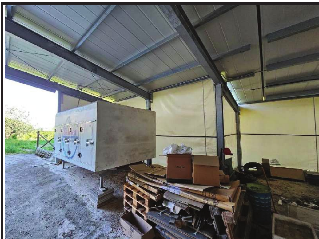
Foto n. 59 LOTTO B.1 Vista di parte della tettoia del magazzino.
