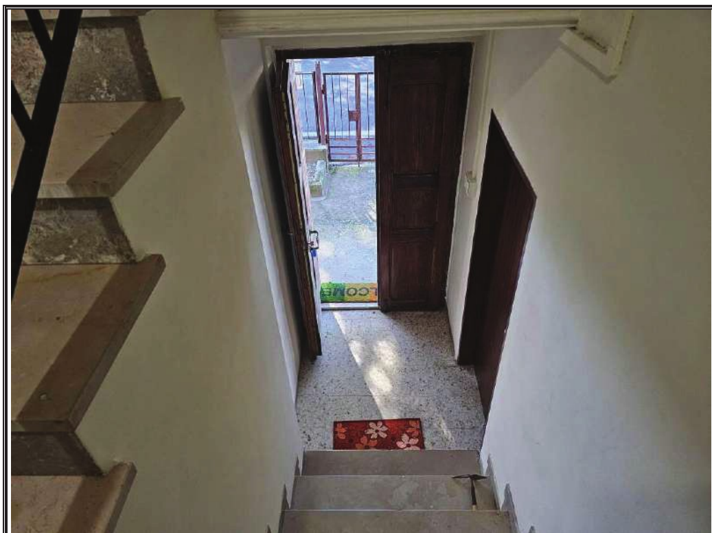
Foto n. 18 LOTTO A.1 Scala di accesso al piano primo.
