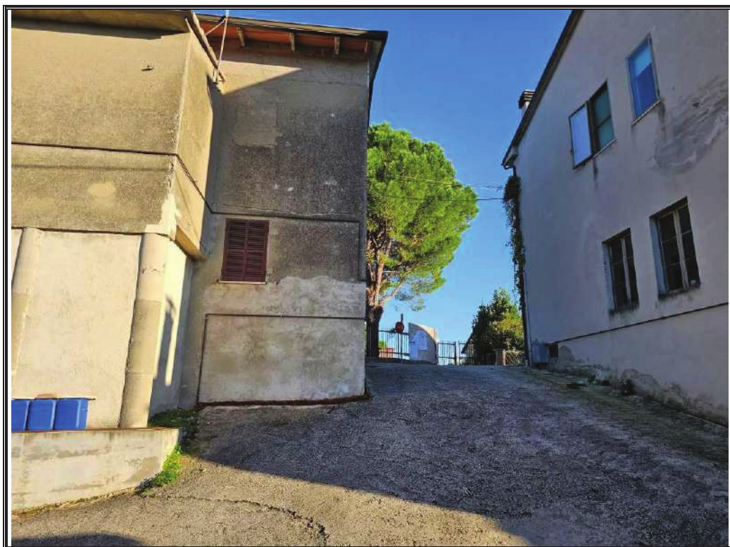
Foto n. 3 LOTTO A Particolare della strada di accesso alla corte posta sul retro del fabbricato abitativo.
