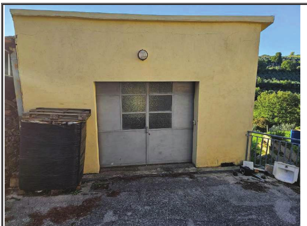
Foto n. 4 LOTTO A.2 Vista esterna del piano terra del fabbricato destinato ad autorimessa.
