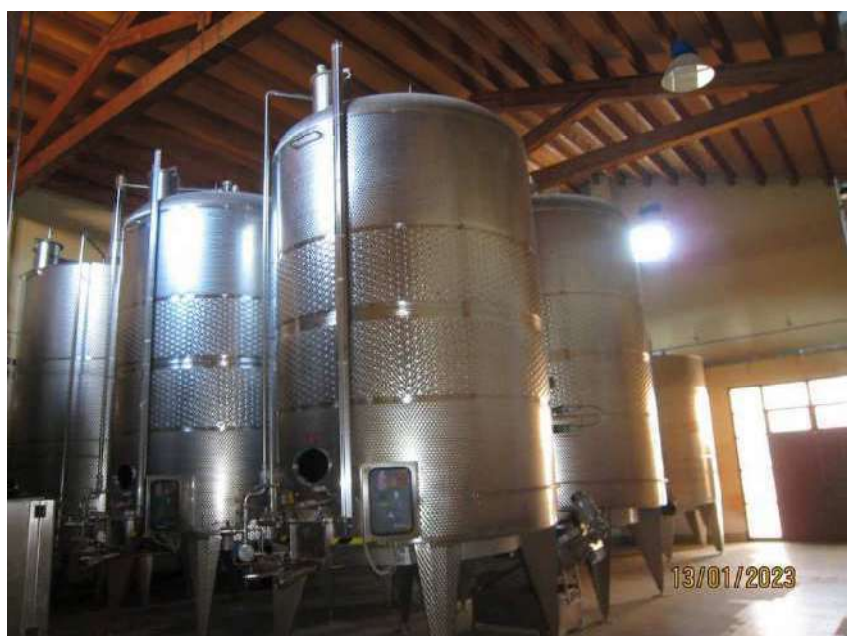
Foto n. 30. La grande sala stoccaggio.
