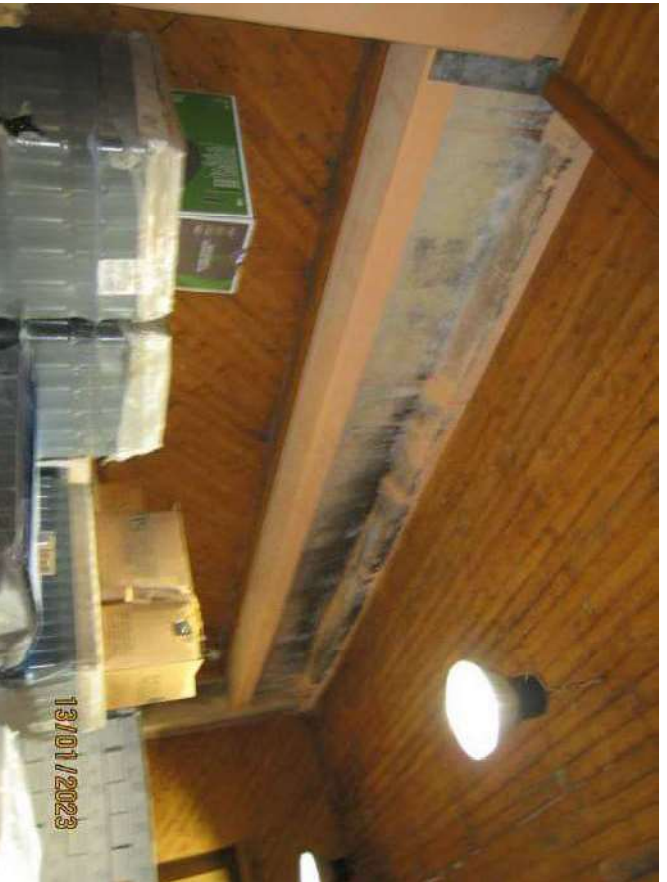
Foto n. 48. Presenza di umidità e muffe
