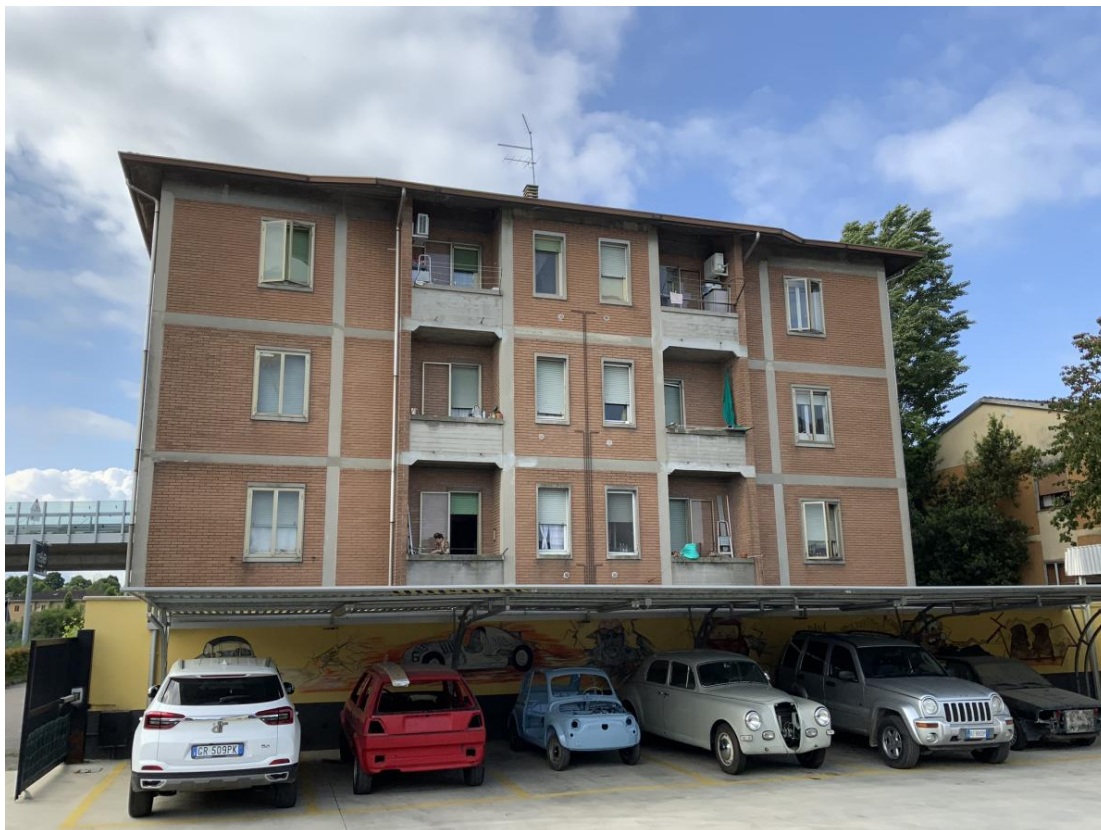
Foto n. 3 – Vista posteriore (Nord)
