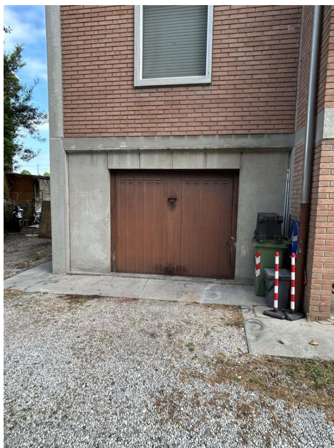
Foto n. 28 – Lotto 2 – Garage – Sub. 3 – Piano T° – Ingresso
