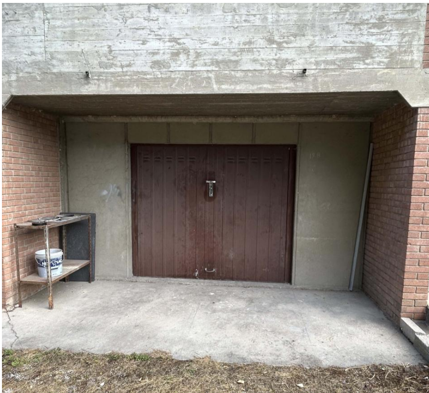
Foto n. 17 – Lotto 1 – Garage – Sub. 1 – Piano T – Ingresso
