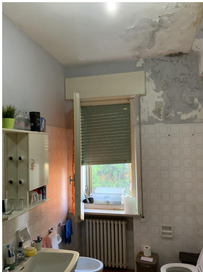
Foto n. 15 – Lotto 1 – Appartamento – Sub. 1 – Piano I° – Bagno
