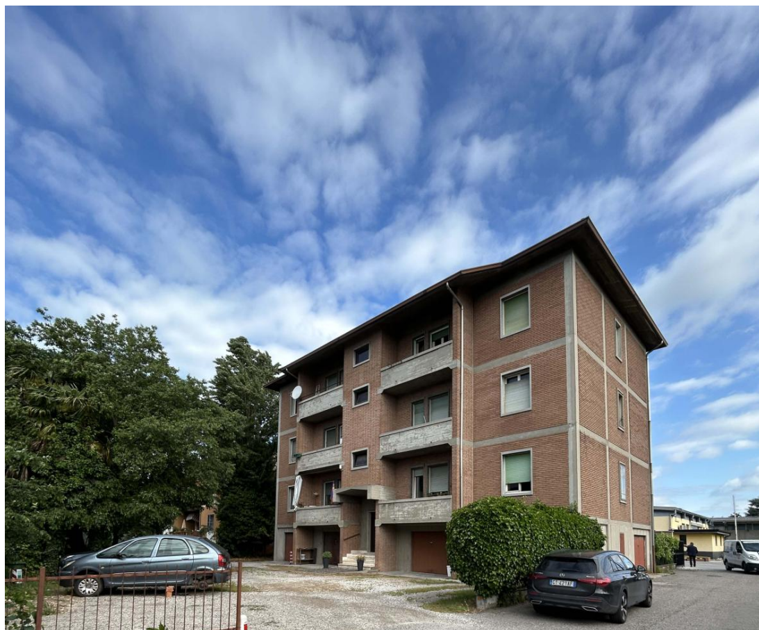
Foto n. 4 – Vista laterale (Est)
