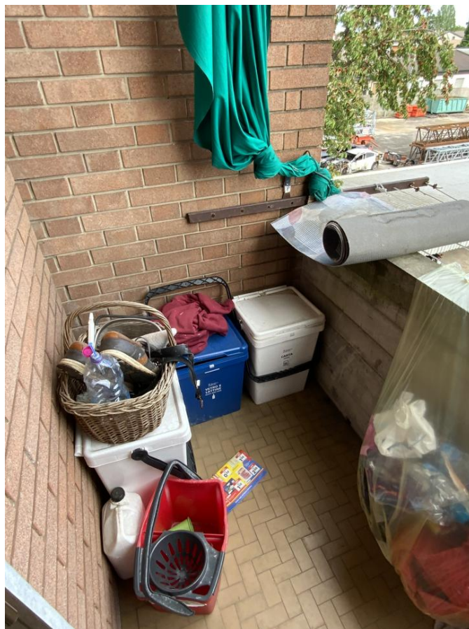
Foto n. 27 – Lotto 2 – Appartamento – Sub. 3 – Piano II° – Balcone cucina
