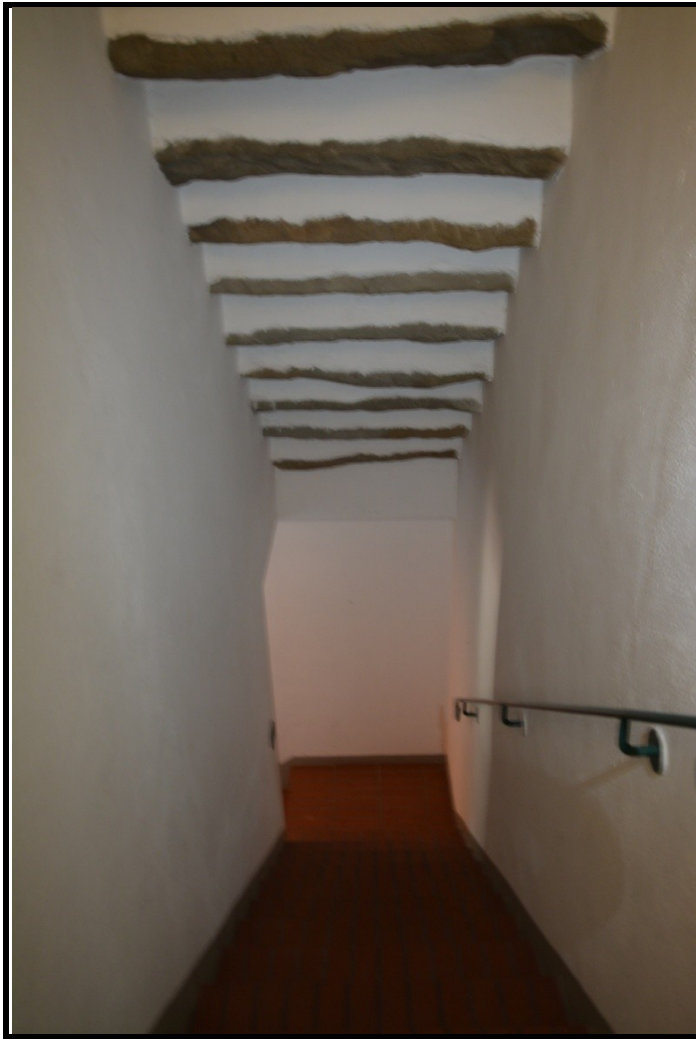
Fotografia n. 9 Scala di accesso al piani primo seminterrato
