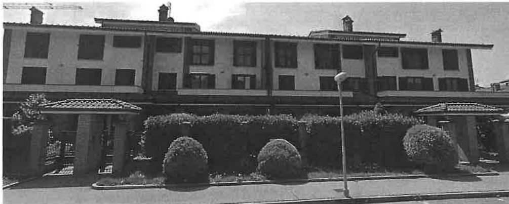
- vista da Via Penarol di Montevideo
