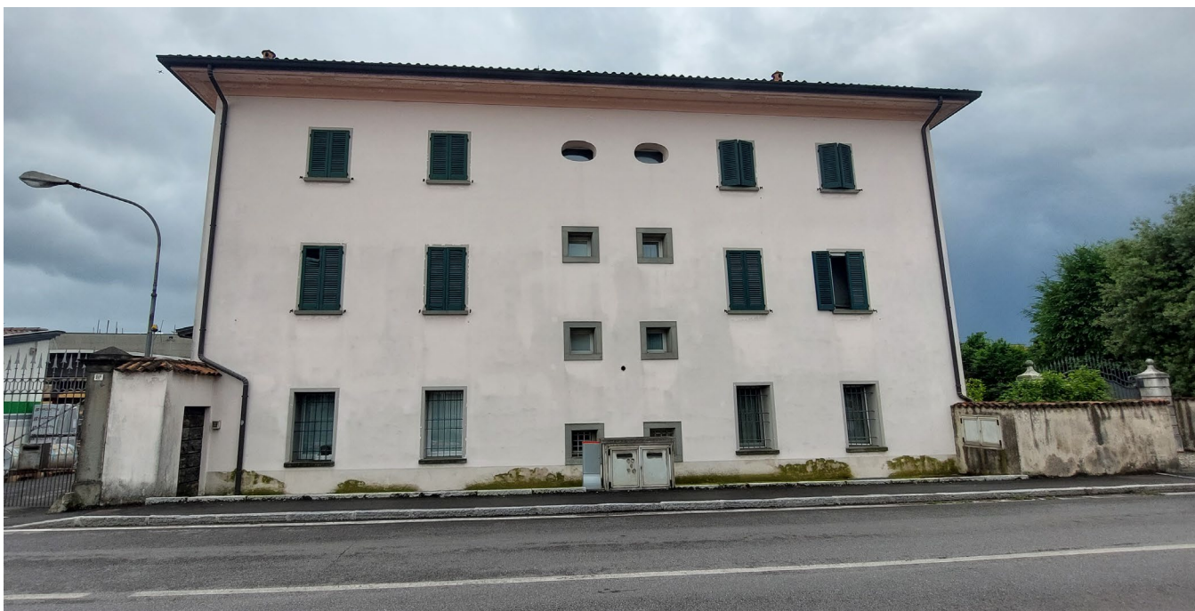
Vista abitazione da Via XXV Aprile
