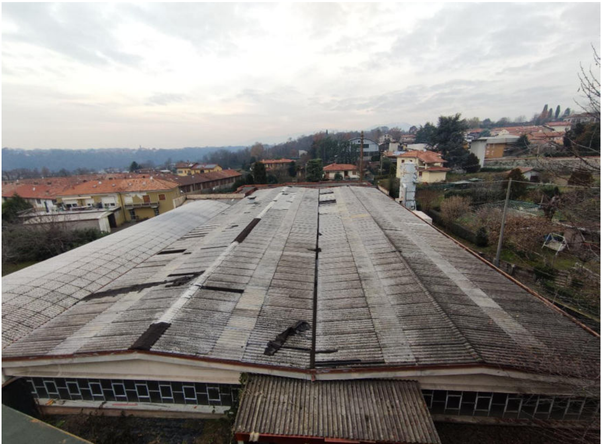
8. Vano copertura capannone
