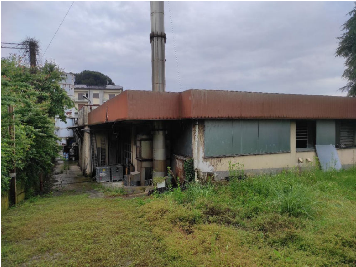
5. Vista facciata nord ed est
