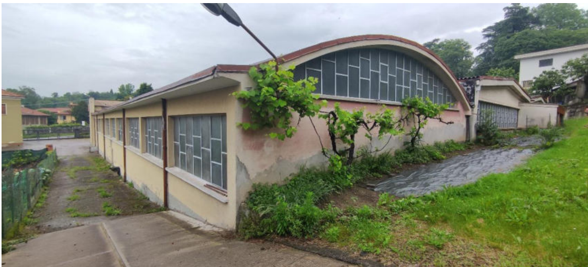
6. Vista facciata ovest e sud
