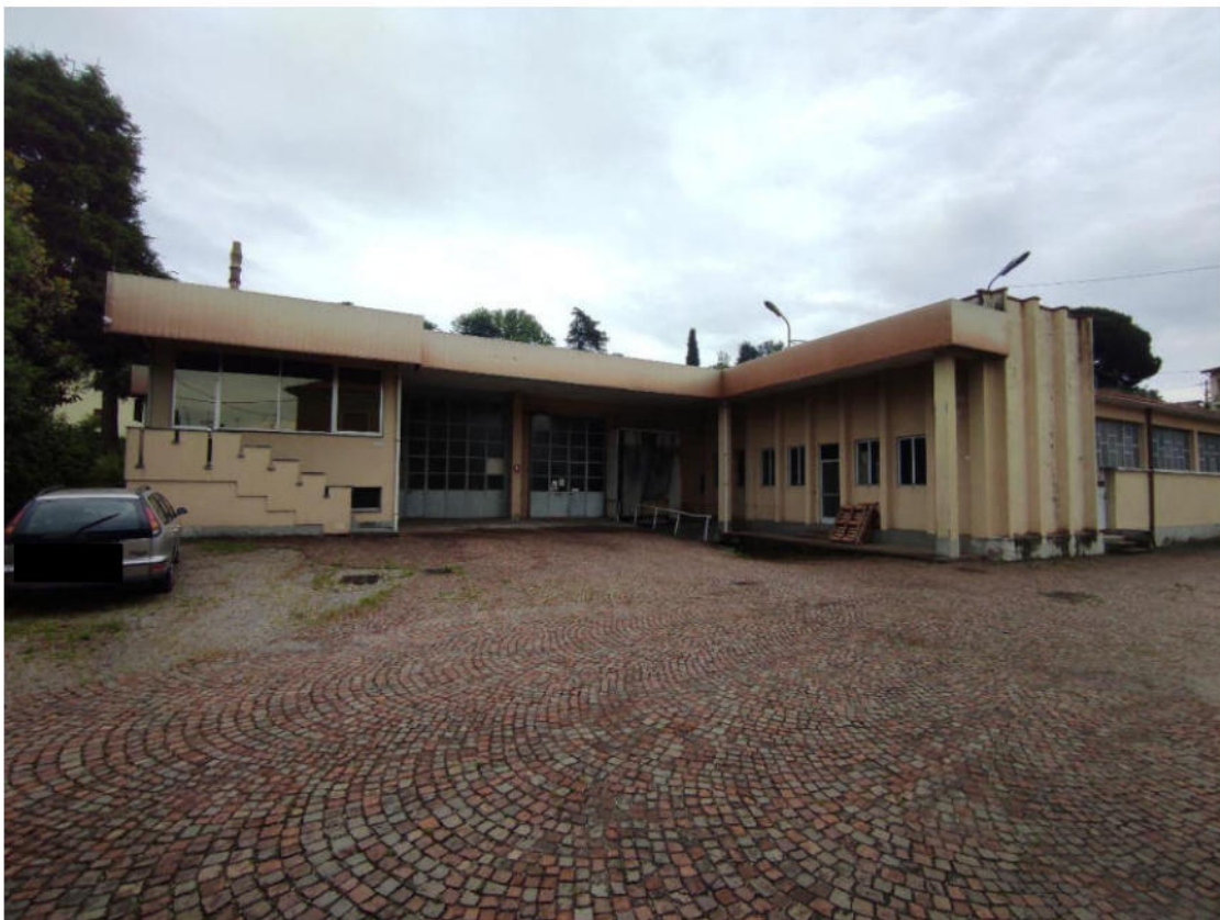
3. Vista facciata ovest
