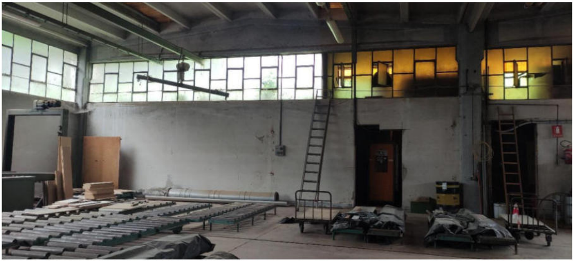
12. Interno capannone ( porzione anno 1967 )
