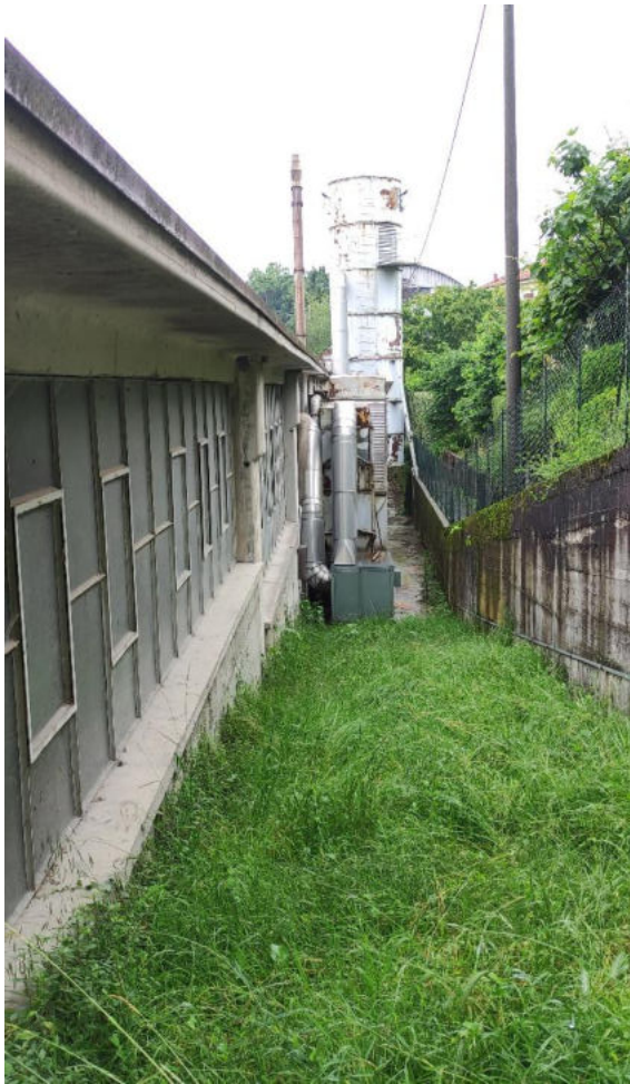
7. Vano facciata est
