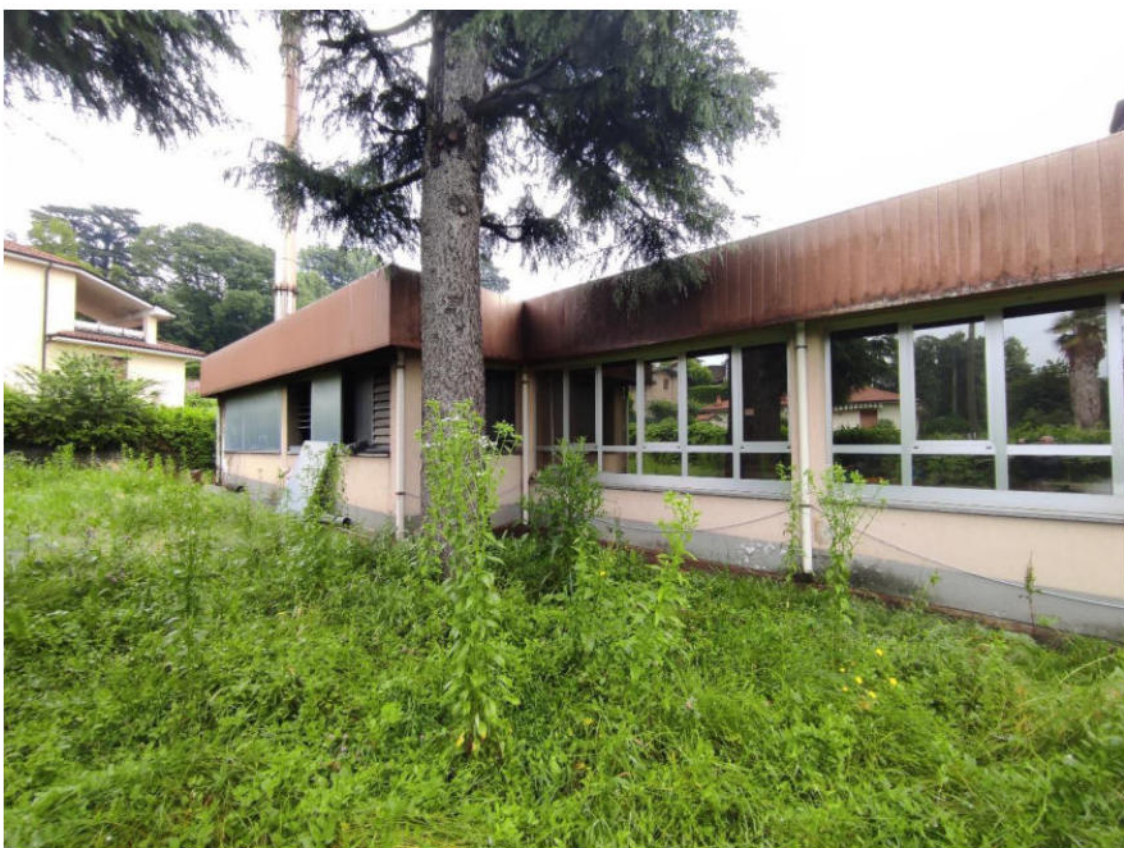
4. Vista facciata nord verso Via Monte Grappa
