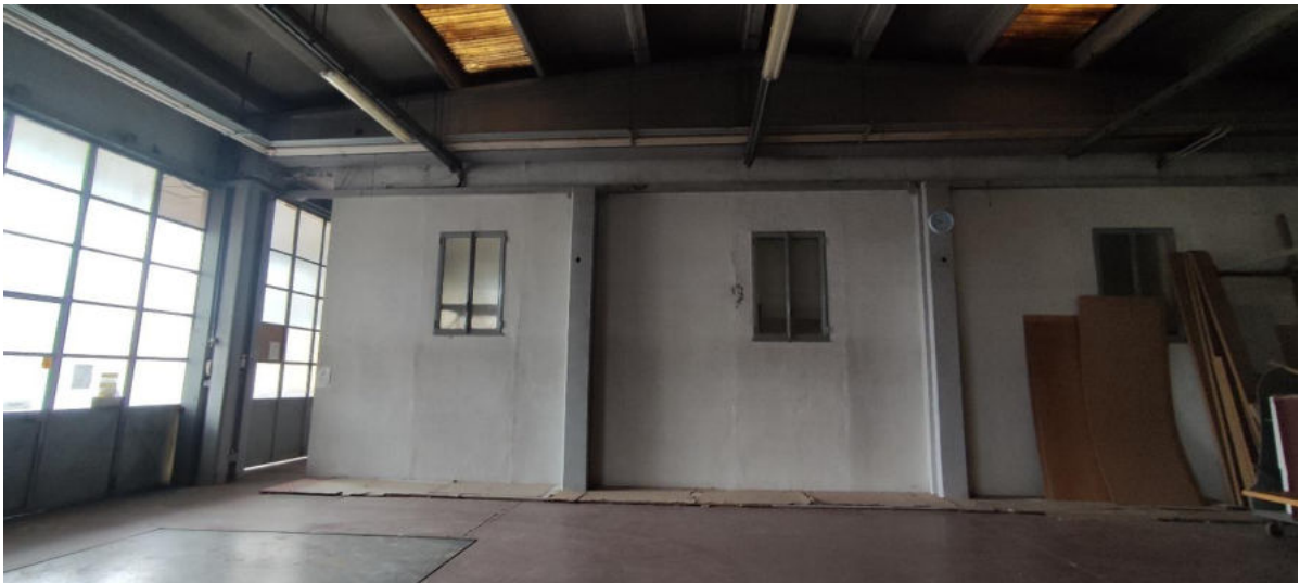
10. Interno capannone ( porzione Condonò 1986 )
