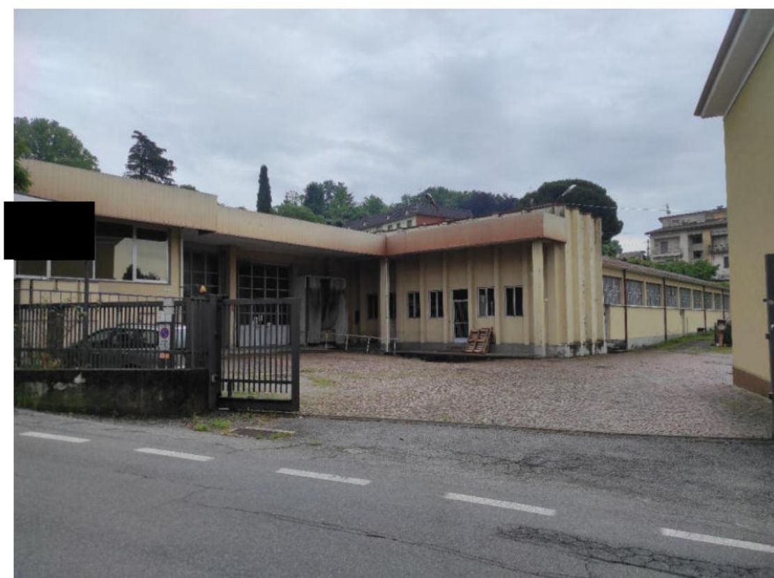
2. Vista ingresso da Via Monte Grappa
