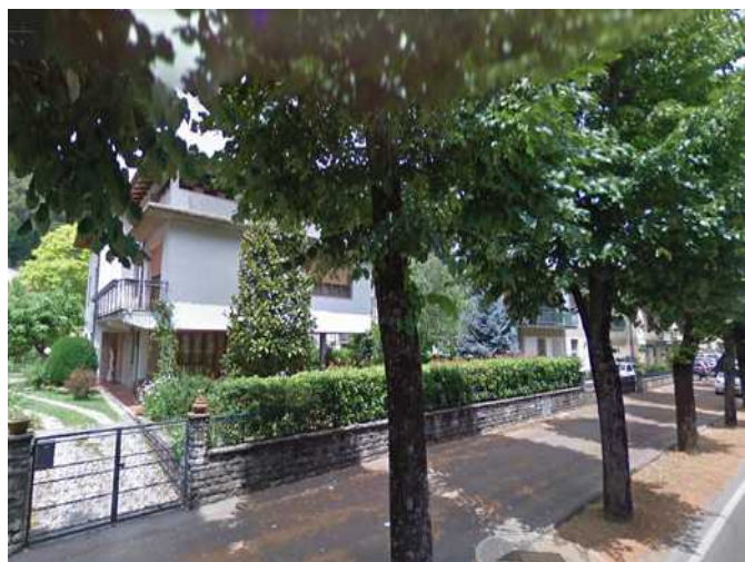
Prospetto su Via Provinciale
