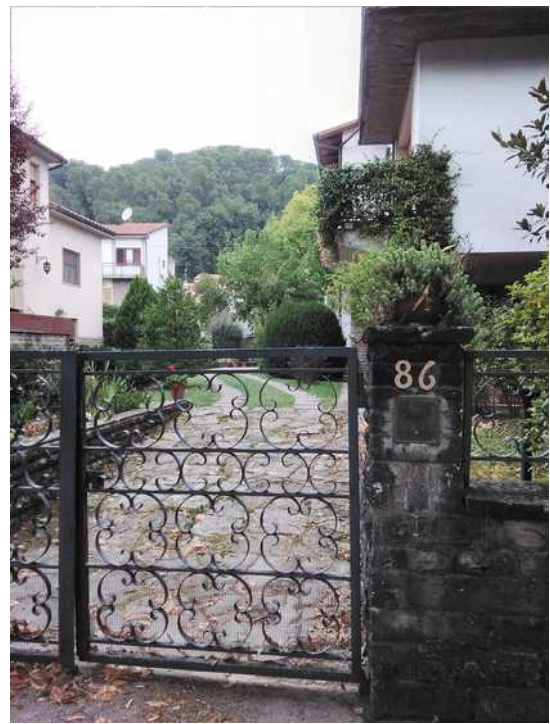
Prospetto su Via Provinciale
