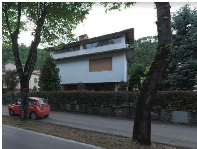
Prospetto su Via Provinciale
