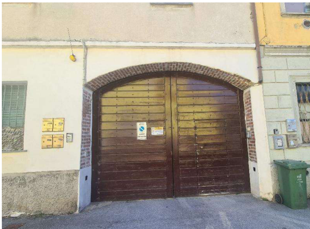
FOTO 1: MESERO, Via Papa Pio XII n. 2, portone d'ingresso su strada
