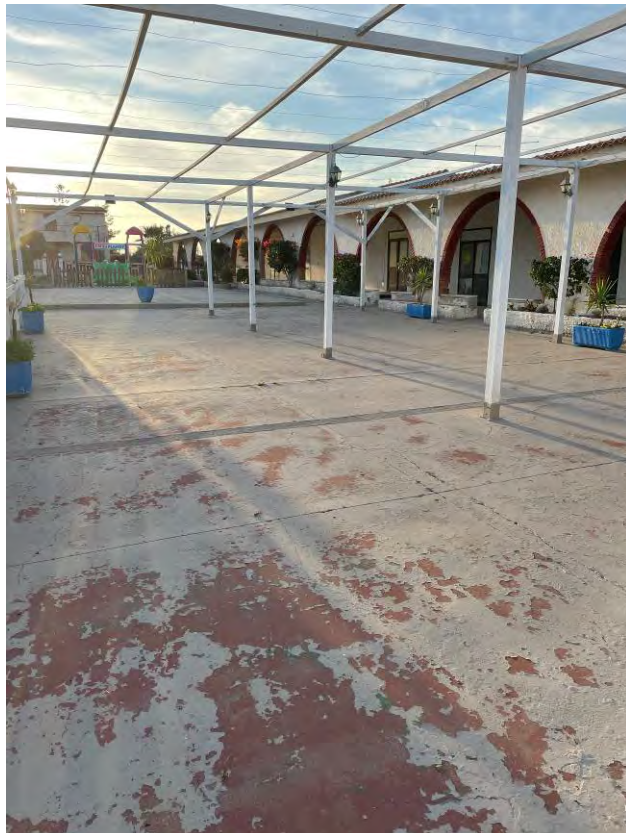
FOTO 4 – Spazi ricreativi a servizio del Villaggio
