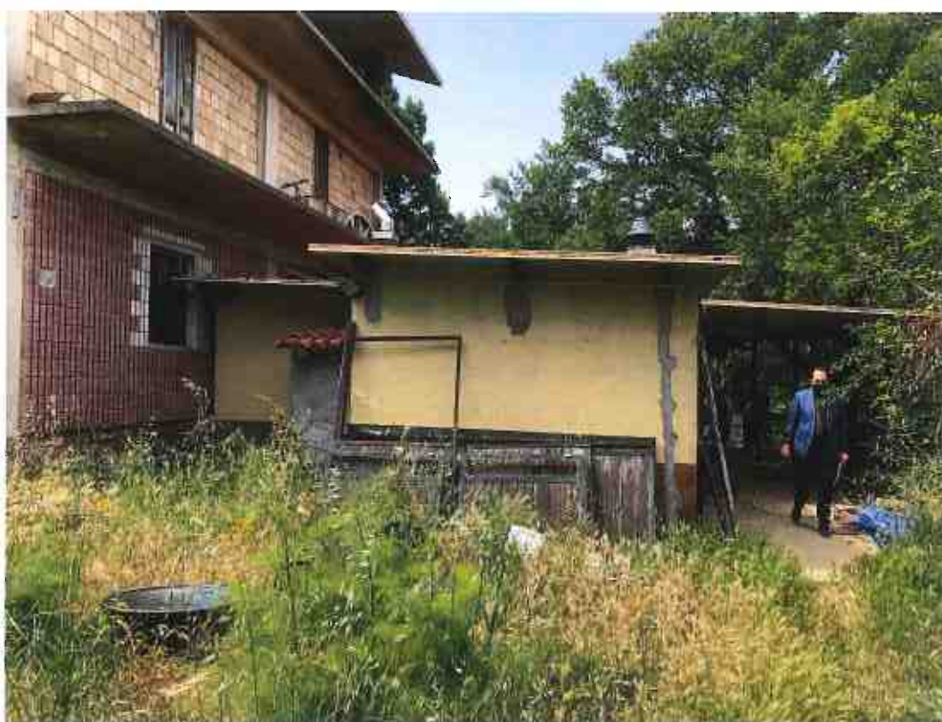
Foto 81 – Terreno con fabbricati in Argusto (lotto n. 10): corpo avanzato dell' edificio in corso di costruzione
