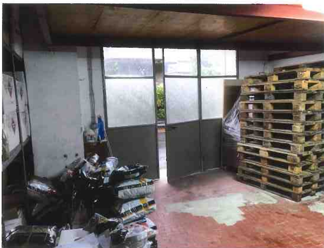
Foto 46 – Interno deposito sulla via Nazionale: fg 34 part. 235 sub 3 (lotto di vendita n. 4)
