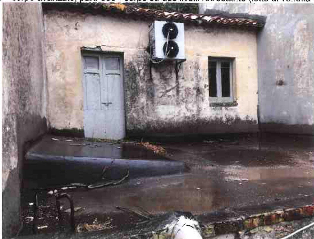
Foto 28 – Lastrico solare particella 717 e primo piano particella 563 (lotto di vendita n. 2)
