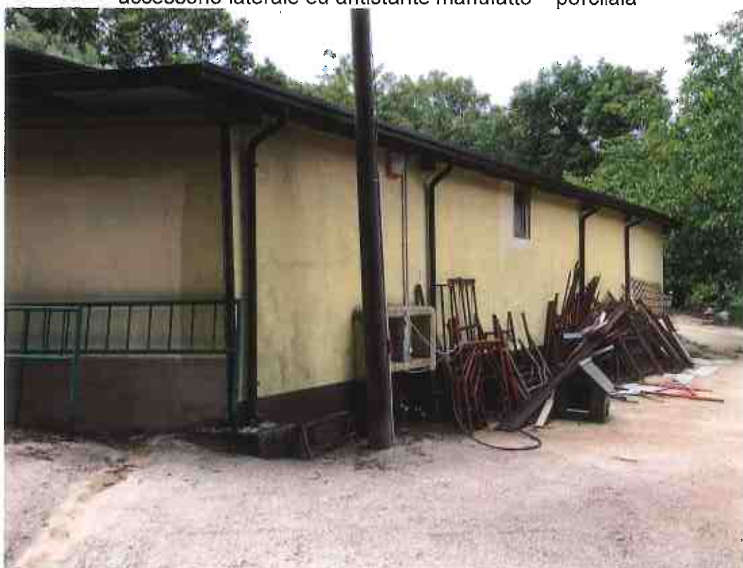
Foto 84 – Terreno con fabbricati in Argusto: stalla con locale accessorio (prospetto laterale)
