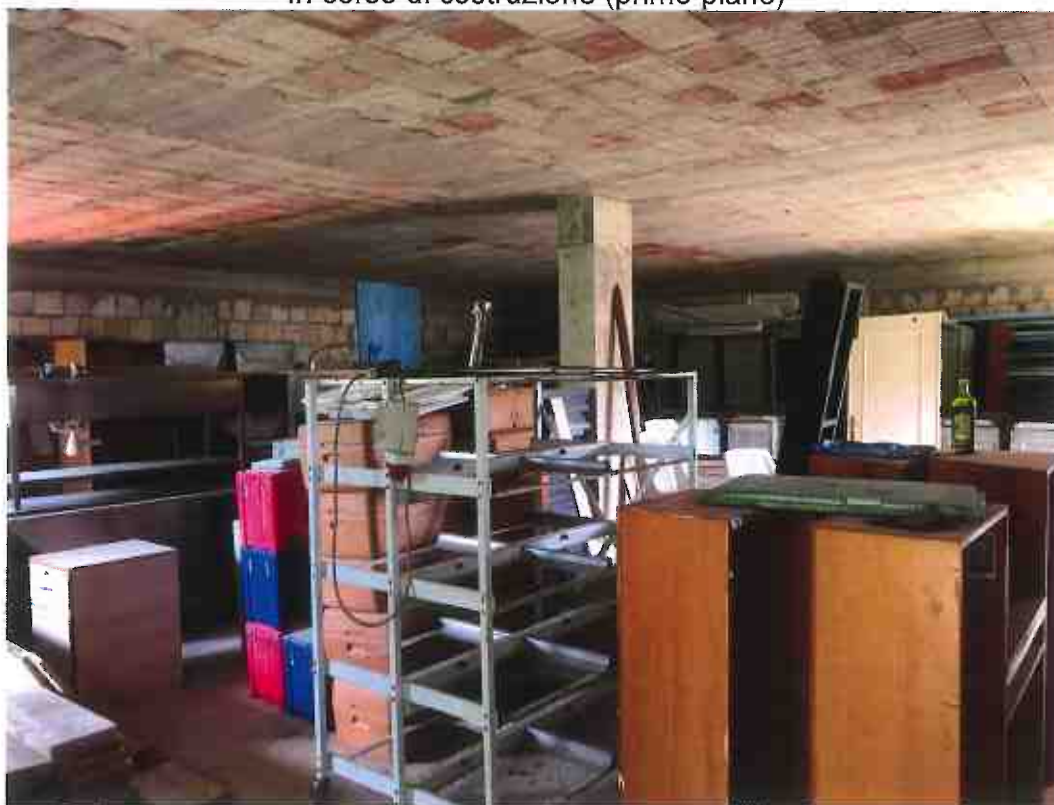
Foto 76 –Terreno con fabbricati in Argusto (lotto 10): interno p. terra edificio in c.so di costruz.
