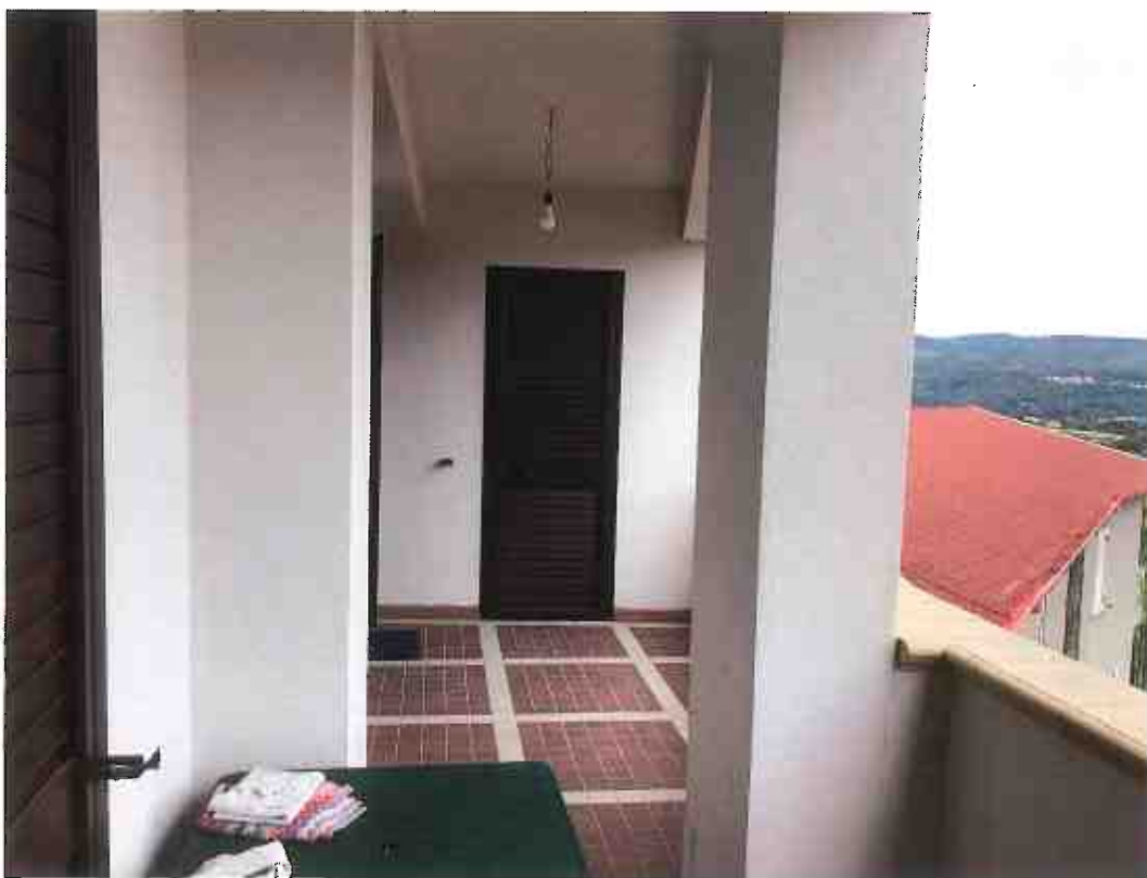
Foto 61 – Abitazione identificata con fg. 34 part. 211 sub 7: balcone (lotto n. 7)
