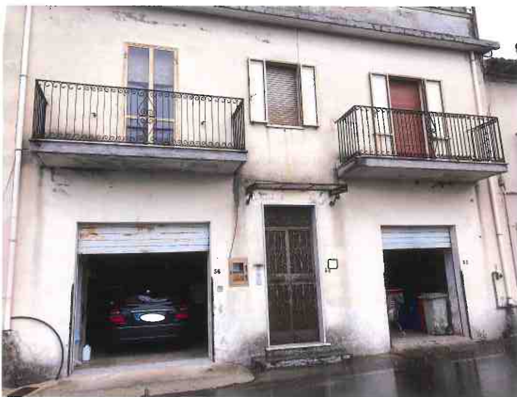
Foto 35 – Fabbricato in Chiaravalle C.le ad abitazione e magazzini / box auto prospiciente la via Nazionale: fg 34 part. 562 (lotto di vendita n. 3)
