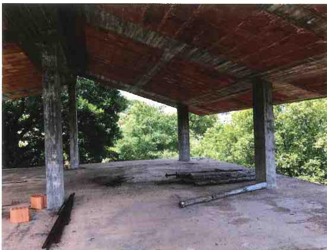
Foto 75 – Terreno in Argusto, loc. “Castagnara” con entrostanti fabbricati (lotto n. 10): edificio in corso di costruzione (primo piano)
