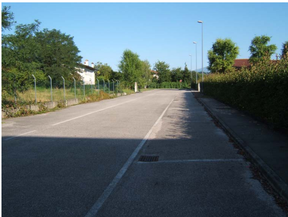
Posizione 12 - strada privata ad uso pubblico - vista in direzione ovest
