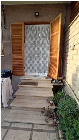
FOTO 51 – DETTAGLIO INFISSI E SCALINATE ESTERNE
