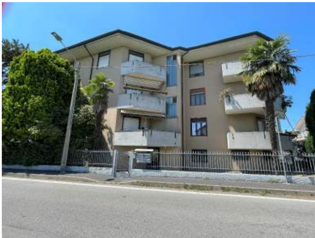
Ingresso da Via Abbiategrasso n.4 – Prospetto Sud
