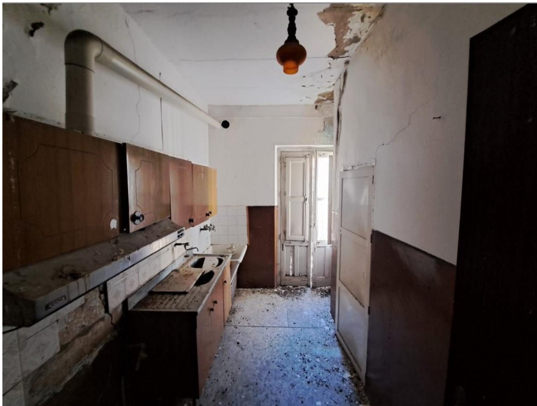
Foto 11 – Interno alloggio (secondo piano), seconda stanza (cucina)
