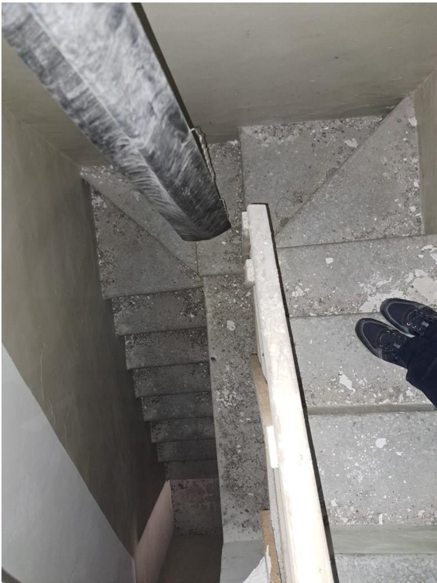
Foto 14 – vano scala interno all'alloggio
