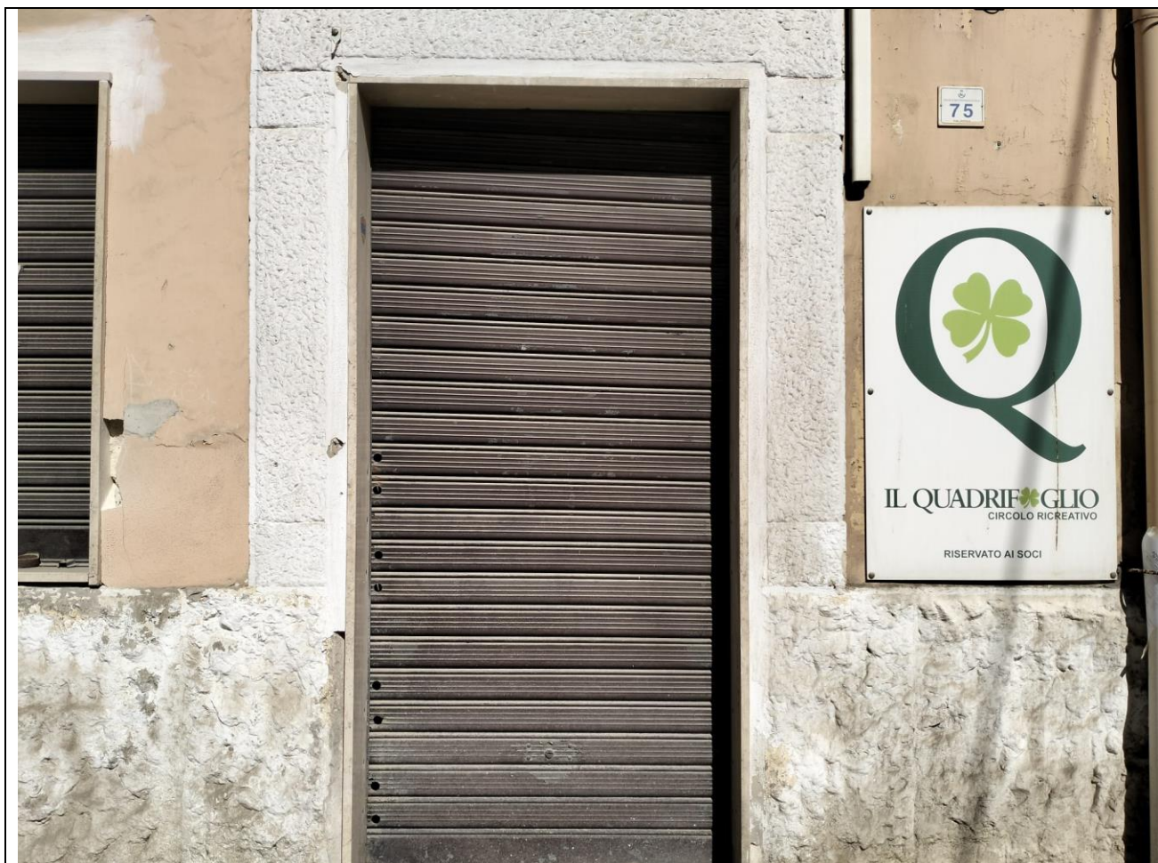
15 – Ingresso al negozio sito al civico 75 di via Roma in San Ferdinando di Puglia (BT)
