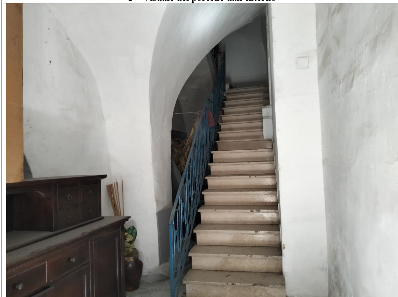
4 – Ingresso e rampa di scale che porta all'abitazione
