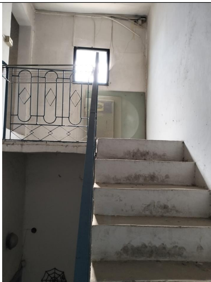
11 - Scale che portano al terrazzo di copertura in secondo piano
