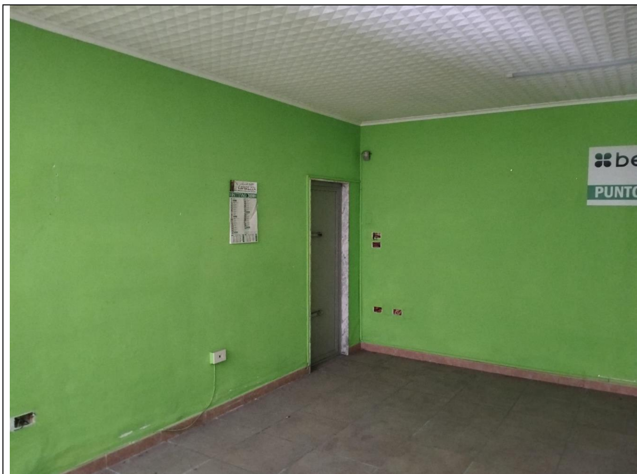
19 – Prima porta che andrà murata per separare il negozio (Lotto 1) dall’abitazione (Lotto 2)
