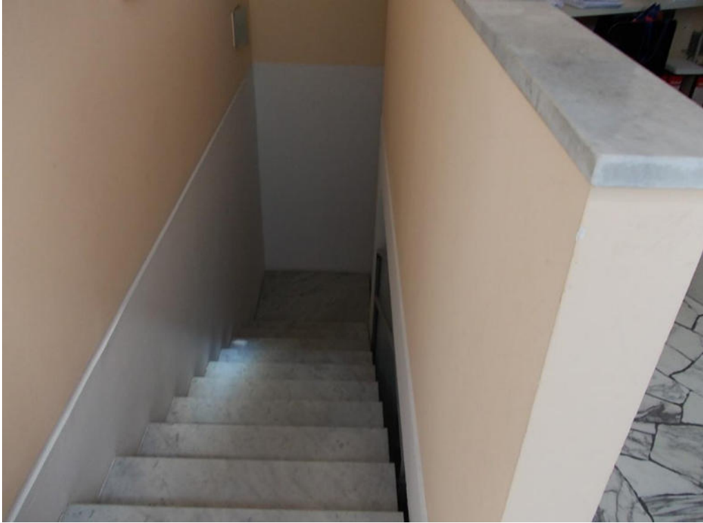
Foto 9 Scala accesso al piano S1
