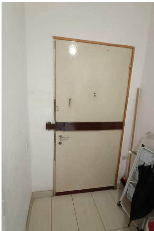
Foto 12 – Portoncino ingresso vista interna
