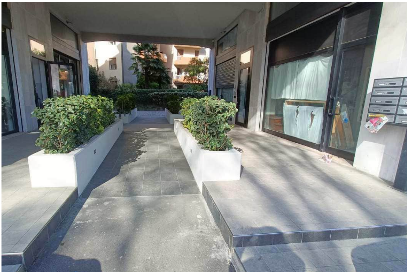
Foto 3 – Portico condominiale prospetto Est
