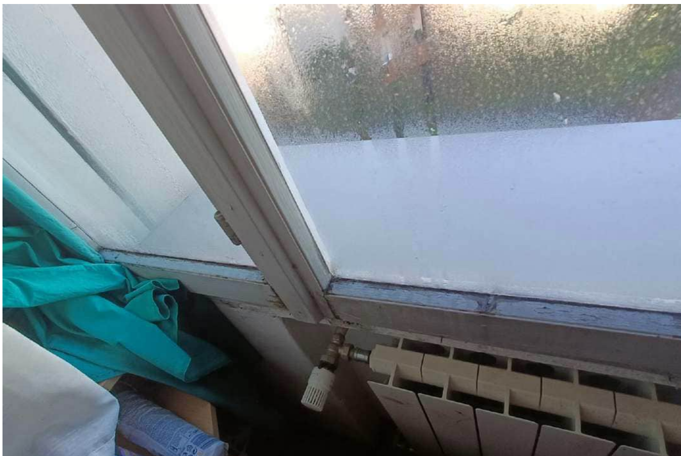
Foto 32 – Dettaglio serramenti interni
