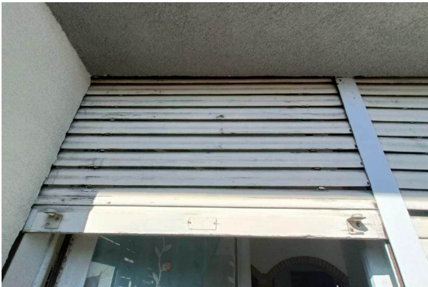
Foto 33 – Dettaglio serramenti esterni
