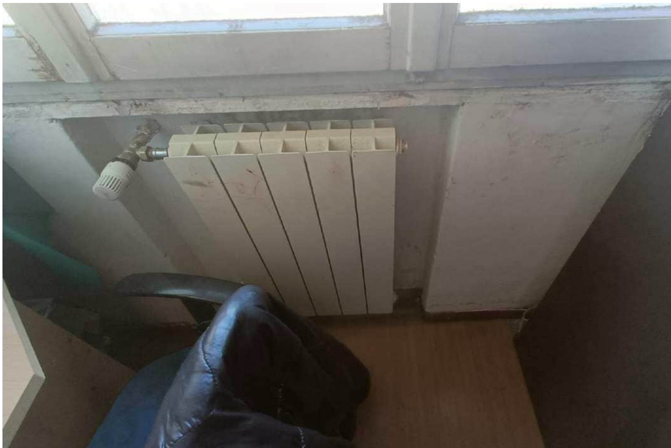
Foto 34 – Dettaglio nicchia radiatori
