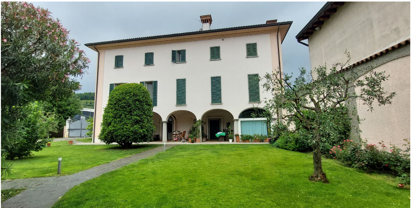
Vista abitazione da giardino comune
