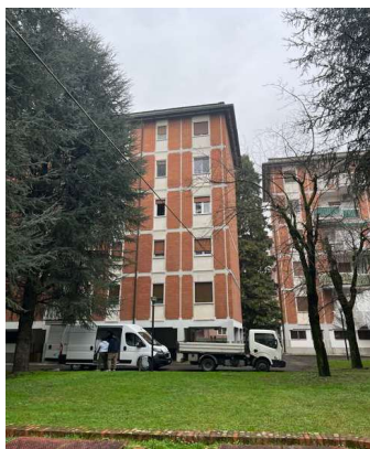
1 - fronte fabbricato lato ingresso
