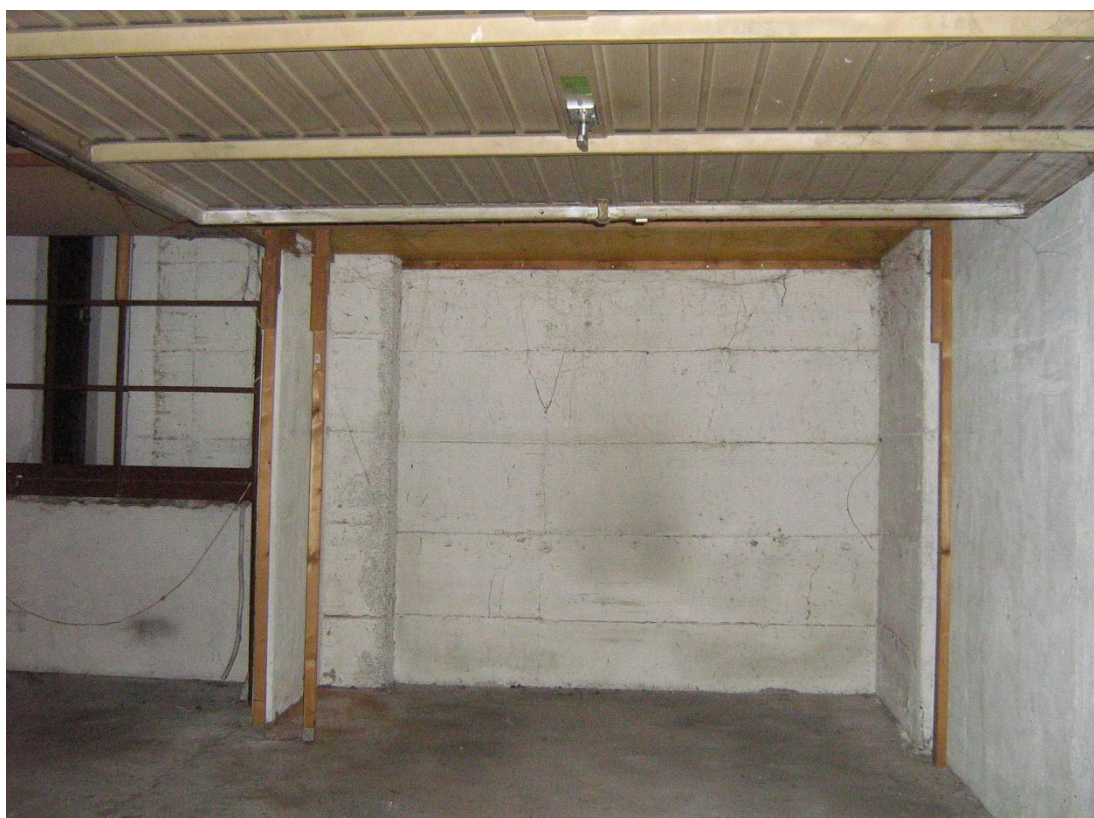
Figura 20 - Vista dell'altro box adiacente al piano interrato
