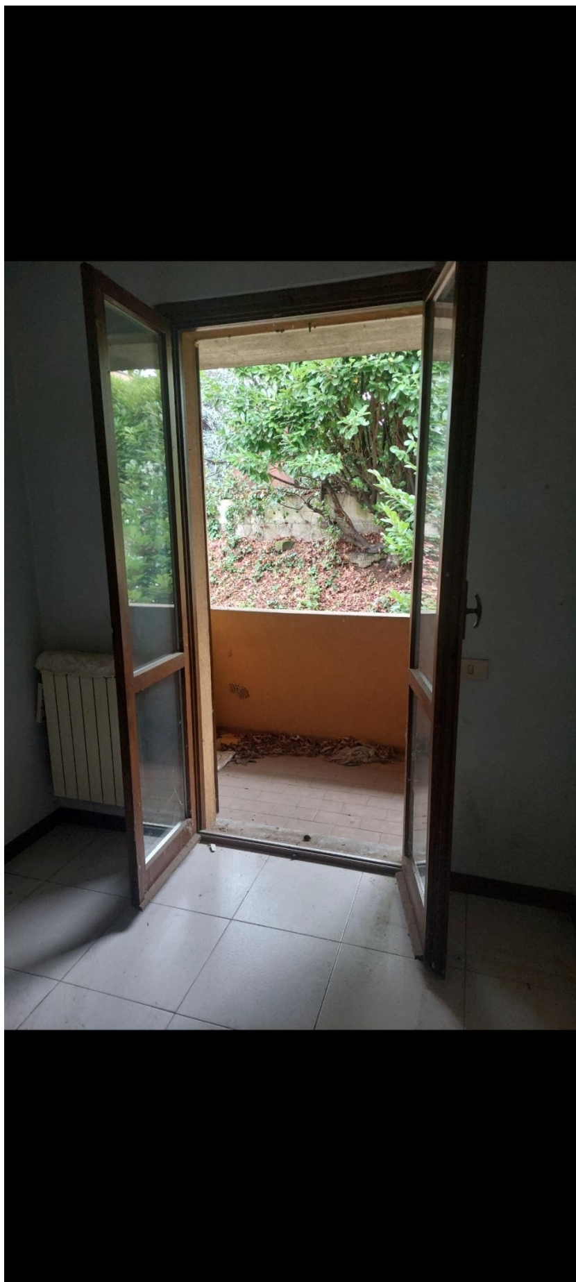
Figura 13 - Vista della camera ad est al piano primo
