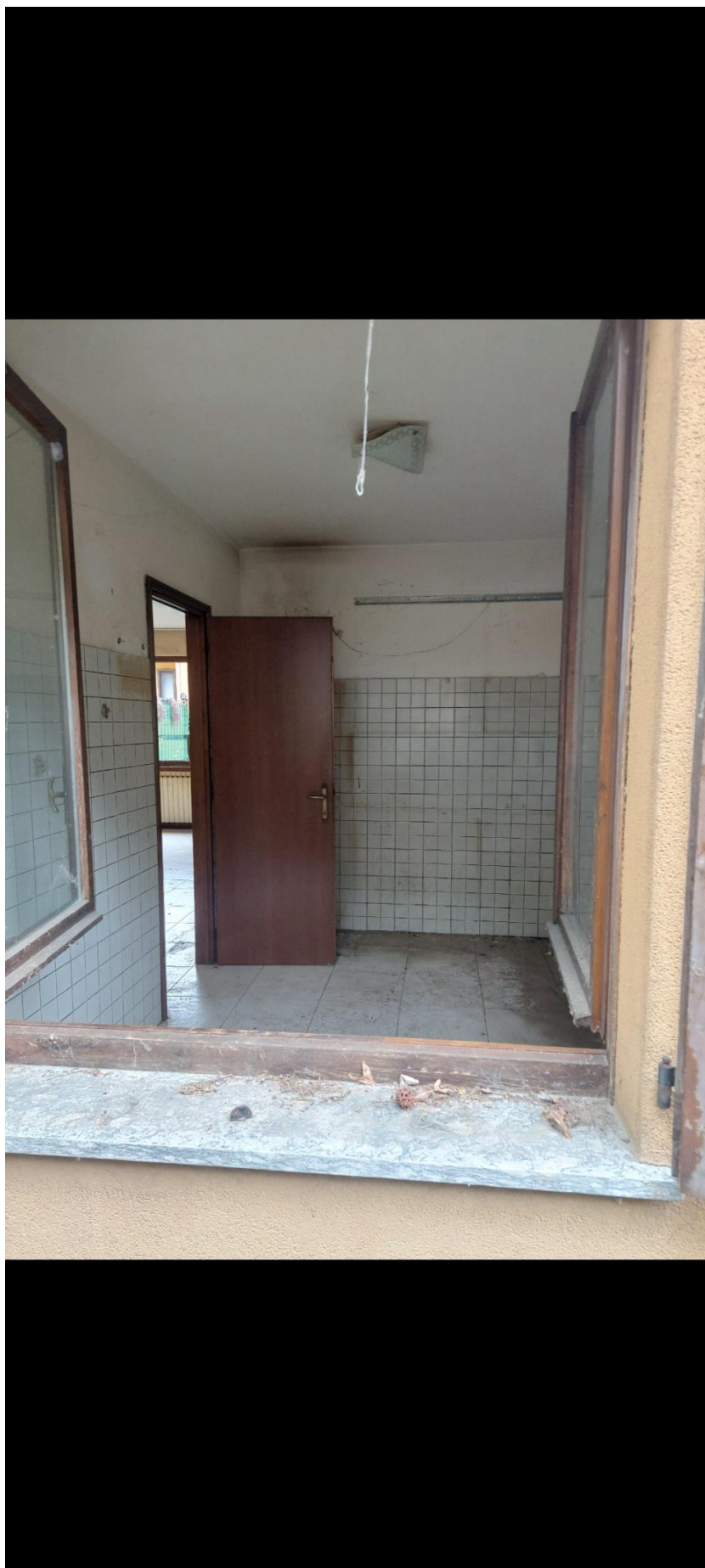
Figura 9 - Vista della cucina al piano rialzato
