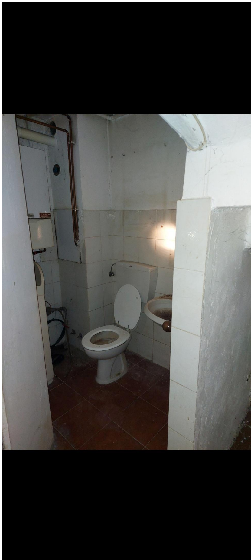
Figura 18 - Vista del servizio al piano interrato
