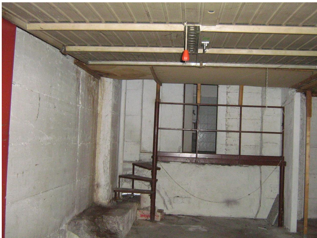
Figura 19 - Vista del box al piano interrato
