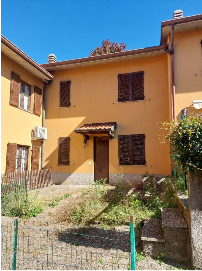
Figura 1 - Prospetto ovest con vista dell'area comune esclusiva antistante
