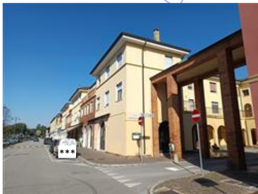
Vista Sud-Est condominio e della viabilità di accesso (Via Roma - Via Isonzo)
