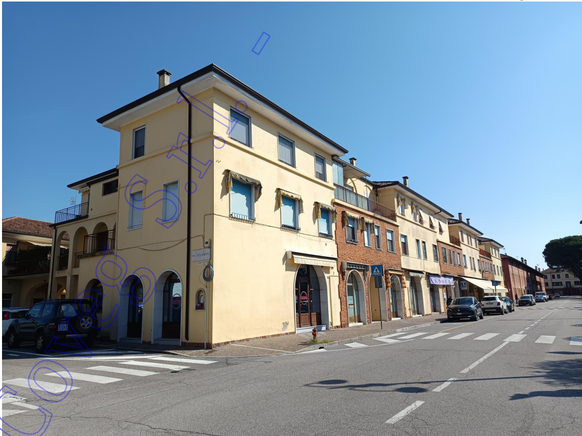
Vista Sud – Ovest del Condominio Roma e della viabilità di accesso (Via Roma e Via Tagliamento)
