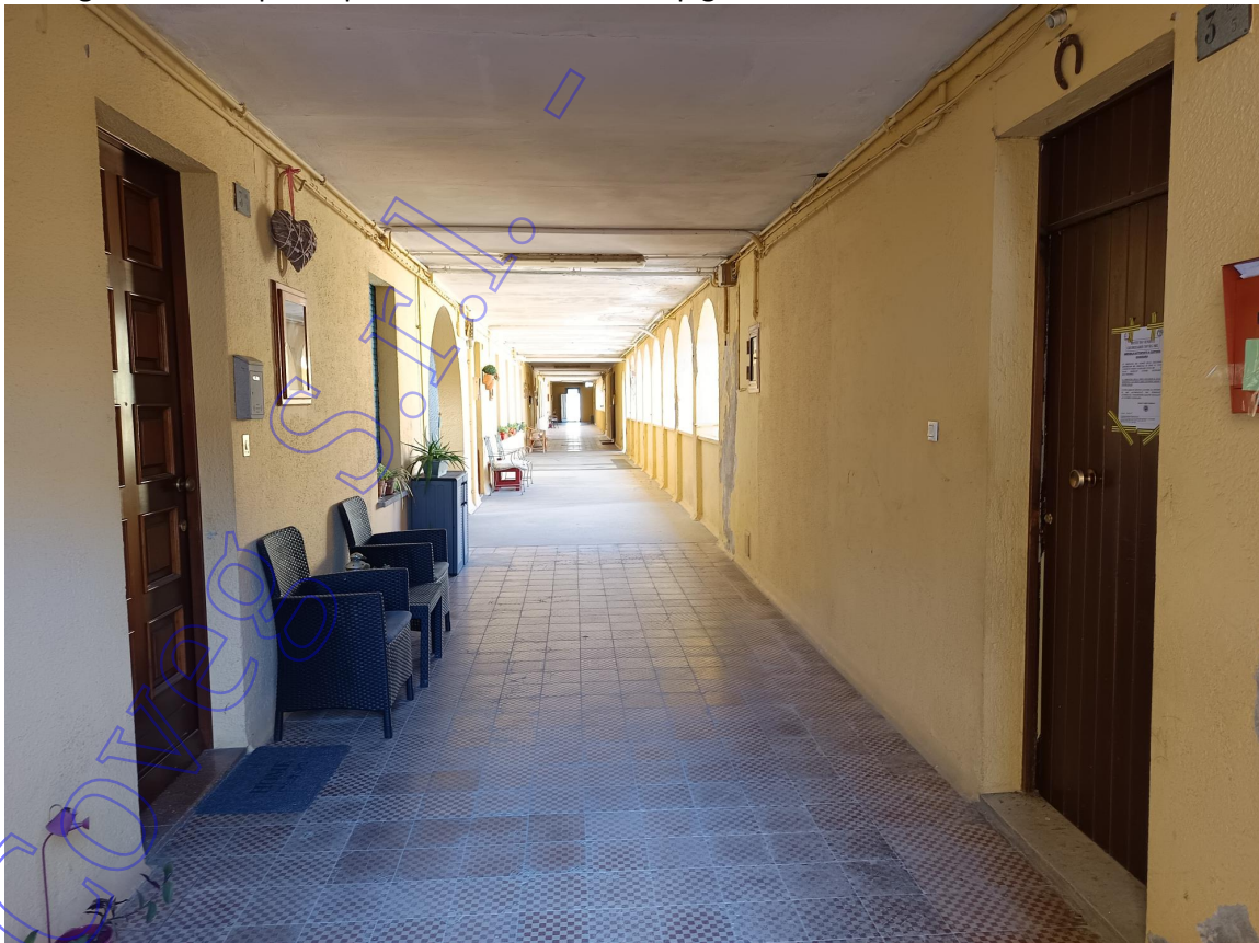
Dettaglio corridoio primo piano di accesso all'unità pignorata
