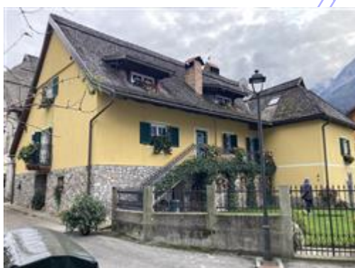
vista scala esterna
