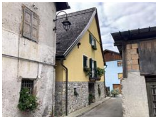
vista esterna - facciata nord
