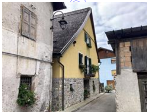
vista esterna - facciata nord
