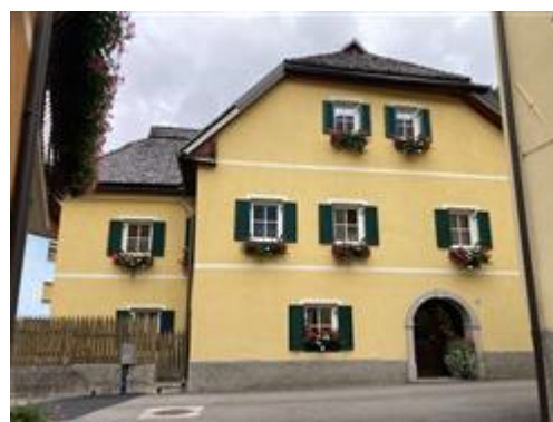
vista esterna da via Bambergia - facciata sud
