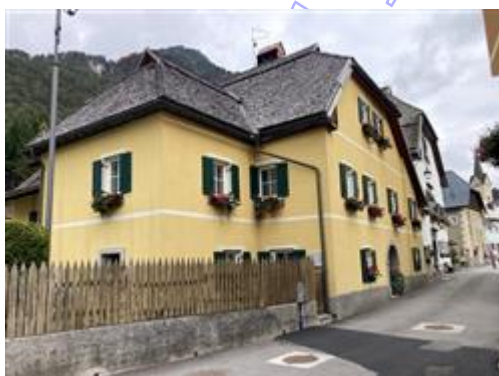
vista esterna da via Bamberga - facciata sud-ovest
