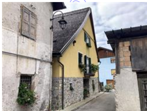
vista esterna - facciata nord
