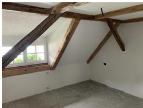
vista interna della camera
