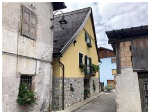
vista esterna - facciata nord
