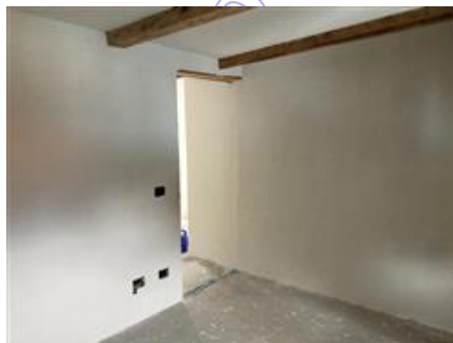
vista interna della camera
