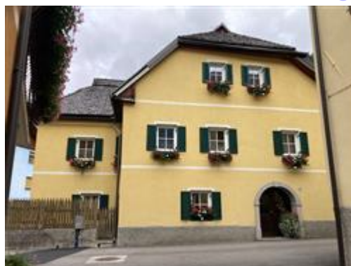
vista esterna da via Bamberga - facciata sud
