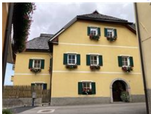
vista esterna da via Bambergia - facciata sud
