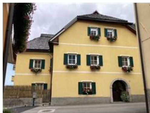
vista esterna da via Bamberga - facciata sud
