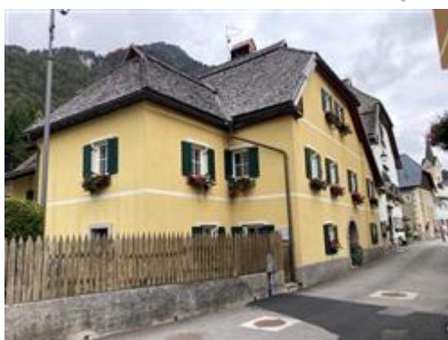
vista esterna da via Bambergia - facciata sud-ovest
