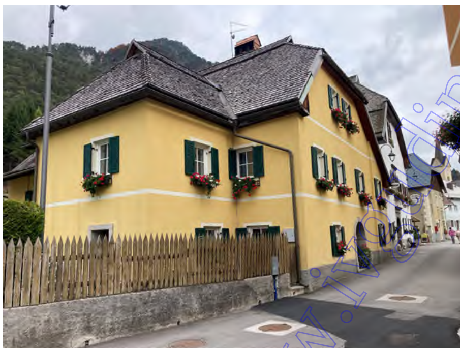
Vista fronte sud-ovest
