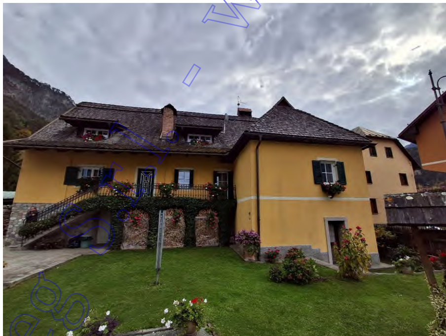
Vista fronte ovest
