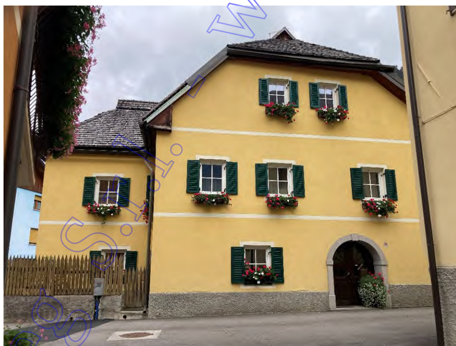
Vista fronte sud
