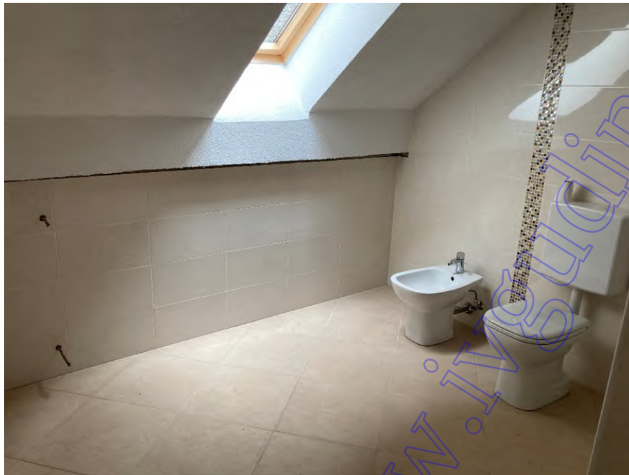
Vista bagno p.1°
