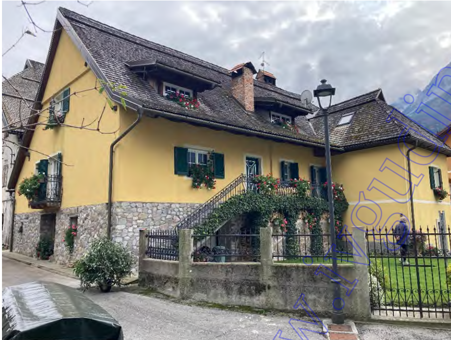
Vista scala ingresso al piano primo e sottotetto
