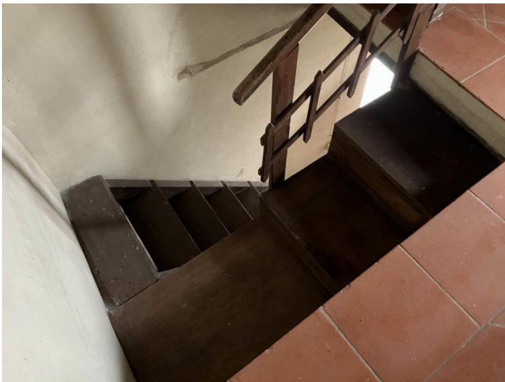
Foto 14 – Interni – Camera - Piano 2° - Particolare scala
