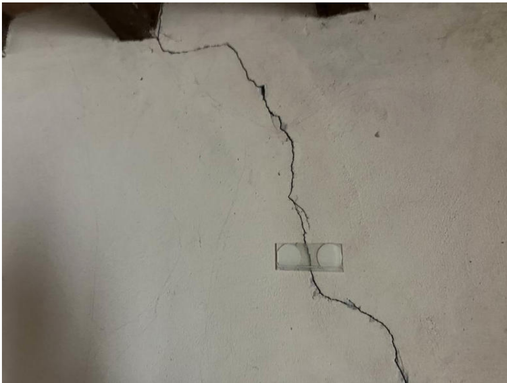
Foto 19 – Interni – Camera - Piano 2° - Particolare vetrino spia
