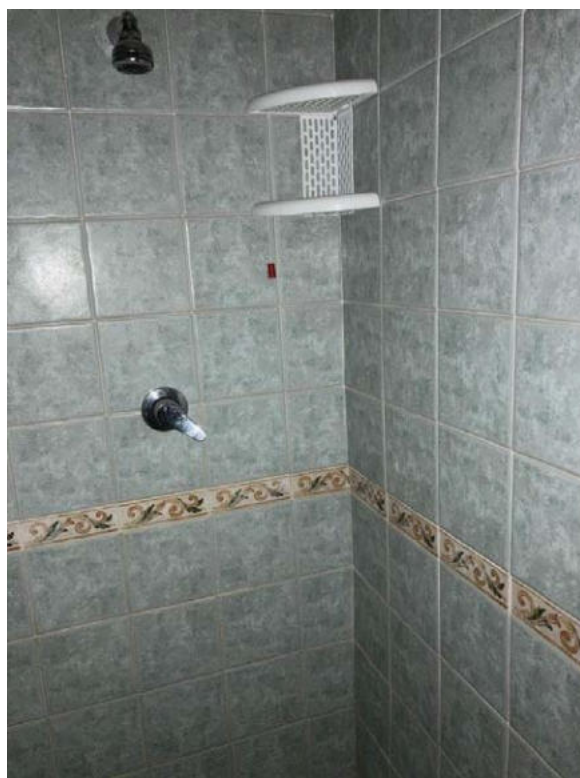
Foto 13 – Interni – W.c.- Piano 1°
