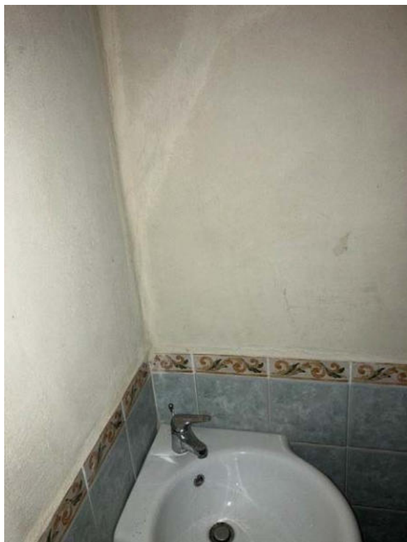
Foto 11 – Interni – W.c.- Piano 1°
