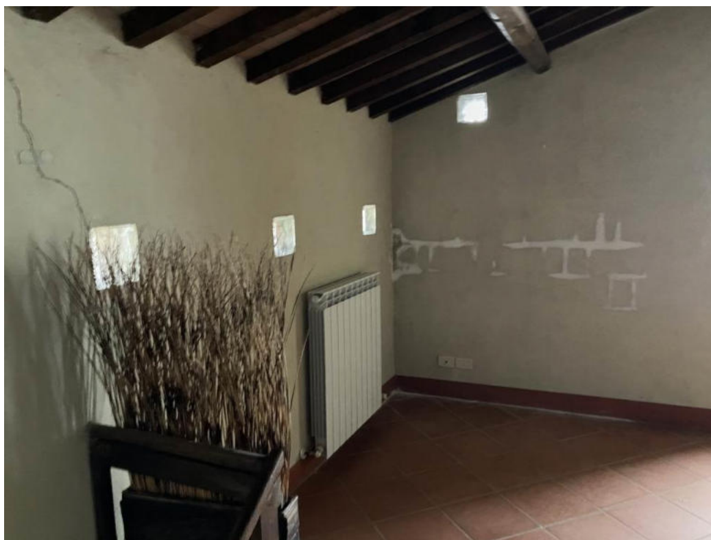
Foto 14 – Interni – Camera - Piano 2°
