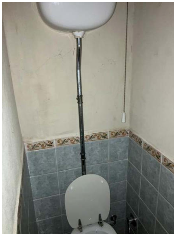
Foto 12 – Interni – W.c.- Piano 1°
