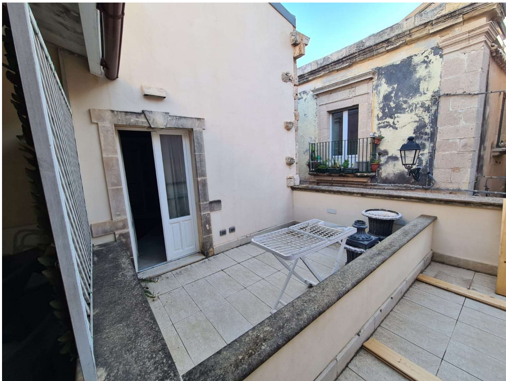
Finestrone accesso Terrazzino
