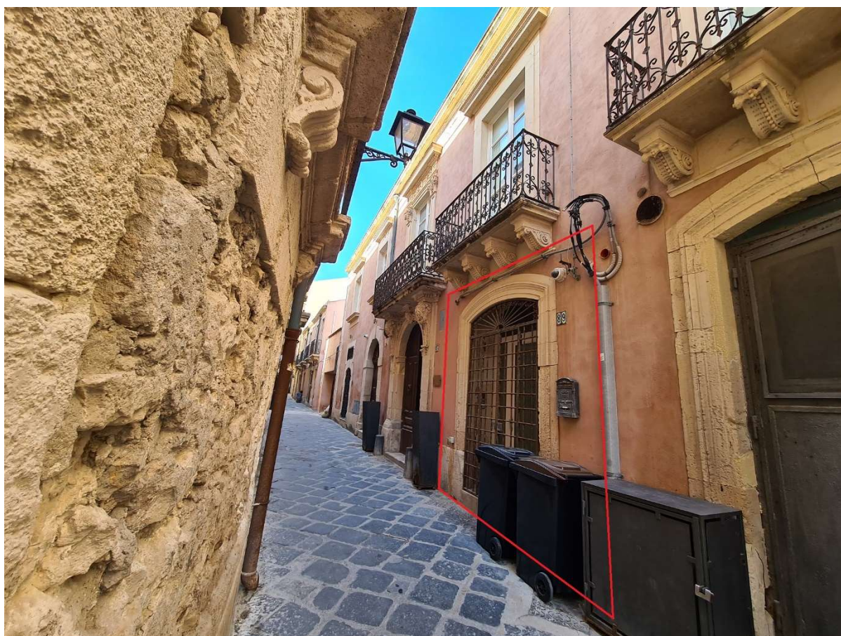
Identificazione Immobile - Ingresso da via Alagona – portone con cancellata
