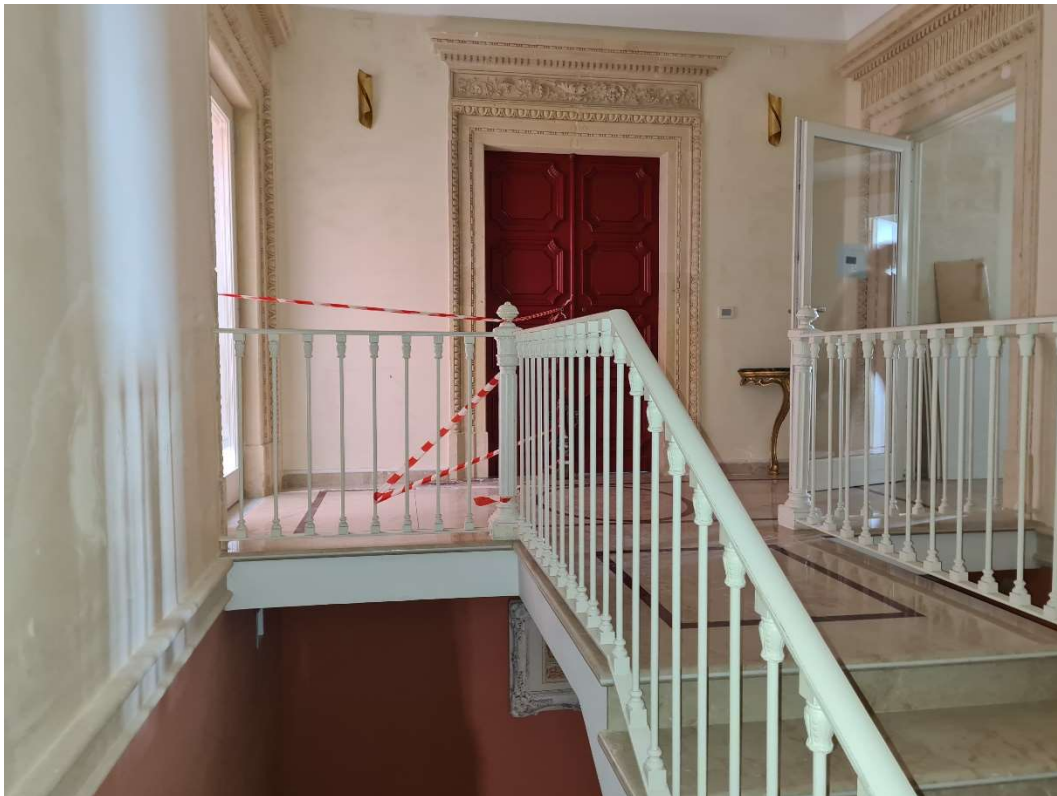
Pianerottolo primo piano vano scale comune – a destra porta accesso immobili pignorati
