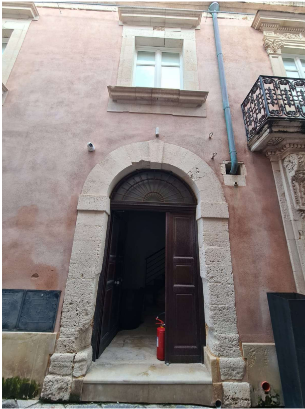
Ingresso da pianerottolo
