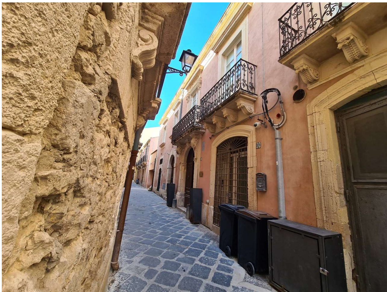
Particolare ingressi da via Alagona
