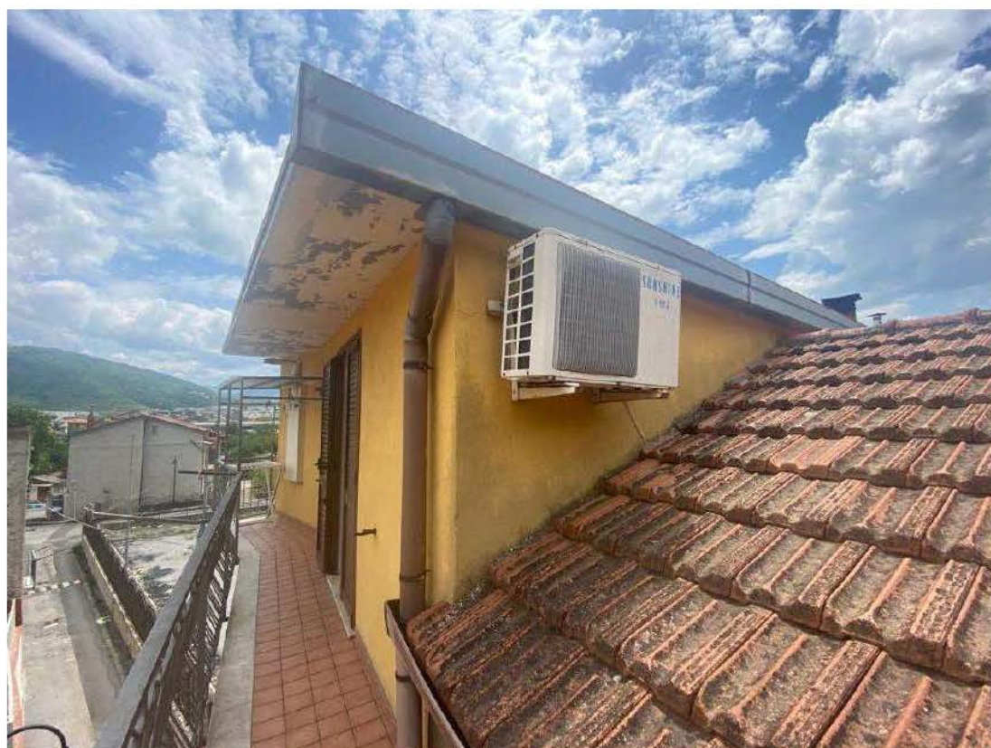
Foto n. 56: Balcone prospettante ad ovest in II Piano (sottotetto)
