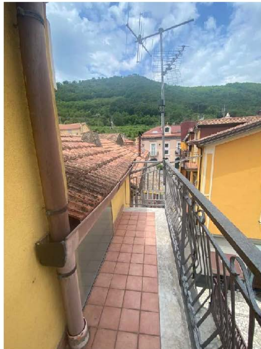
Foto n. 60: Balcone prospettante ad ovest in II Piano
