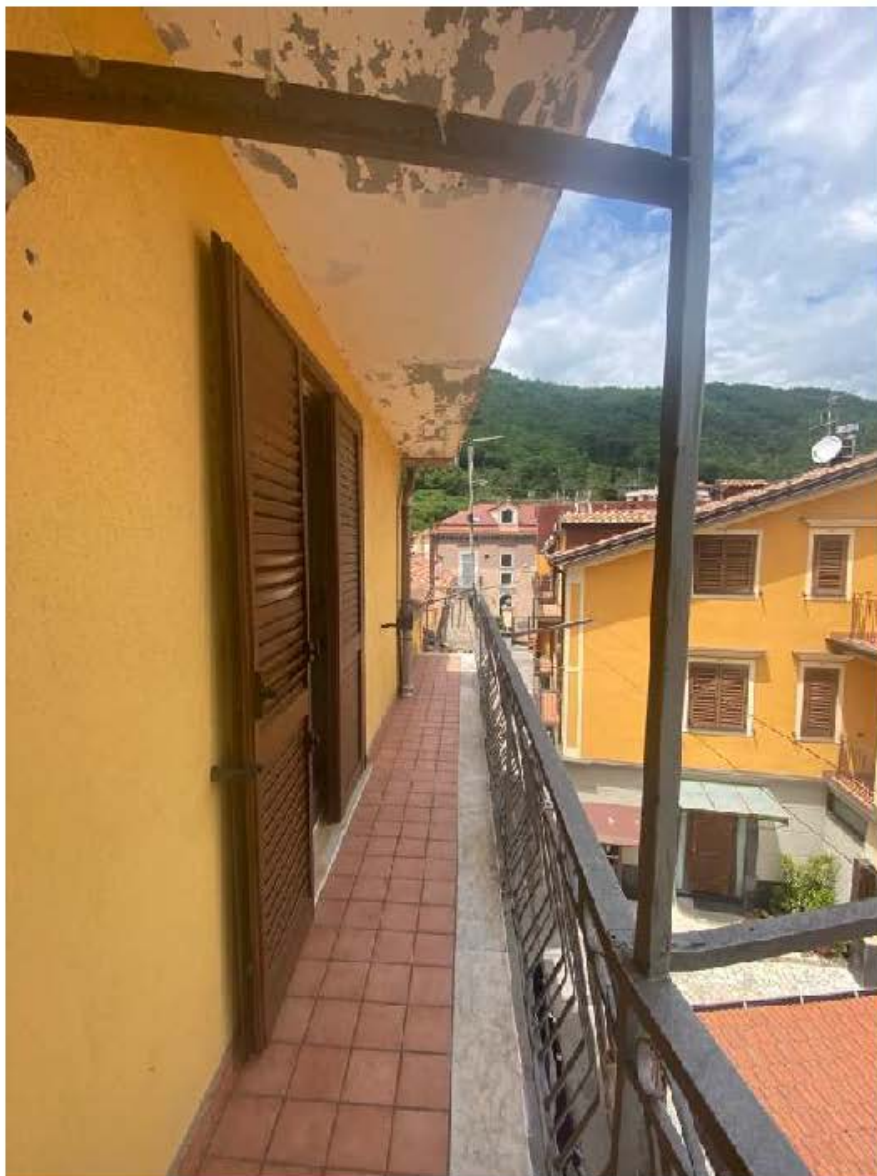
Foto n. 59: Balcone prospettante ad ovest in II Piano
