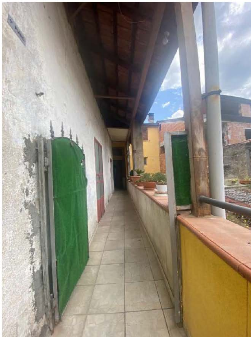
Foto n. 17: Corridoio comune di accesso
