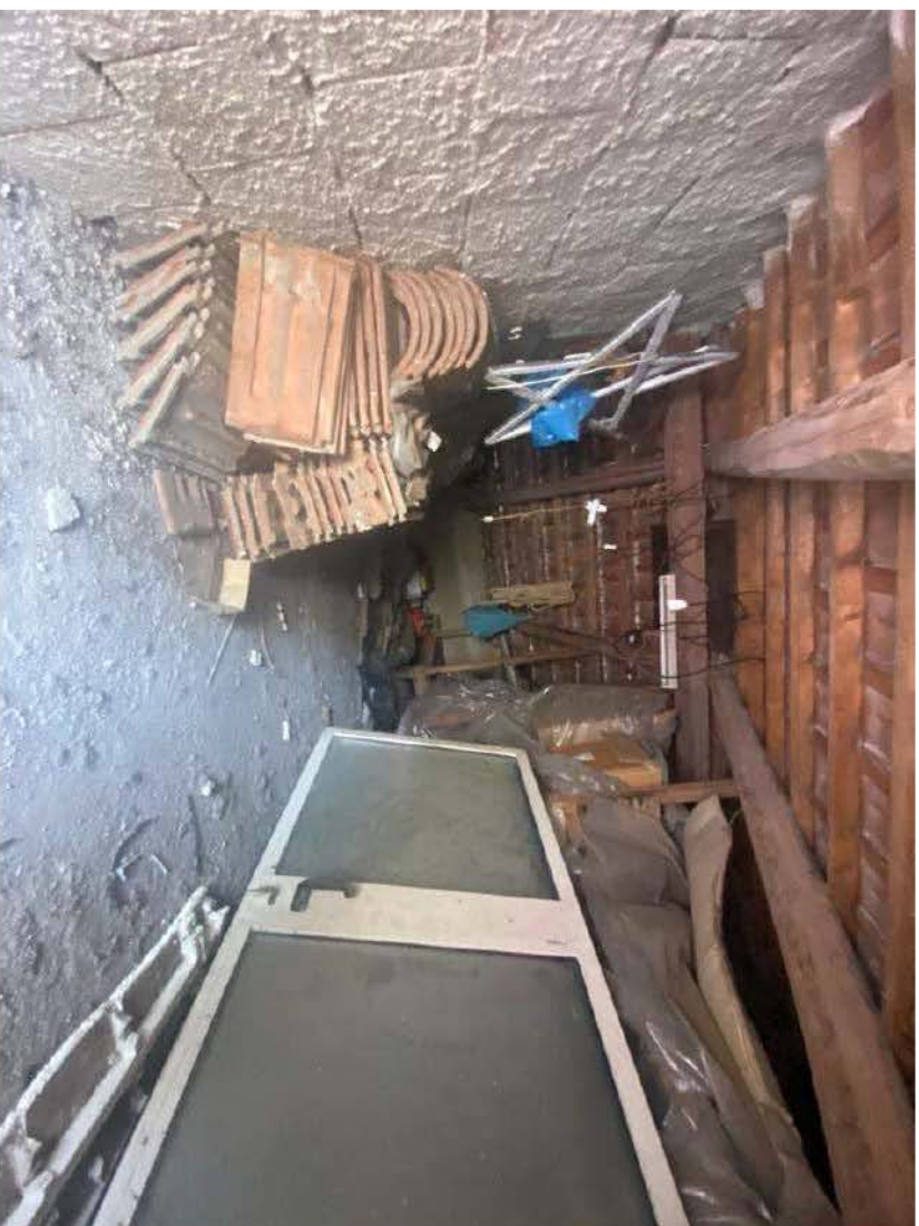
Foto n. 64: Locale sottotetto con accesso dal balcone ad ovest in II Piano
