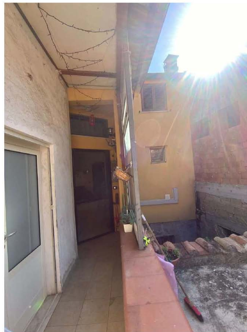
Foto n. 18: Accesso all' appartamento pignorato in I Piano
