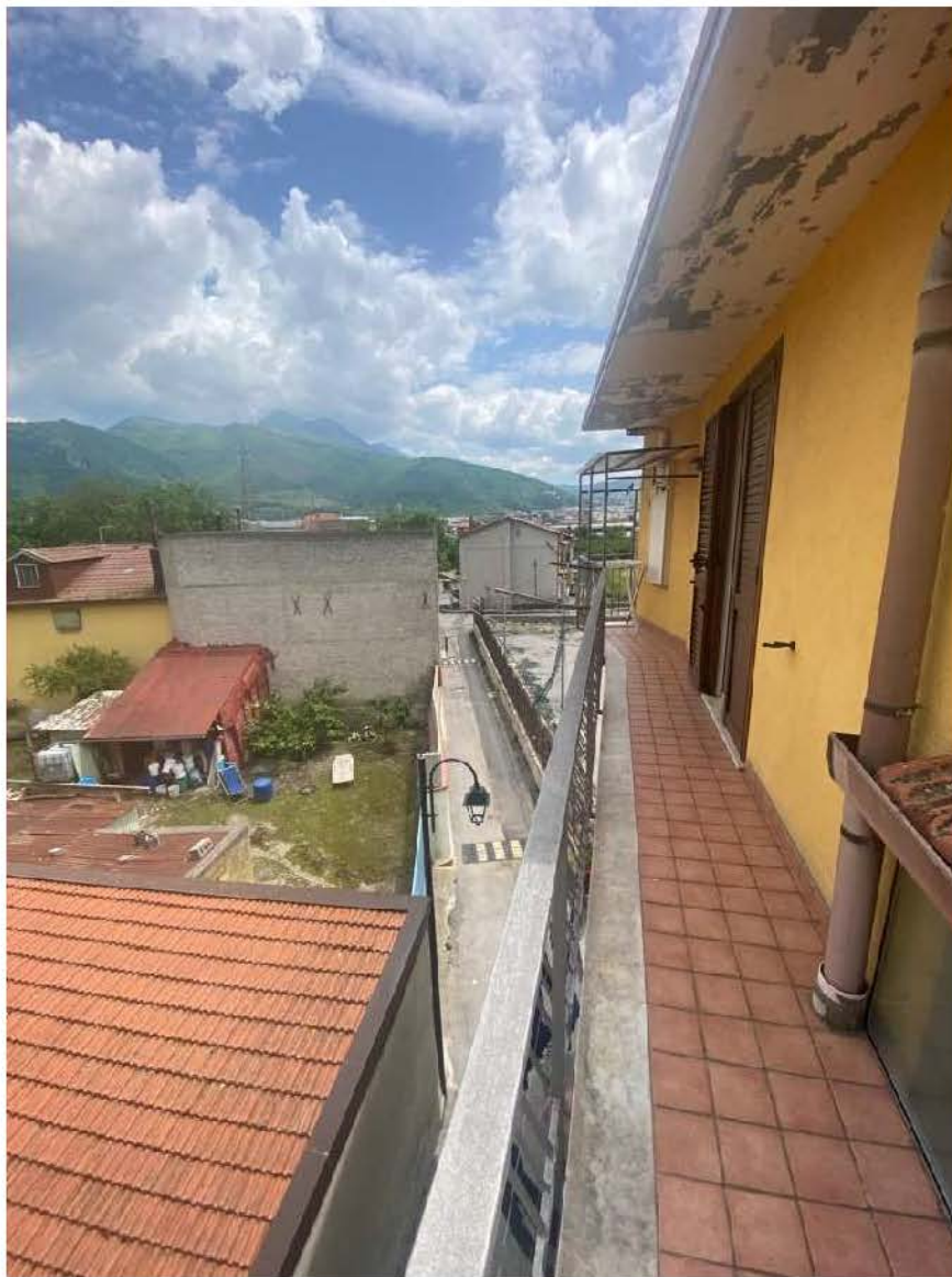
Foto n. 57: Balcone prospettante ad ovest in II Piano
