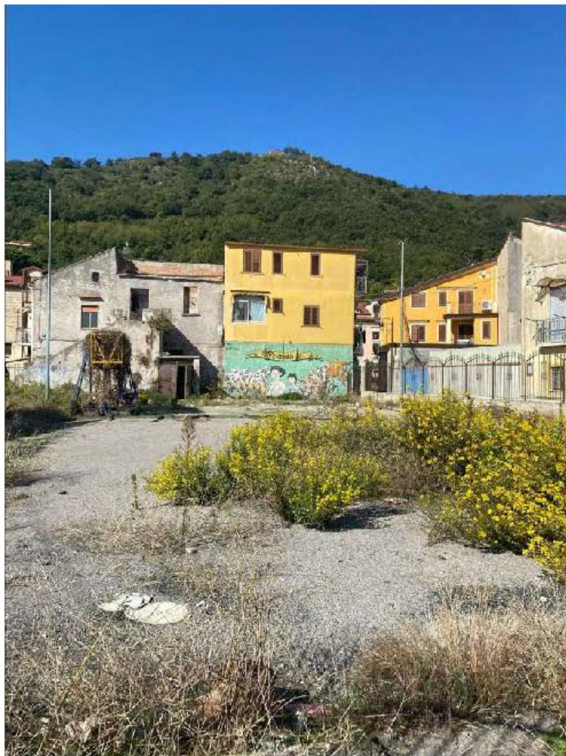
Foto n. 5: Fronte nord dell' immobile in oggetto con accesso da Vico Bernardino Pignataro, 4 a Mercato San Severino (Sa)
