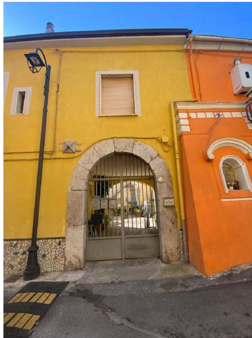
Foto n. 14: Accesso al civico 4 di Vico Bernardino Pignataro
