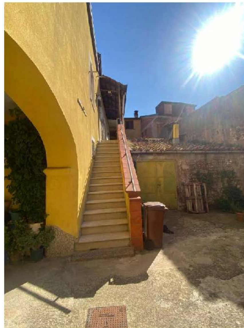
Foto n. 16: Scale comuni di accesso
