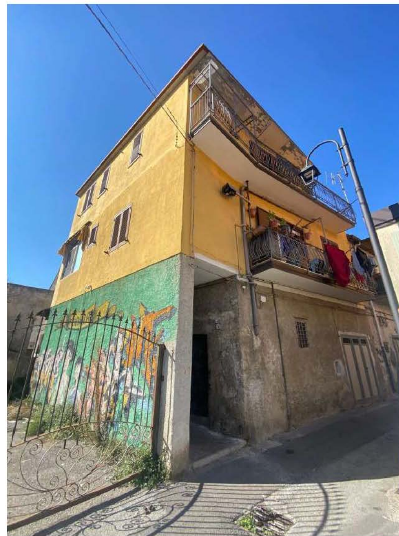
Foto n. 10: Angolo nord-ovest del fabbricato che ospita il bene in esame in I-II Piano
