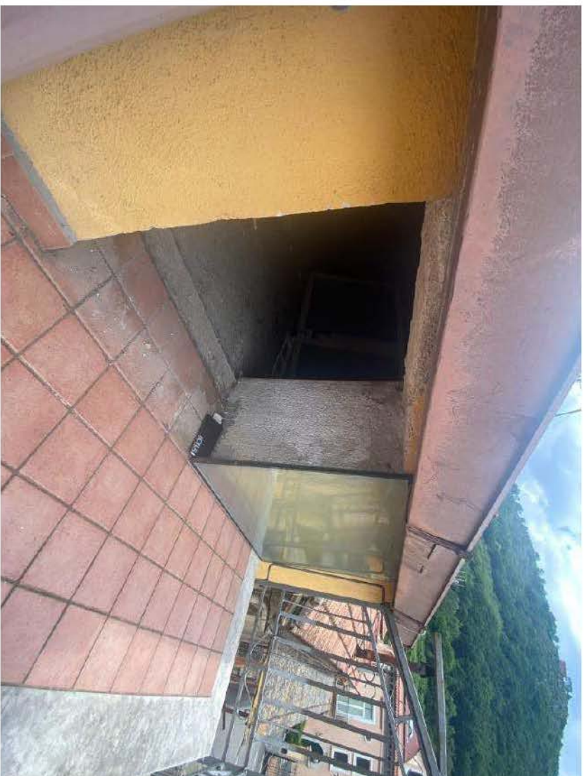
Foto n. 63: Sottotetto con accesso dal balcone prospettante ad ovest in II Piano
