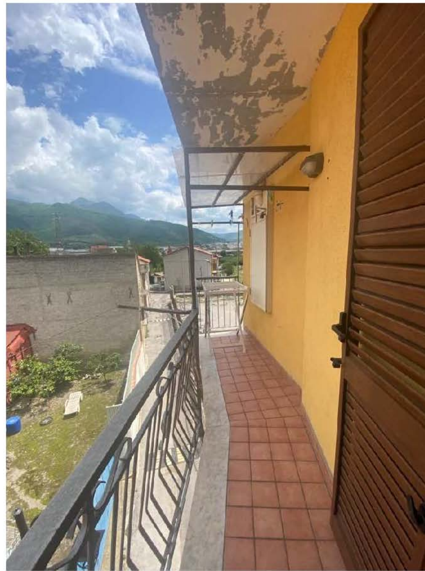
Foto n. 58: Balcone prospettante ad ovest in II Piano
