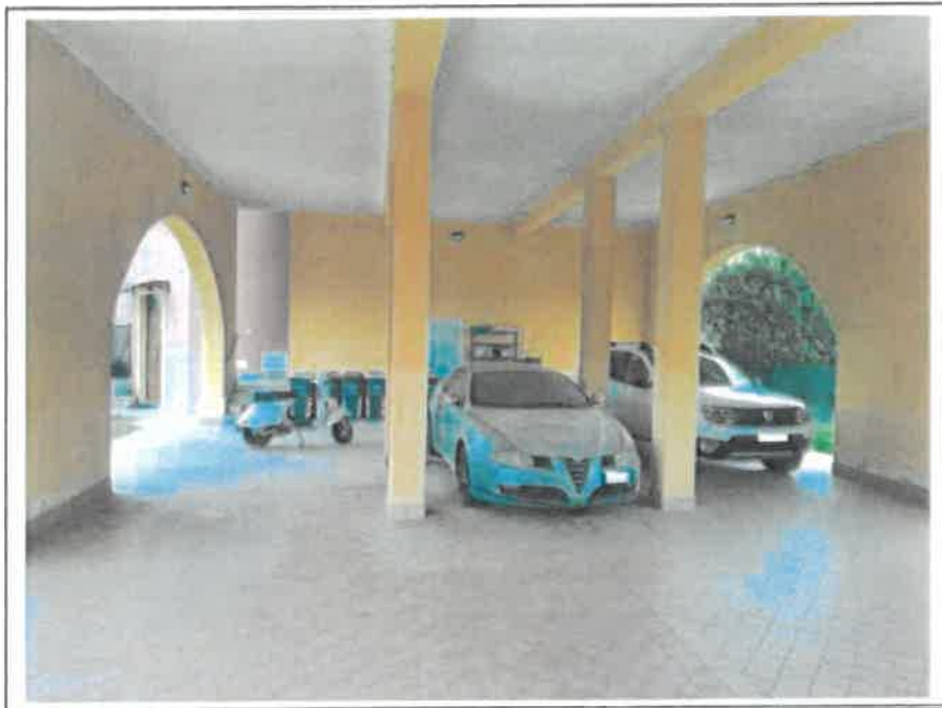
Foto n. 10 – Vista posto auto coperto
