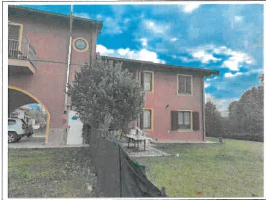
Foto n. 2 – Vista esterno fabbricato in oggetto - Retro
