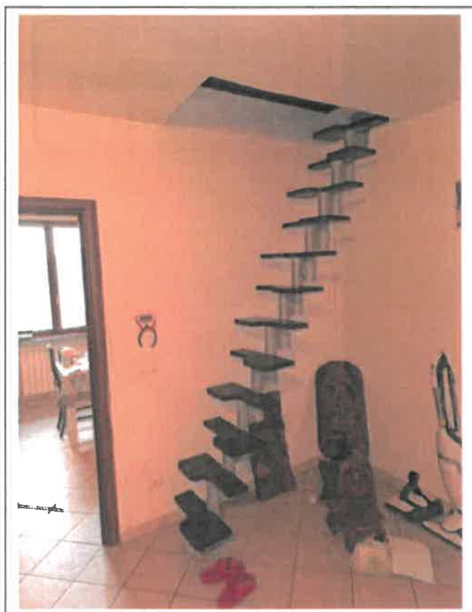
Foto n. 8 – Vista interno fabbricato in oggetto – Scala accesso sottotetto -
