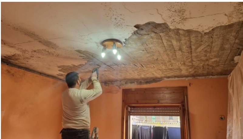
Foto n.2: fase lavorativa di spicconatura succielo camera da letto
