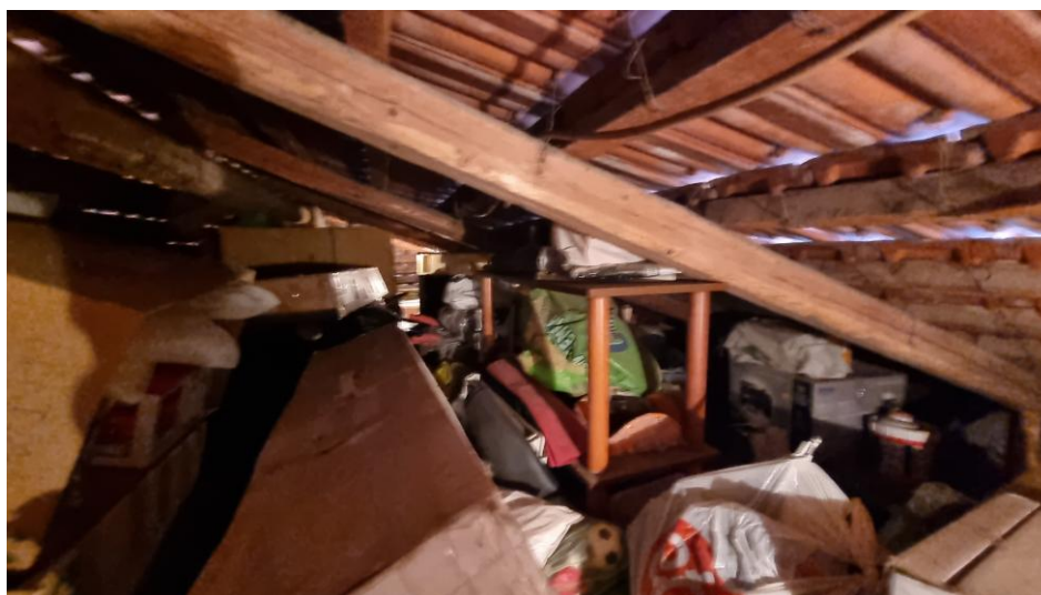
Foto n.29: sottotetto piano terzo
