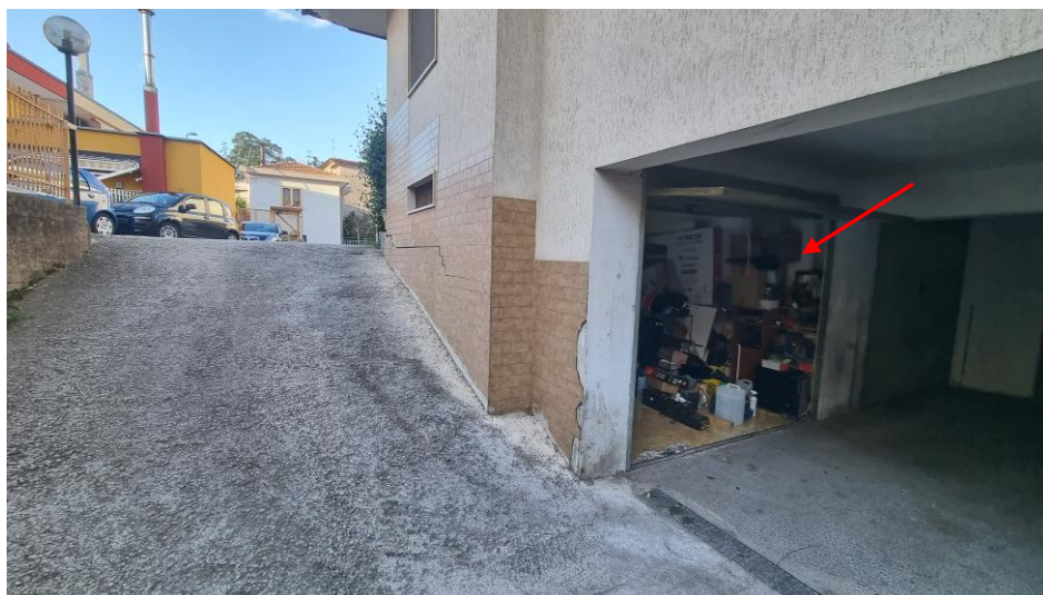
Foto n.30: discesa box-garage con indicazione del garage di proprietà dei debitori executati
