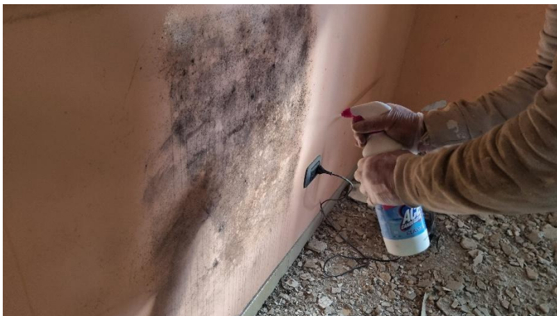
Foto n.3: trattamento antimuffa pareti camera da letto
