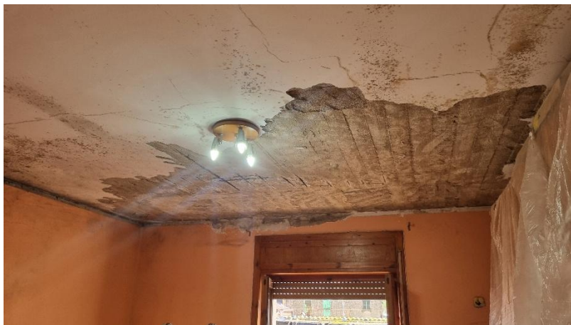
Foto n.1: porzione di succielo della camera da letto oggetto di spicconatura
