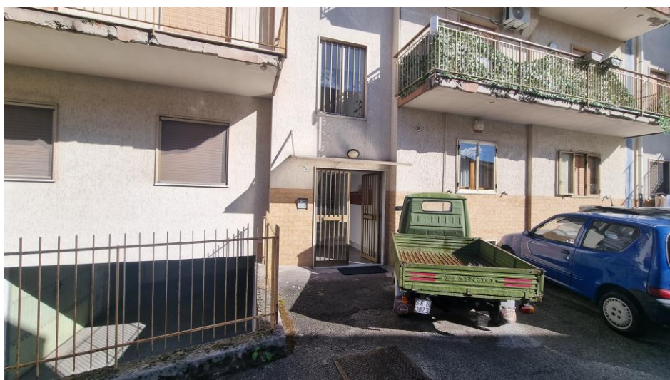
Foto n.3: portone di ingresso alla Scala A
