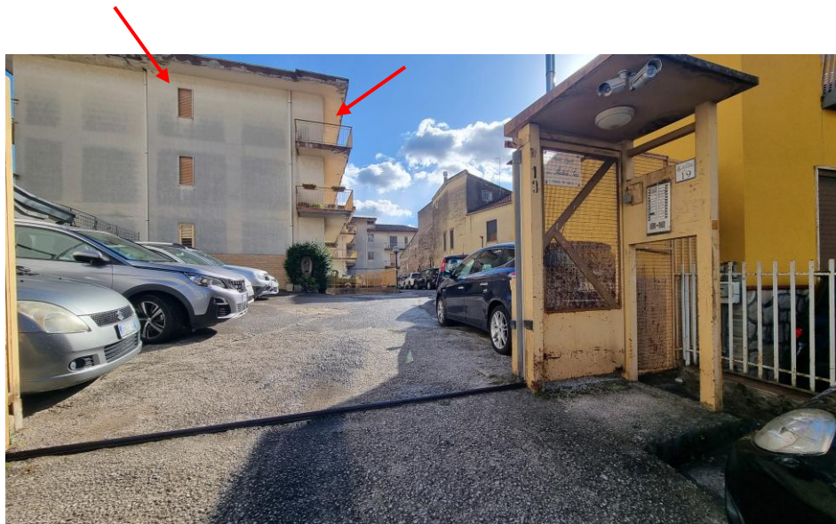
Foto n.1: Condominio Landi, Via IV novembre n.19 Fisciano – accesso all'area esterna con indicazione dell'u.i. pignorata appartenente alla scala A.
