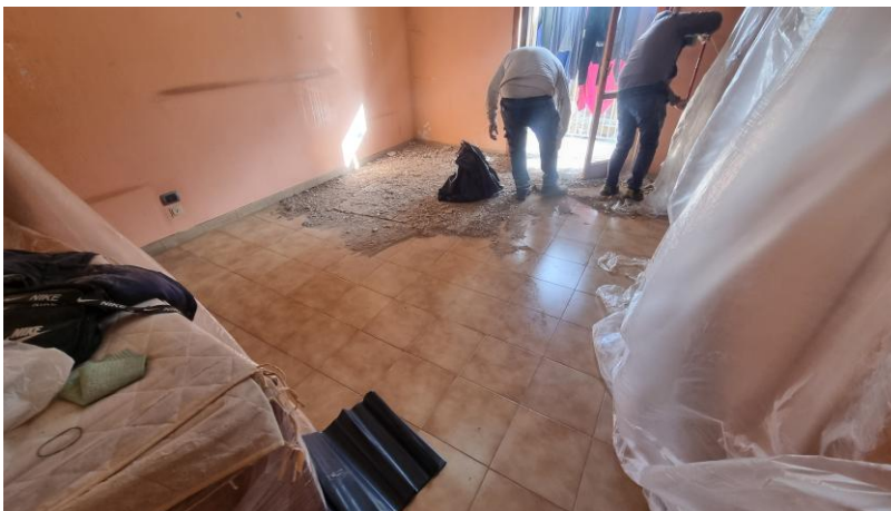
Foto n.5: pulizia dell'area di cantiere
