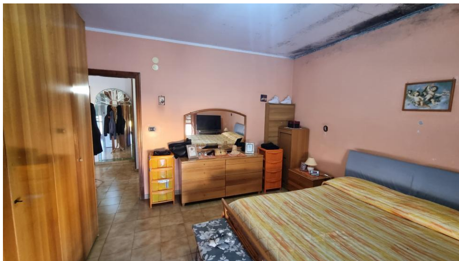
Foto n.18: camera 3 – angolazione opposta foto precedente
