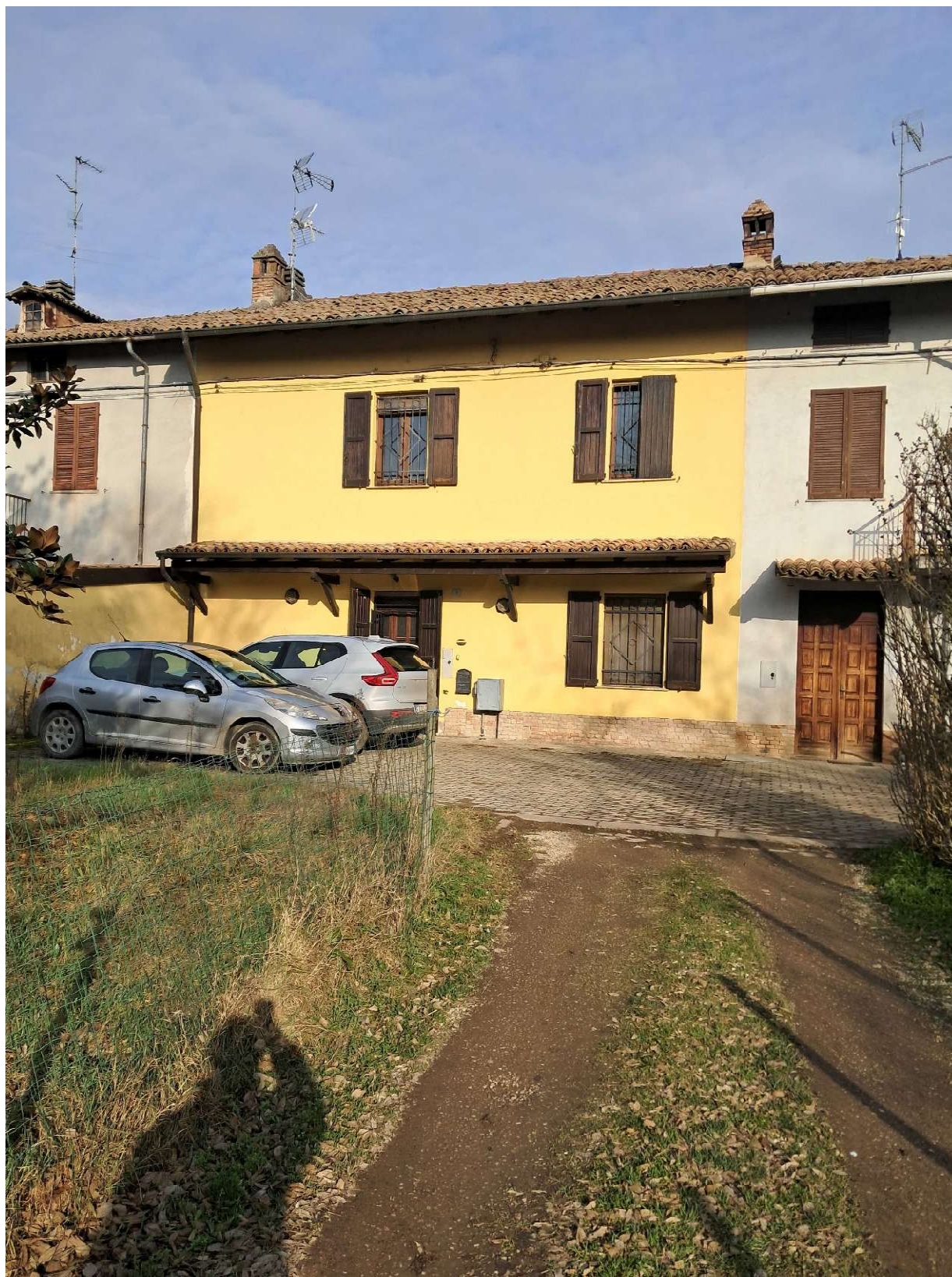
FACCIATA LATO SUD
