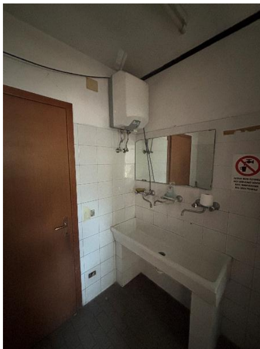
ANTIBAGNO WC CAPANNONE
