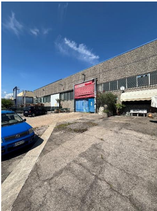
PIAZZALE – AREA DEPOSITO
