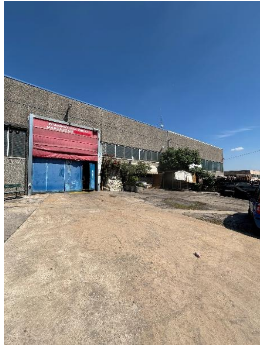
PIAZZALE – AREA DEPOSITO
